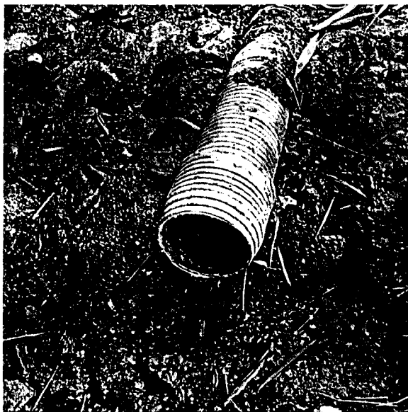
FOTO 13. Detalle enrocado de entrega del filtro y descole
