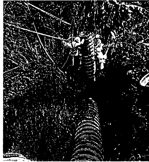
FOTO 8. Complemento de la anterior con retiro de la tubería existente.
