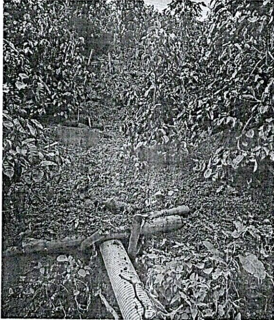
FOTO 7. Red de entrega domiciliarias de la ladera opuesta sobre vía a Vda. Trocaderos
