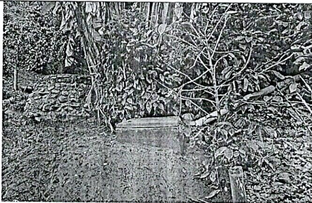
FOTO 9. Conexión domiciliaria a caja de inspección
