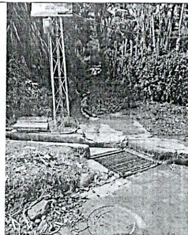
FOTO 2. Punto de colección de aguas superficiales para transversal y alcantarillado de ARD
