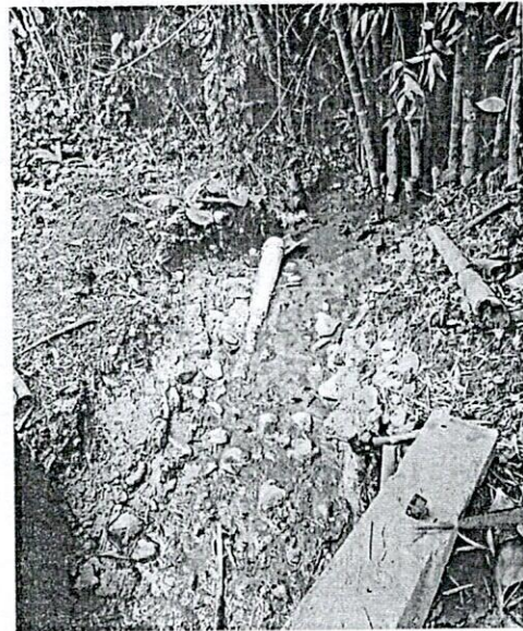
FOTO 6. Detalle de la zona de descole de las aguas colectadas por la nueva red
