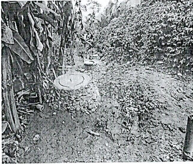
FOTO 11. Detalle construcción cámaras y realces cámaras en concreto ciclópeo
