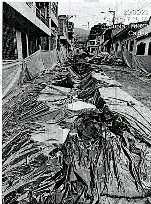
Fotografía 4. Acciones para evitar empozamiento por las lluvias.
