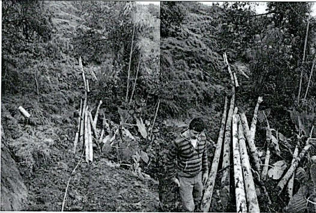
Fotos 2 y 3. Alineación e instalación de la tubería de 8" para el tramo afectado ✓
