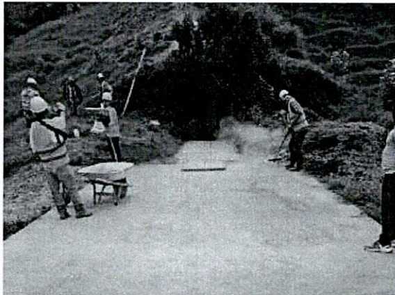
Ilustración 6,7,8 Contrato 312 "OBRAS DE ALCANTARILLADO EN EL BARRIO MEDELLIN EN EL MUNICIPIO DE NEIRA CALDAS"
