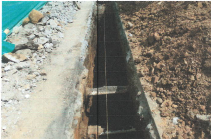
Foto 10. Nivelación e instalación de cama de arena para tubería Novafort de 16".
