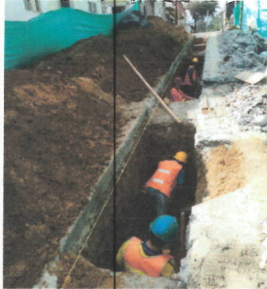
Foto 9. Terminación de excavación en zanja para instalación de tubería Novafort 16".
