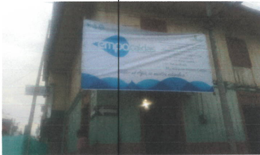
Foto 3. Instalación valla de la obra
