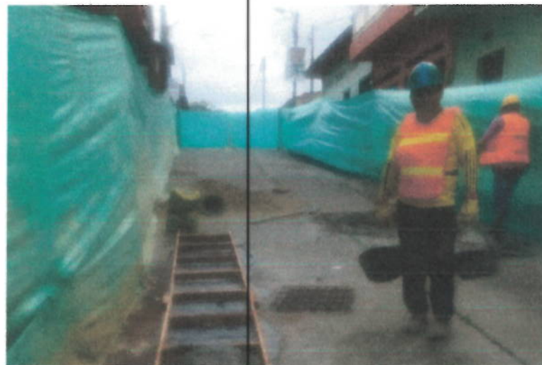
Foto 2. Cerramiento de calle con yute y guadua.
