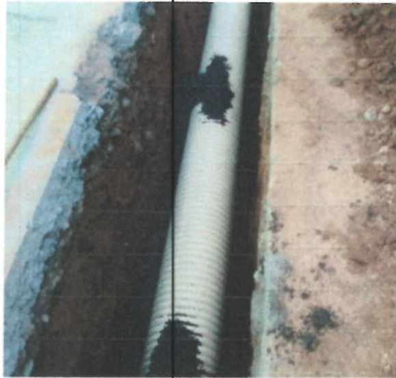
Foto 11. Instalación tubería Novafort de 16" con cama de arena de 5 cm.
