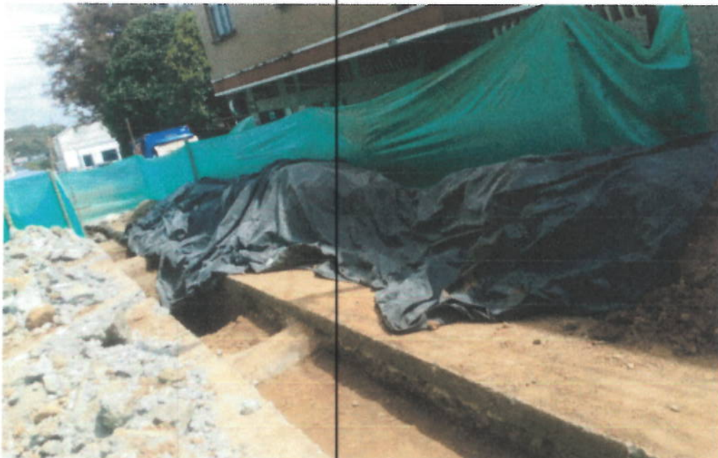
Foto 12. Plásticos para protección de material de la misma excavación, para llenos con mejor compactación.
