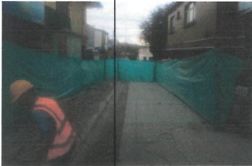
Foto 5. Corte mecánico de pavimento en brecha para instalación de tubería
