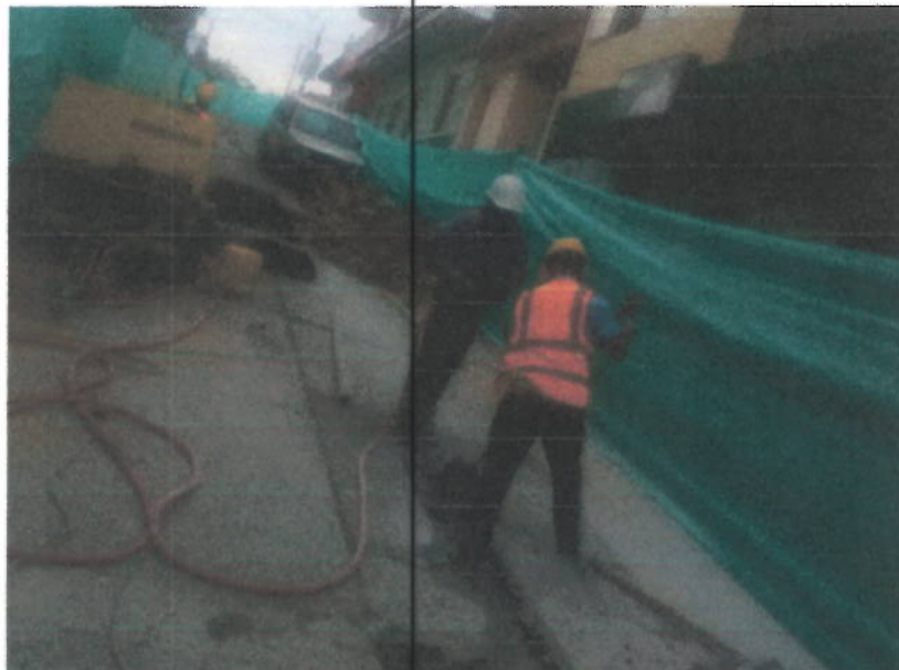
Foto 6. Demolición de pavimento en brecha para instalación de tubería
