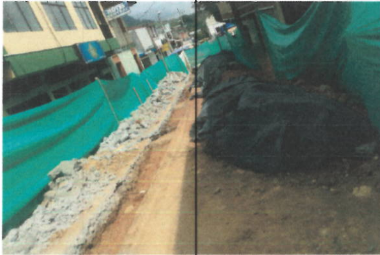
Foto 7. Comienzo excavación en zanja para instalación de tubería Novafort de 16"
