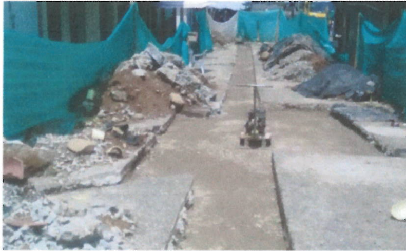
Foto 4. Sub base compacta con rana.
