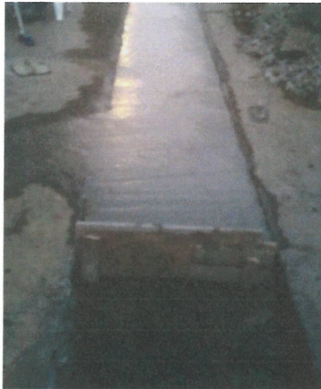
Foto 5. Comienzo de vaciado de concreto en brechas.
