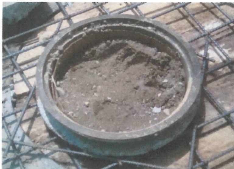
Foto 3. Instalación tapas Hf en cámaras.
