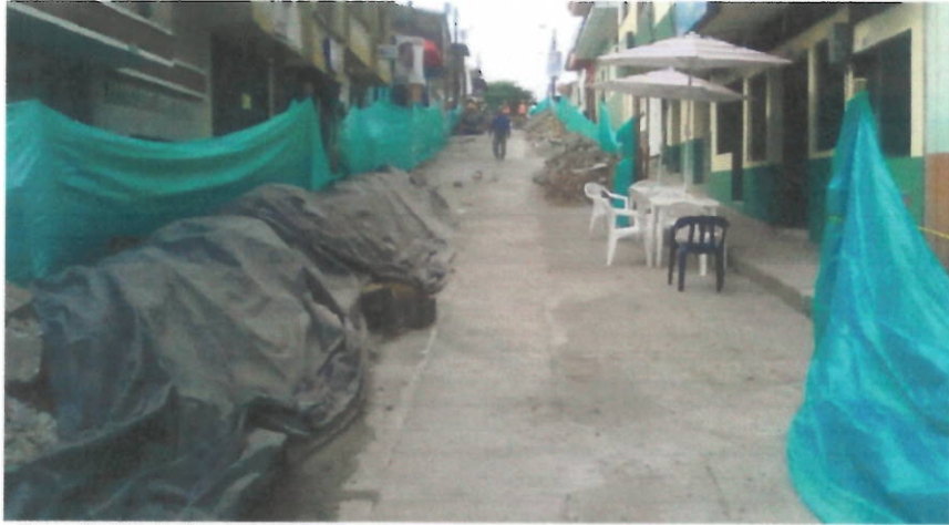
Foto 6. Vaciado de concreto para pavimento nivelado y escobado ya terminado.
