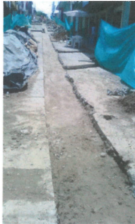
Foto 2. Brecha logitudinal y de domiciliarias compactadas con sub base.
