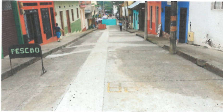
Foto 7. Obra finalizada en su totalidad y con limpieza.
