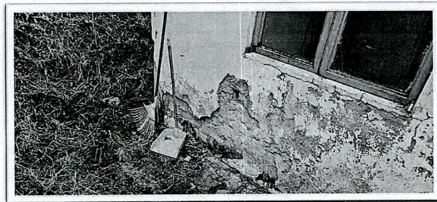
inspección de fuga de agua, pañetado, estuco, impermeabilización y mantenimiento exterior e interno para el mejoramiento integral de muros afectados por humedad.
