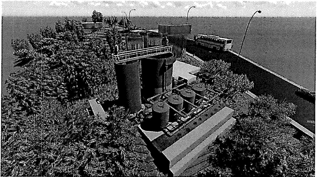
Se tiene en cuenta solo la nueva fase, la construcción actual se establece en material traslucido para la comprensión del proyecto, tubería, sedimentador etc totalmente nuevos.
