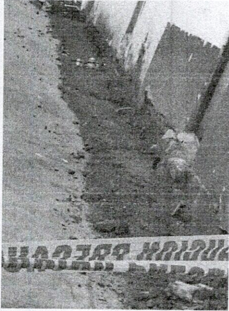
FOTO 5. Evacuación de escombros.
