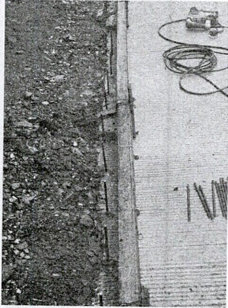
FOTO 9. Instalación de formaleta.
