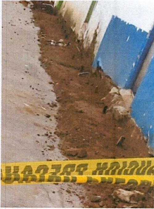
FOTO 5. Evacuación de escombros.
