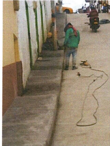
FOTO 18. Desinstalación de formaleta.
