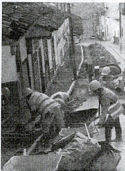
FOTO 15. Vaciado de anden lado izquierdo.
