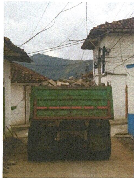
FOTO 4. Evacuación de escombros.
