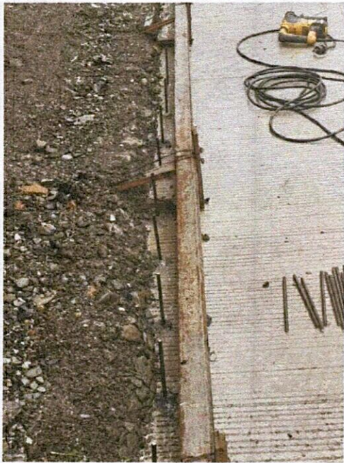
FOTO 9. Instalación de formaleta.
