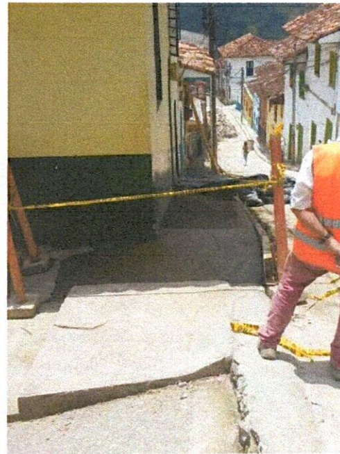
FOTO 16. Acabado de andén.
