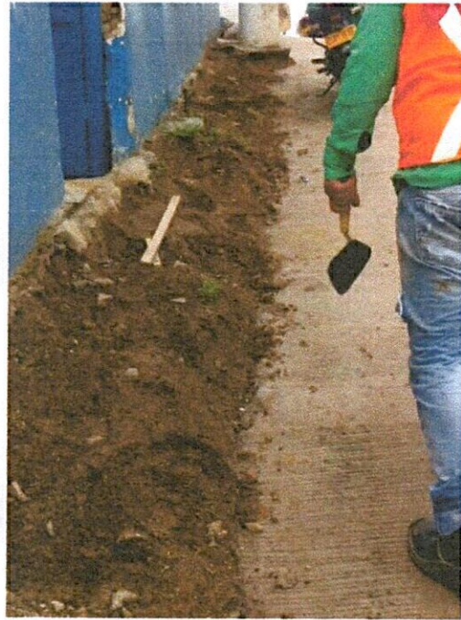
FOTO 6. Retiro de escombros en volqueta.
