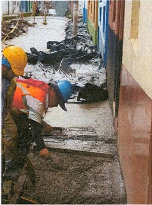
FOTO 13. Vaciado de andén lado derecho.
