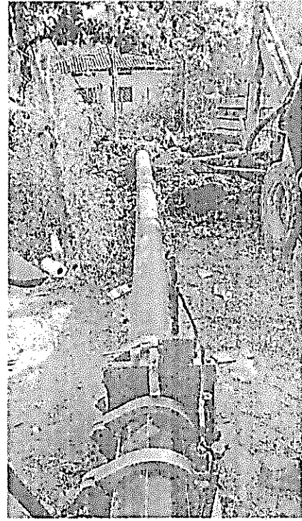
PROCESO DE REPARACIÓN CON TERMOFUSIÓN E INSTALACIÓN DE TUBERÍA DE POLIETILENO
