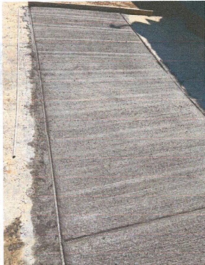
Terminado final del concreto
