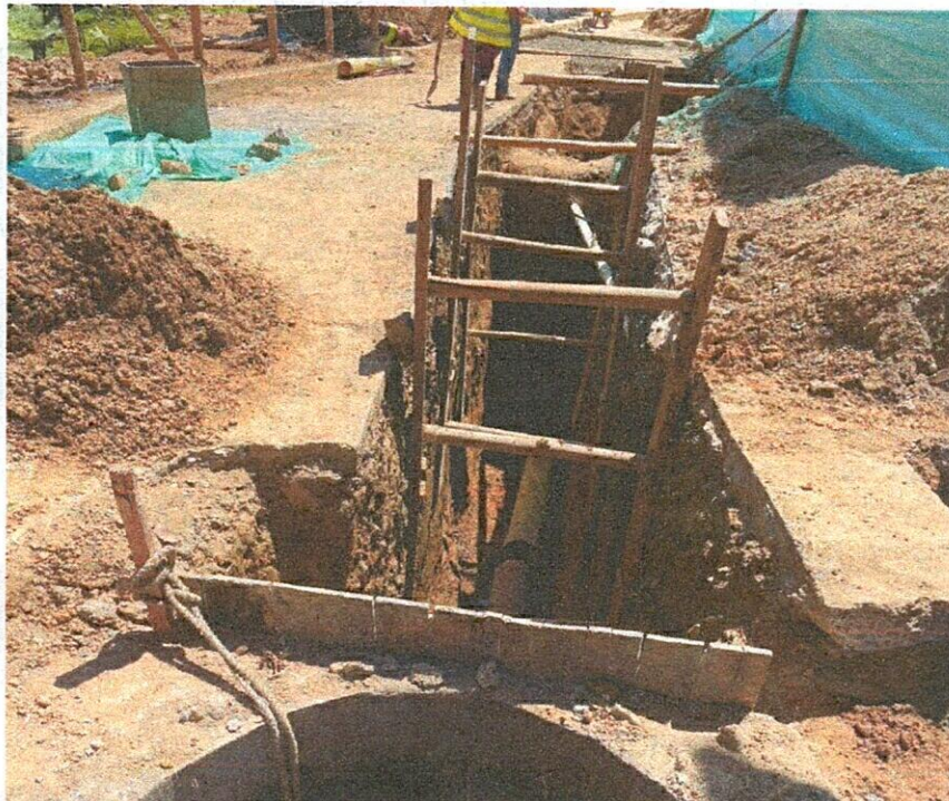
Instalación de entibado
