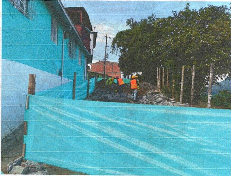
Señalización con yute y demolición de pavimento con equipo
