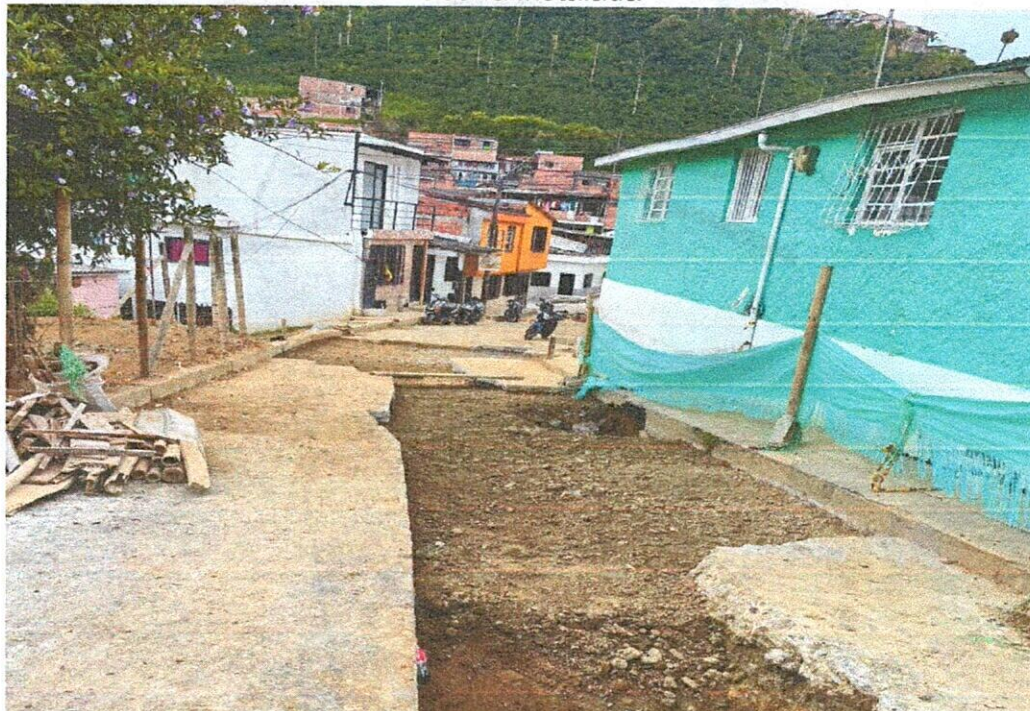
Lleno con material de la obra – sobrecanchos
