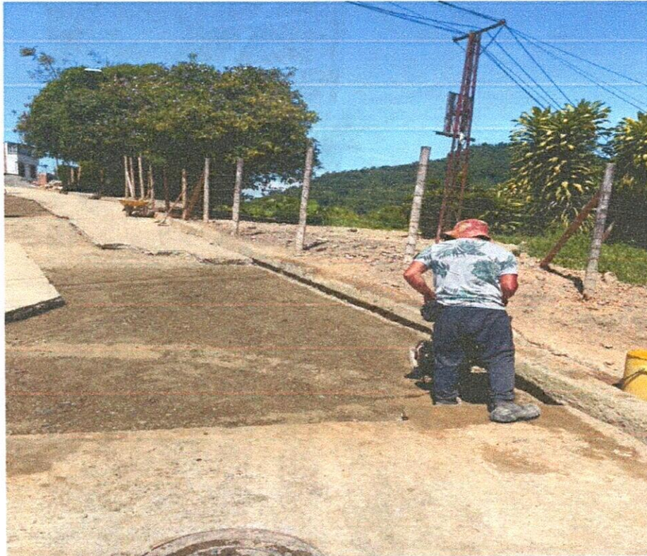
Instalación y compactación de subbase
