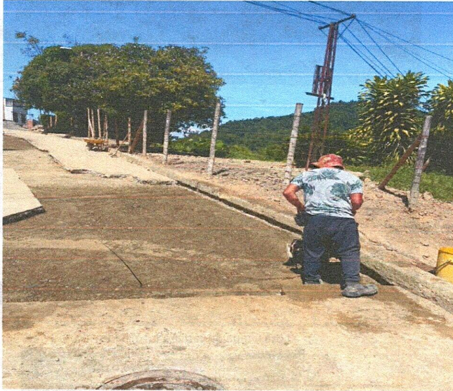
Instalación y compactación de subbase
