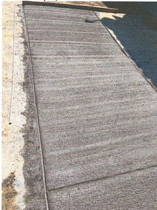
Terminado final del concreto
