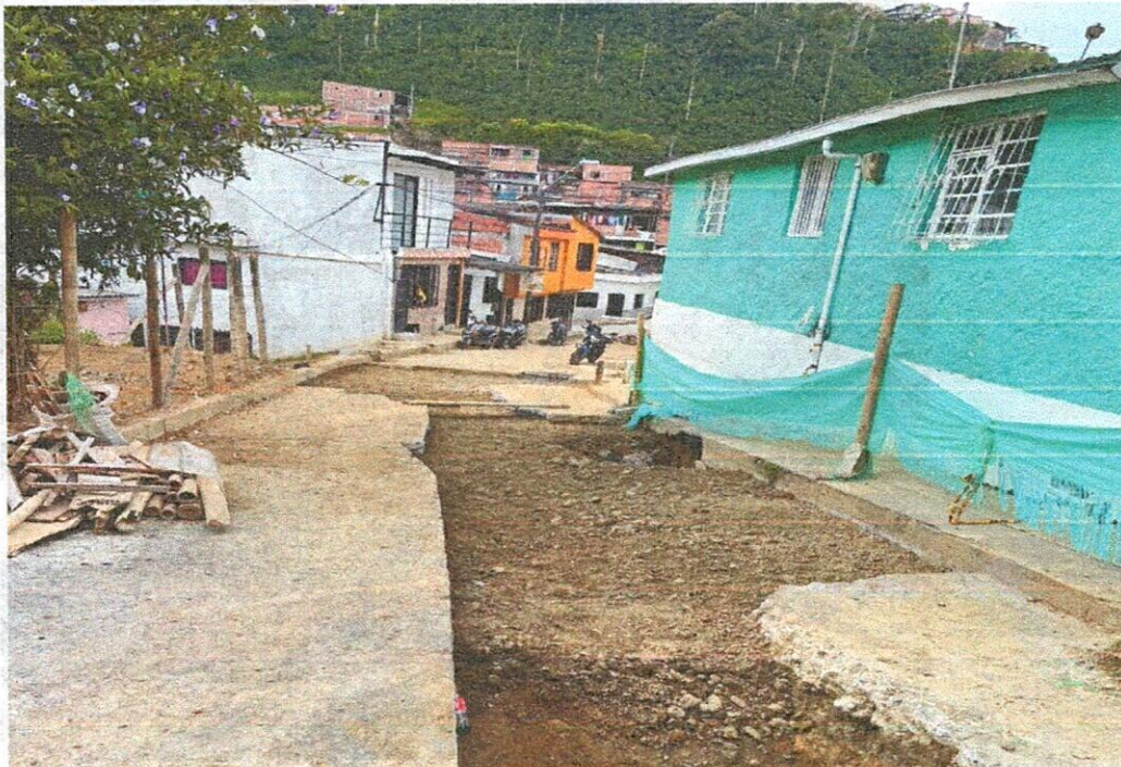
Lleno con material de la obra – sobrecanchos
