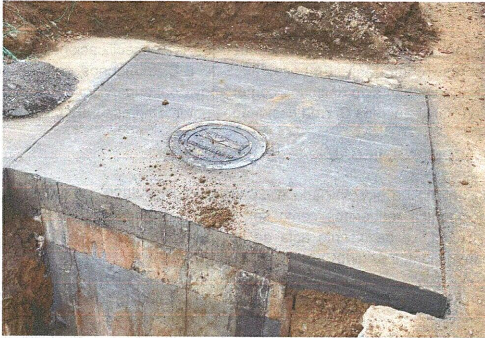
Losa y tapa de cámara terminada
