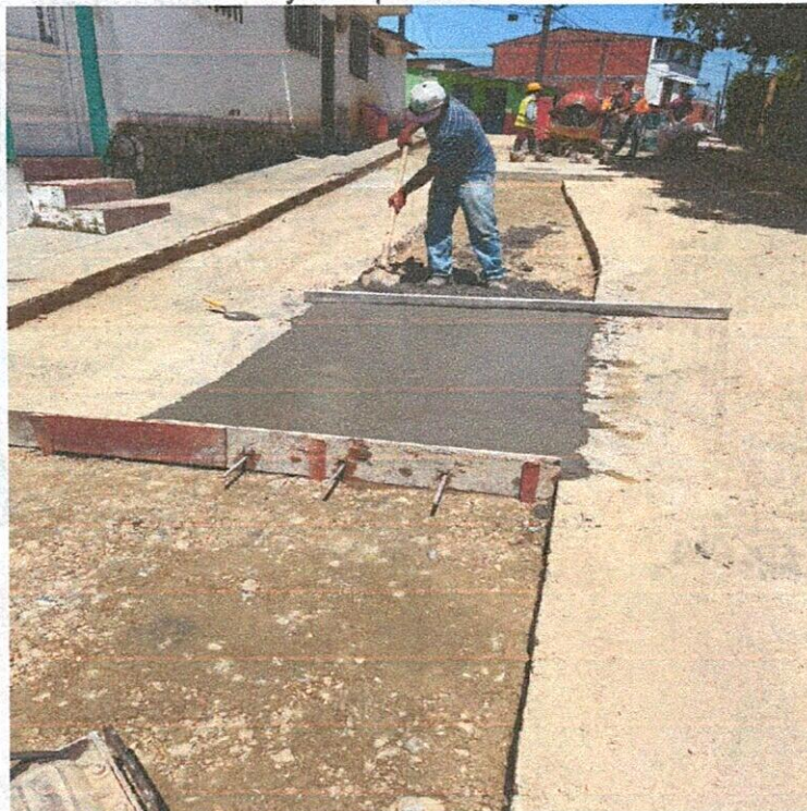
Vaciado de concreto en franja
