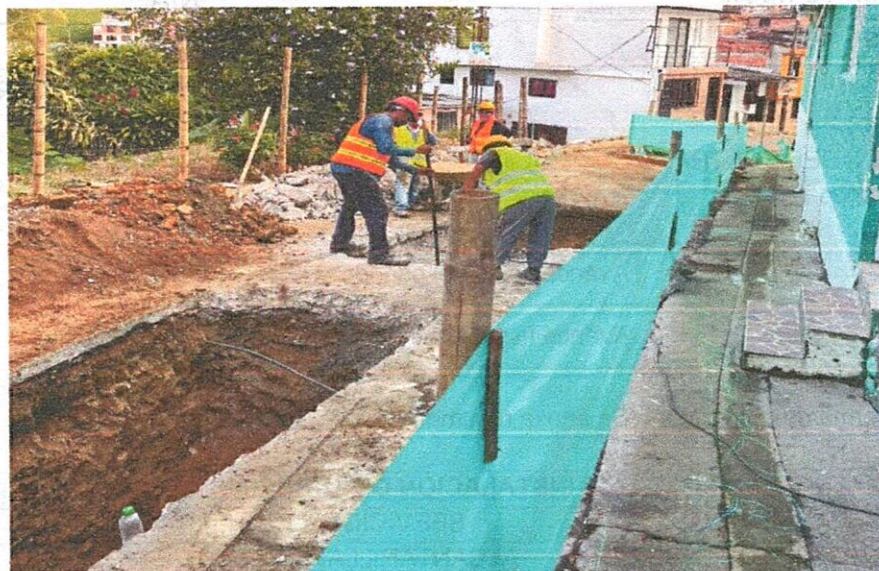
Excavación para tubería de alcantarillado
