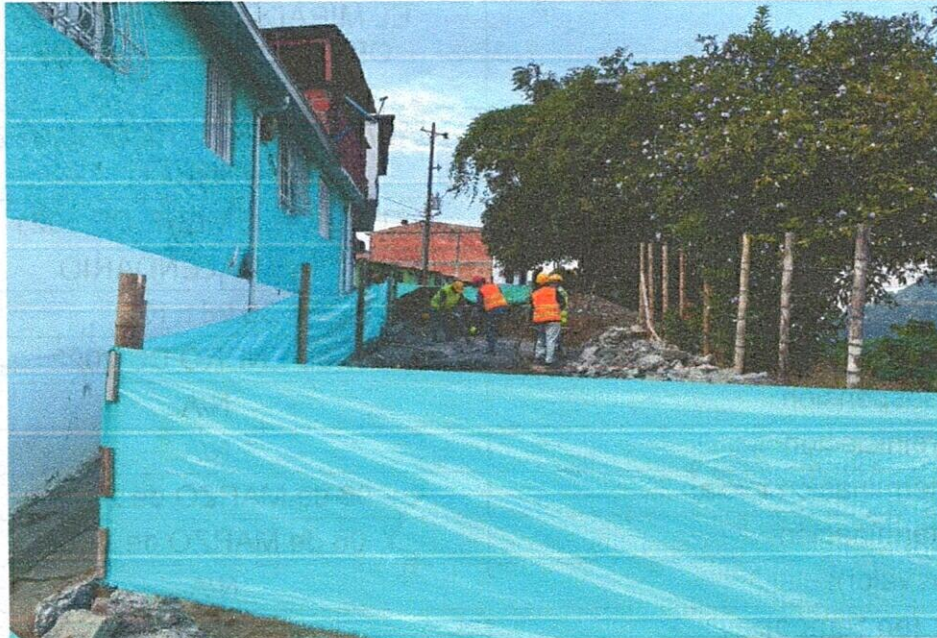
Señalización con yute y demolición de pavimento con equipo
