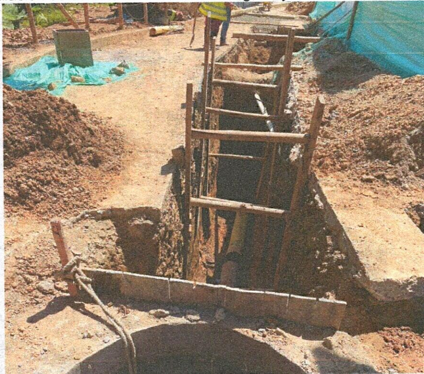
Instalación de entibado
