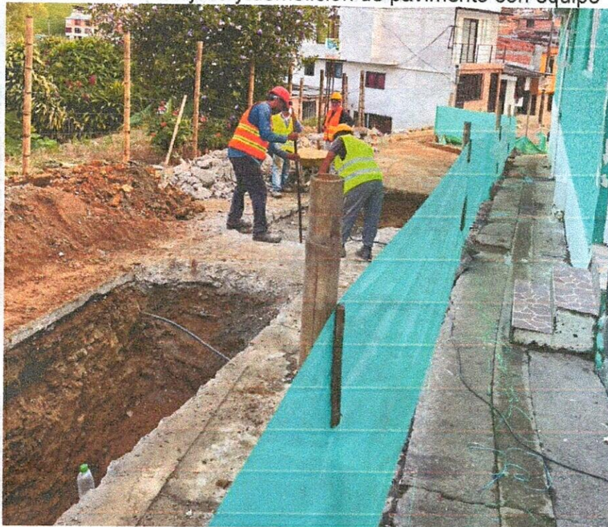
Excavación para tubería de alcantarillado
