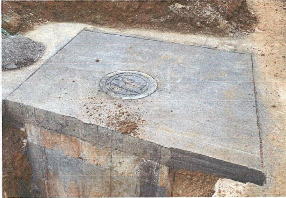
Losa y tapa de cámara terminada
