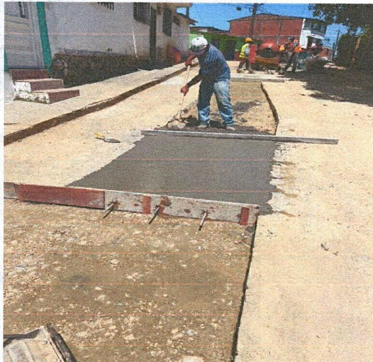
Vaciado de concreto en franja
