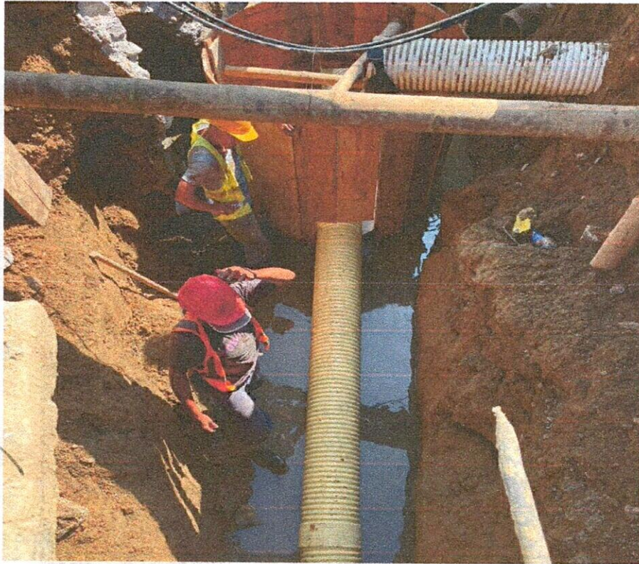
Instalación de tubería de 12" PVC corrugada y construcción de cámara
