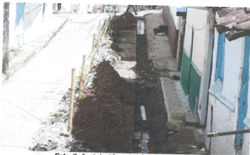
Foto 8. Instalación tubería RDE 21 de 6".
