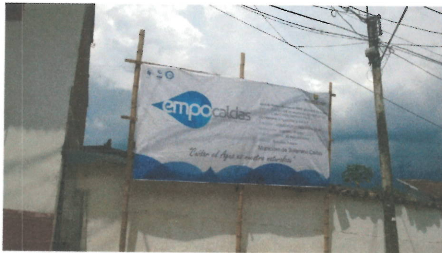
Foto 2. Instalación valla de obra Empocaldas.
