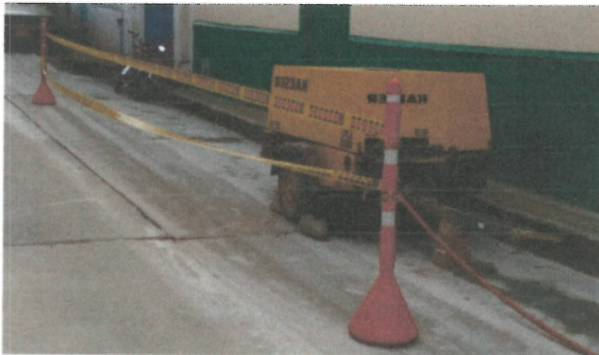
Foto 4. Compresor para comienzo de demolición en franja.
