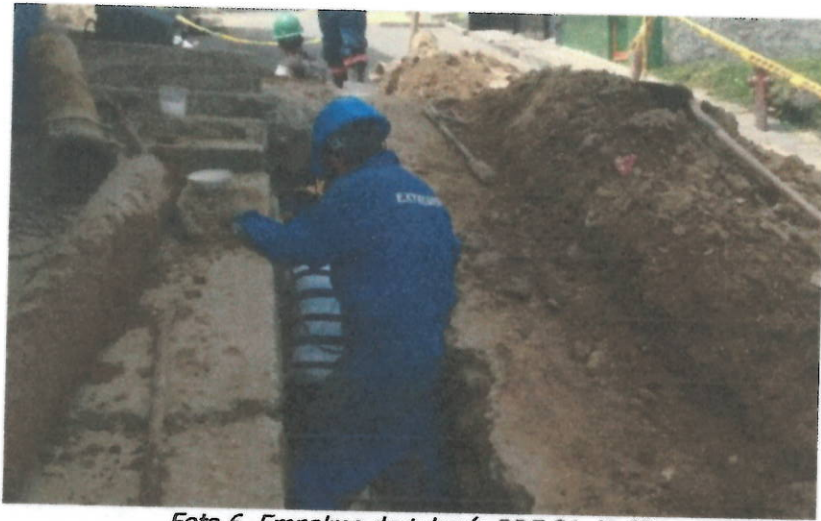
Foto 6. Empalme de tubería RDE 21 de 6".
