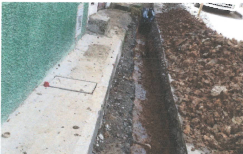
Foto 5. Excavación y nivelación cero para instalación de tubería.
