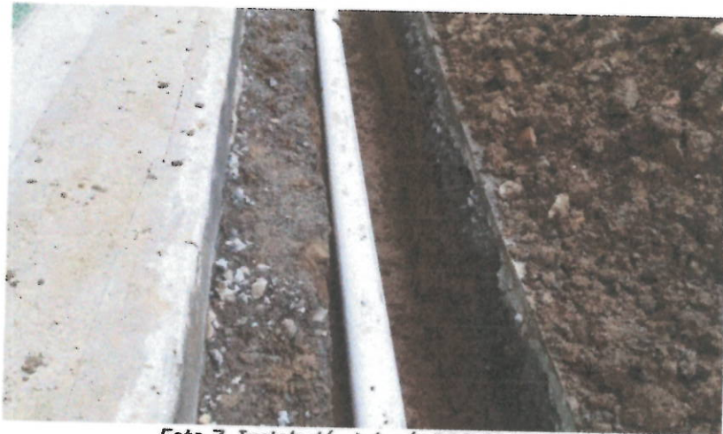
Foto 7. Instalación tubería RDE 21 de 6".
