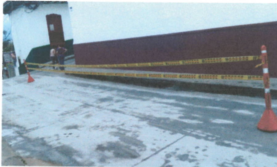
Foto 1. Señalización en la obra.
