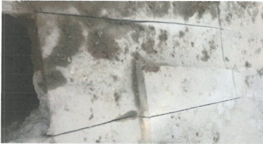
Foto 3. Cortes en franja para demolición de pavimento.
