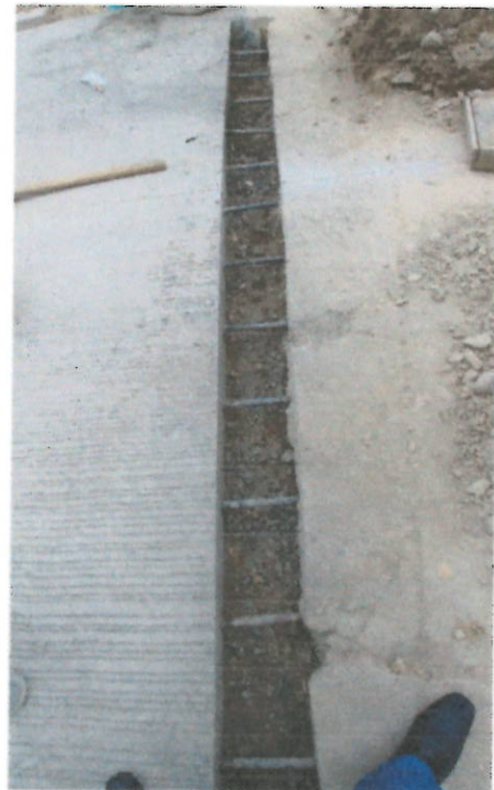
Foto 5 y 6. Instalación dovelas para vaciado entre plato nuevo y viejo en intersección de la carrera 5 con calle 2.
