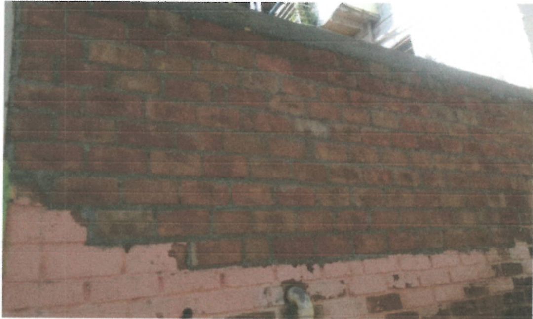
Foto 7. Construcción parte de muro con viga.
