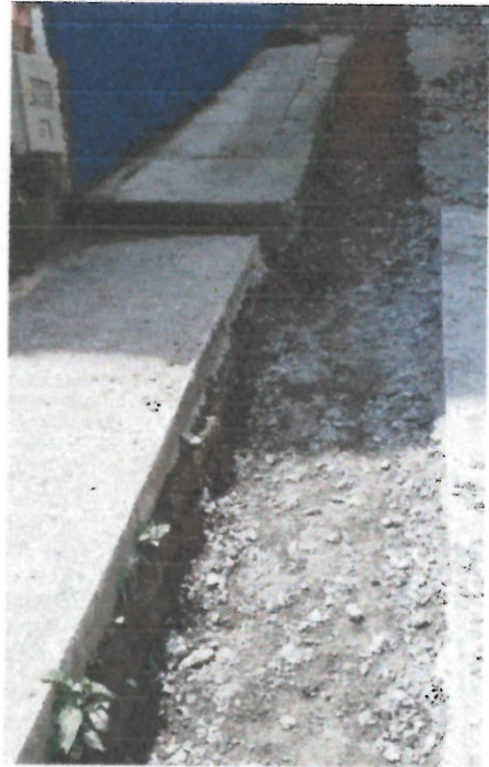
Foto 1 y 2. Compactación Sub base para pavimentación de brecha.
