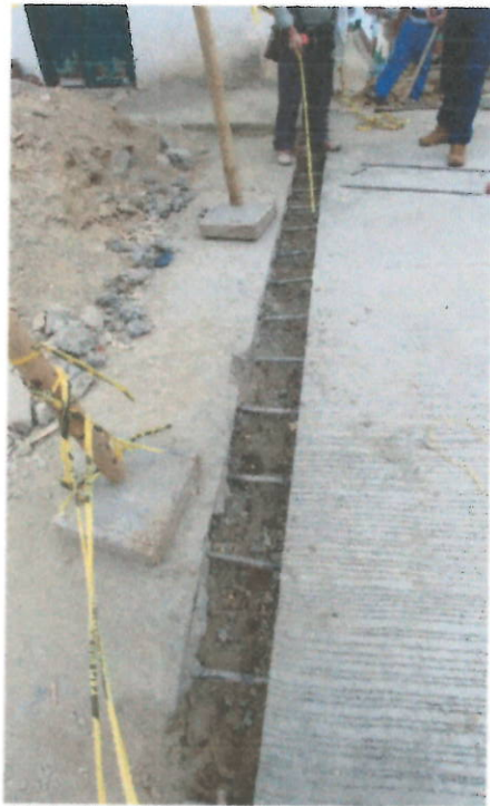
Foto 5 y 6. Instalación dovelas para vaciado entre plato nuevo y viejo en intersección de la carrera 5 con calle 2.
