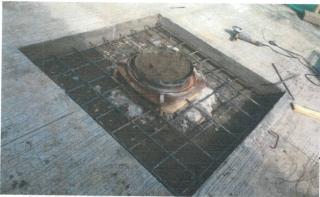
Foto 3. Refuerzo pavimento de cámara en intersección carrera 5 con calle 2.
