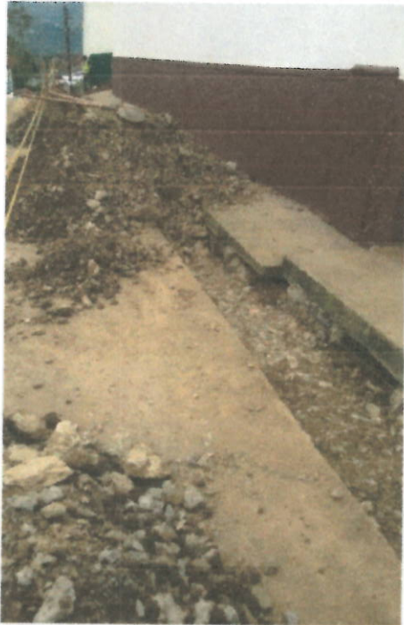
Foto 1 y 2. Compactación Sub base para pavimentación de brecha.
