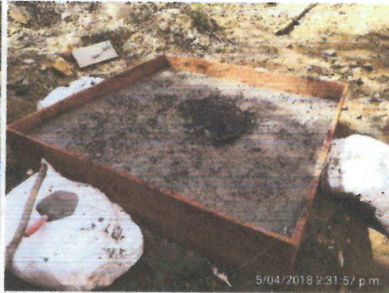
Ubicación. Cll 6 Descripción. Losa concreto reforzado
