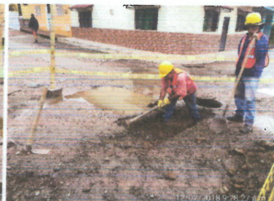
Ubicación. Cra 4 Descripción. Excavación para tubería
