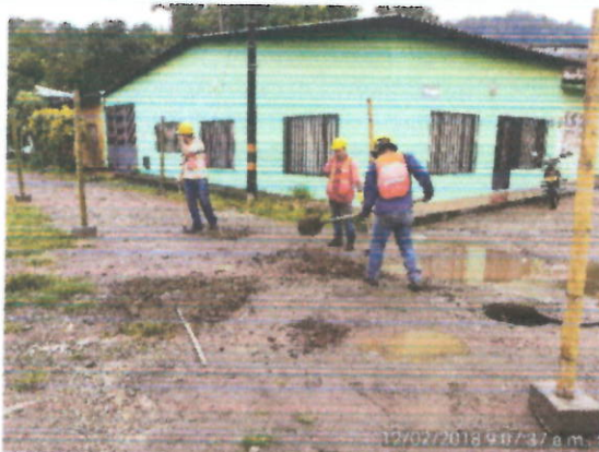
Ubicación. Cra 4 Descripción. Excavación para tubería
