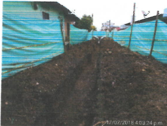
Ubicación. Cra 4 Descripción. Excavación para tubería
