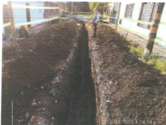
Ubicación. Cra 4 Descripción. Excavación para tubería
