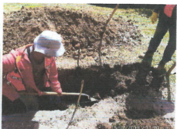
Ubicación. Cra 4 Descripción. Excavación para tubería
