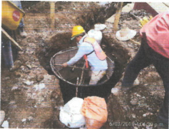
Ubicación. Cll 6 Descripción. Vaciado cámaras alcantaría
