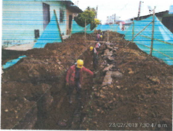
Ubicación. Cra 4 Descripción. Lleno brecha de tubería
