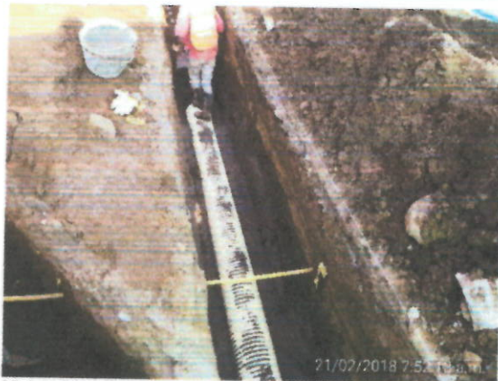
Ubicación. Cra 4 Descripción. Instalación tubería
