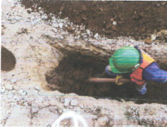
Ubicación. Cll 6 Descripción. Excavación para tubería
