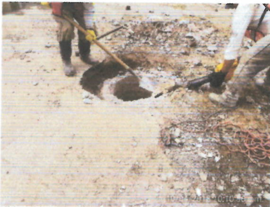
Ubicación. Cra 4 Descripción. Demolición para cámara
