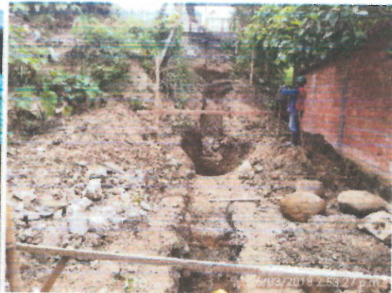
Ubicación. Cll 6 Descripción. Excavación para tubería
