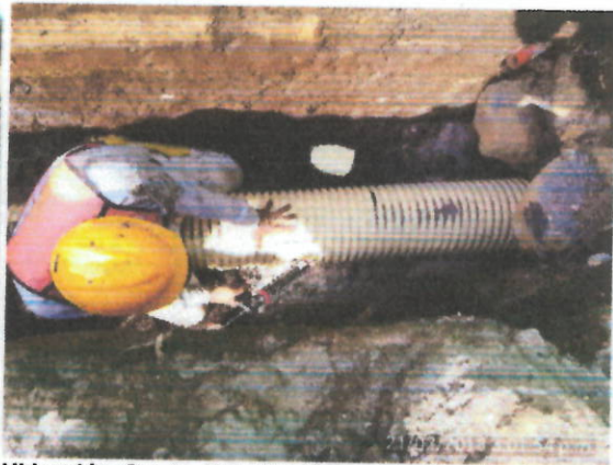
Ubicación. Cra 4 Descripción. Instalación tubería
