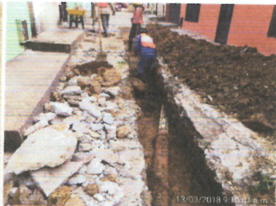
Ubicación. Cll 6 Descripción. Excavación para tubería
