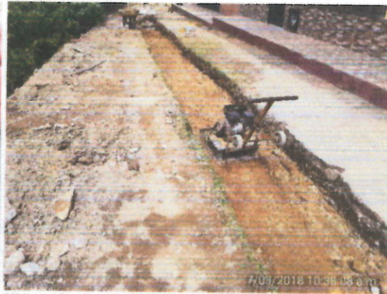
Ubicación. Cra 4 Descripción. Nivelación terreno
