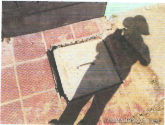
Ubicación. Cra 4 Descripción. Cámara inspección
