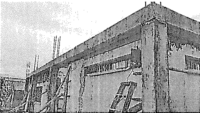
Columnas exteriores con viga de amarre.
