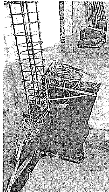
Acero de columna en pedestal y zapata en la parte interior de la edificación.
