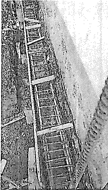
Acero en vigas de cimentación.
