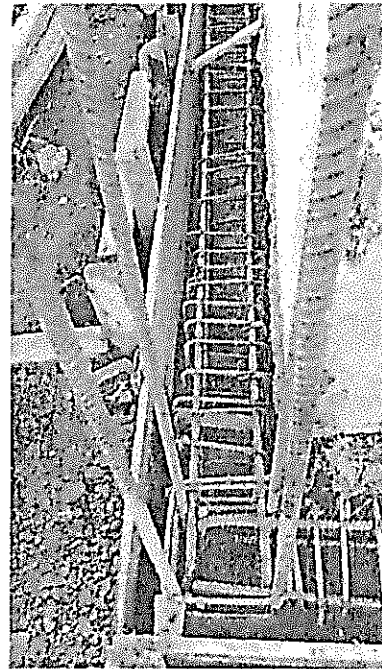
Acero en vigas de cimentación.
