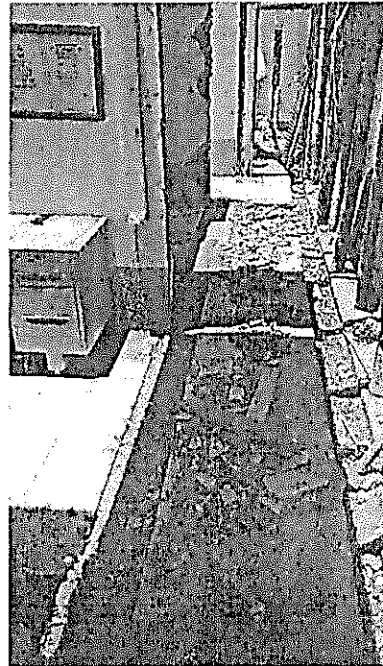
Demolición de muros interiores existentes.
