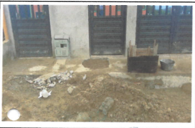
DEMOLICION EN ANDENES PARA CONSTRUCCION CAMARAS
