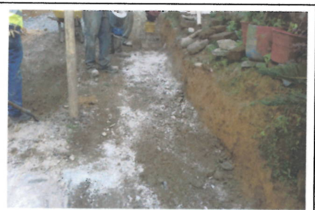
AFIRMADO CON CEMENTO PARA CONSTRUCCION SENDERO PARA MOTOS
