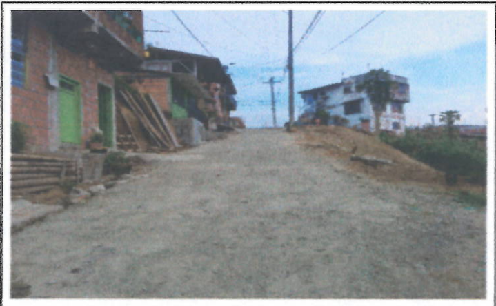
AFIRMADO COMPACTADO EN TODA LA VIA DESDE CAMARAS 3 A 5
