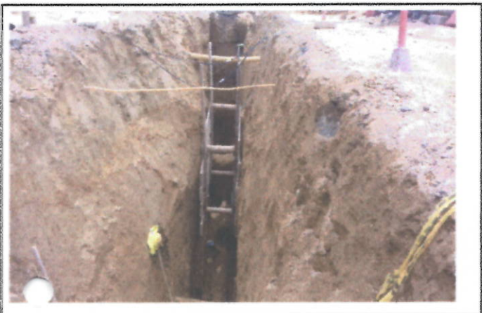
ENTIBADO TIPO II PROFUNDIDAD 6 MTS
