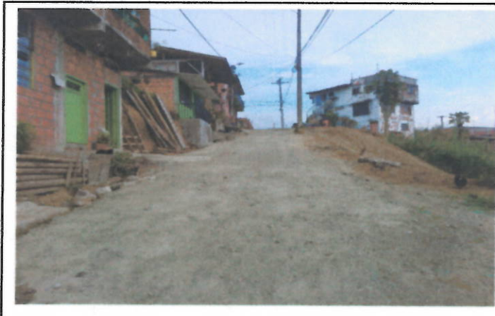
ESTADO FINAL EN AFIRMADO COMPACTADO MANZANA G
