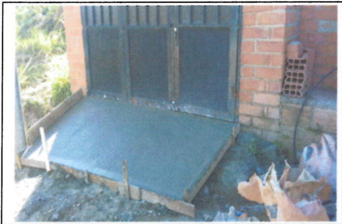
RECONSTRUCCION DE ACCESOS A GARAGES
