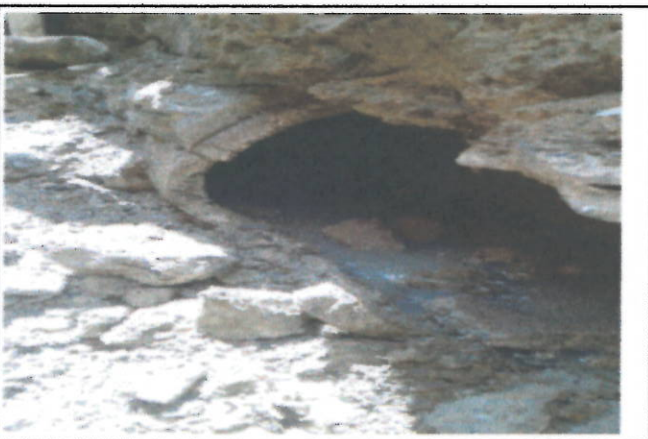
DEMOLICION ANCLAJE CONCRETO DEBAJO DE TUBO
