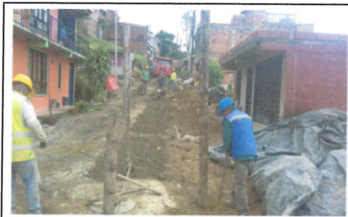
SUMINISTRO E INSTALACION DE AFIRMADO E= 0,20 MTS SOBRE BRECHA
