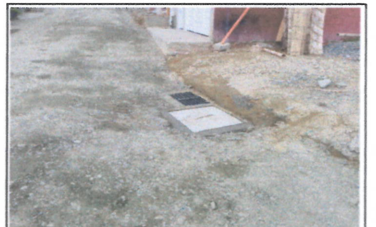
CONSTRUCCION DE SUMIDEROS
