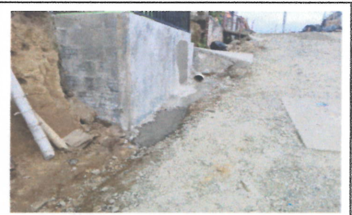
RECONSTRUCCION DE PAREDES DESPUES DE CONSTRUIR CAMARAS
