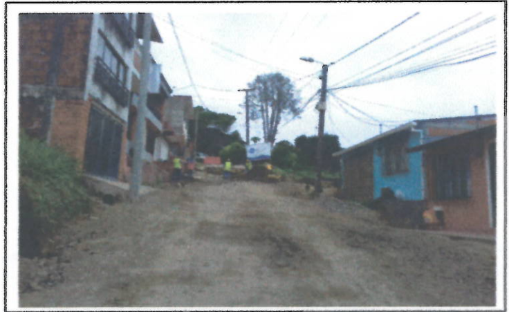
EXTENDIDA Y COMPACTADA DE AFIRMADO ENTRE CAMARAS 1 Y 2
