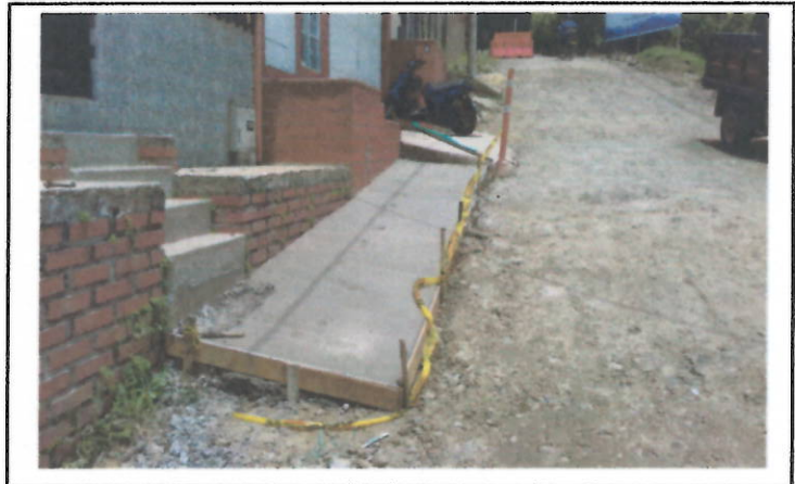
RECONSTRUCCION DE ANDENES
