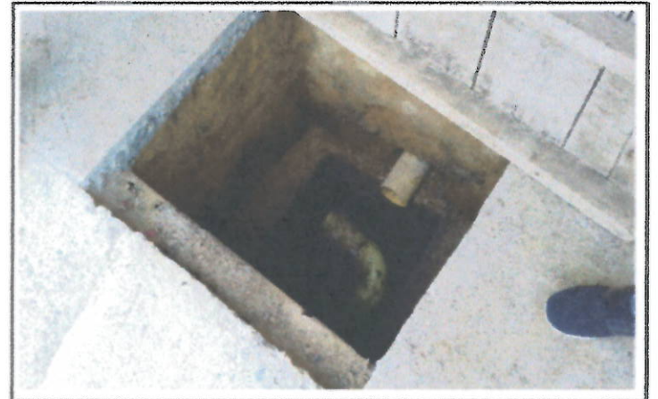
CONSTRUCCION CAJAS DOMICILIARIAS
