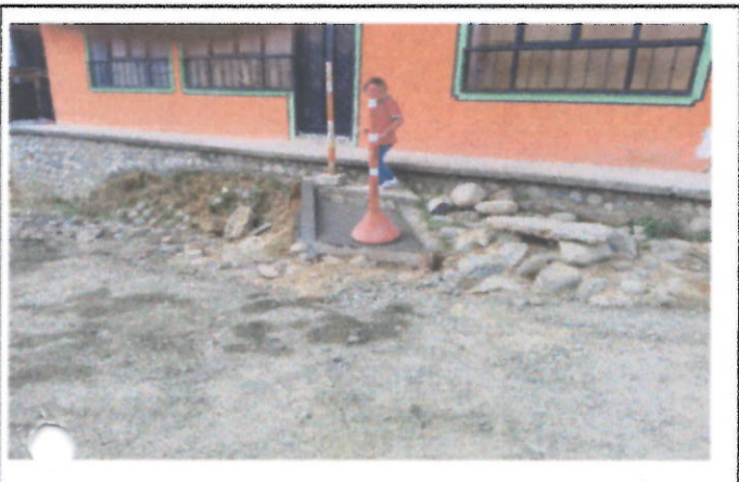
RECONSTRUCCION DE ACCESOS A LAS VIVIENDAS
