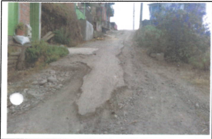
DEMOLICION DE ASFALTO , ESTADO INICIAL MANZANA G
