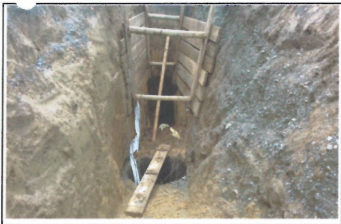
ENTIBADO PROFUNDIDAD DE 6 MTS
