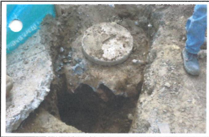
DEMOLICION DE CUELLOS PARA REALCE DE CAMARA
