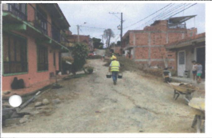
VIA DESPUES DE INSTALADA LA TUBERIA
