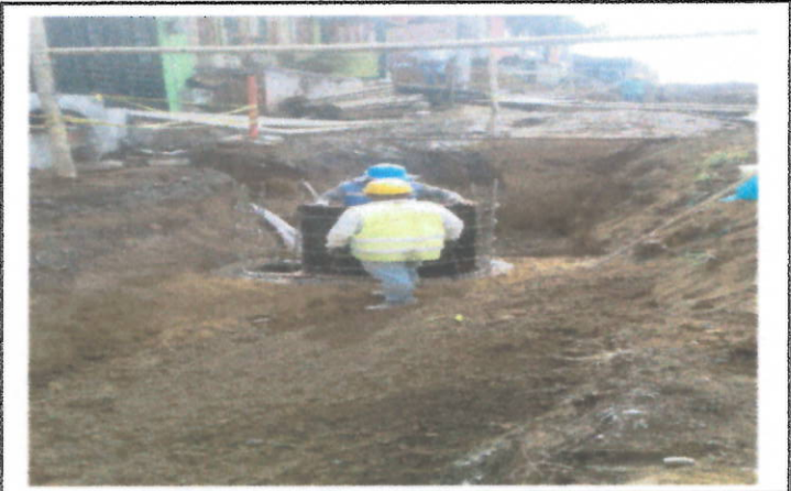
CONSTRUCCION CAMARA DE INSPECCION
