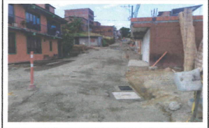
VIA CON AFIRMADO COMPACTADO ENTREGA FINAL
