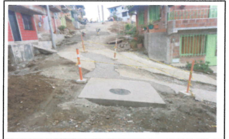
LOSA PARA TAPA CAMARA EN HF
