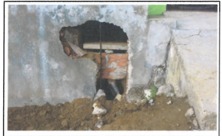
DEMOLICION DE PAREDES Y CAMARAS EN ANDENES
