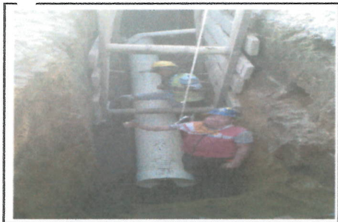
INSTALACION TUBERIA DE 17" - CAMA DE ARENA
