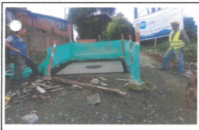
CONSTRUCCION LOSA CAMARA No 01
