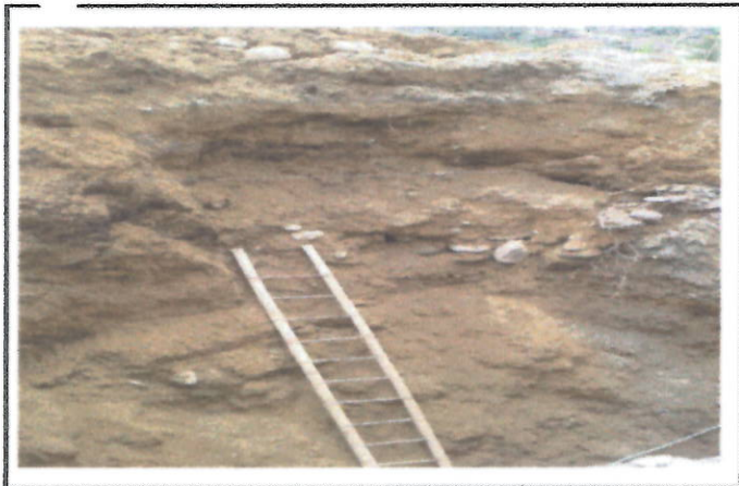
EN LA EXCAVACION SE OBSERVA TERRENO EN LLENO
