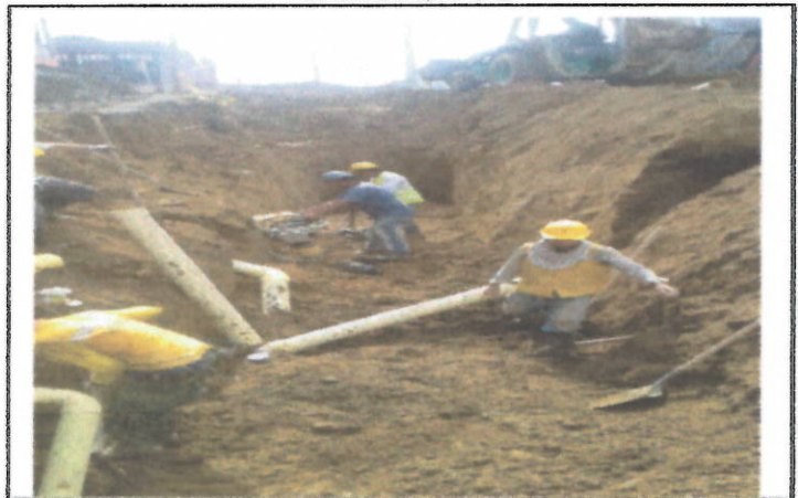
INSTALACION CODOS DE 45 GRADOS SOBRE ACOMETIDAS
