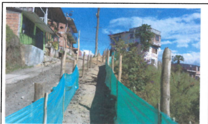
SUMINISTRO E INSTALACION DE AFIRMADO E= 0,20 MTS SOBRE BRECHA
