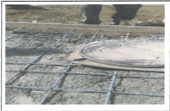
CONSTRUCCION LOSA PARA TAPAS EN HF - HIERRO DOBLE PARRILLA
