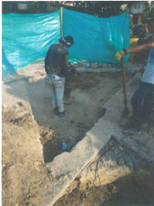
LLENOS COMPACTADOS CON MATERIAL SELECCIONADO DE EXCAVACION A LO LARGO DE LA BRECHA
