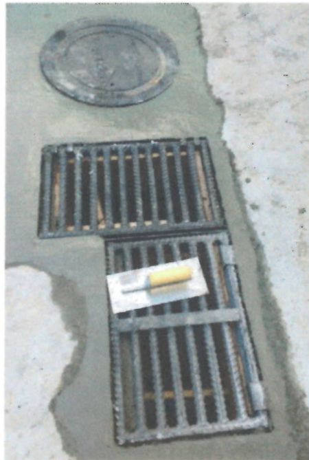
INSTALACION DE SUMIDERO EN L CL 18 A CR 8 08
