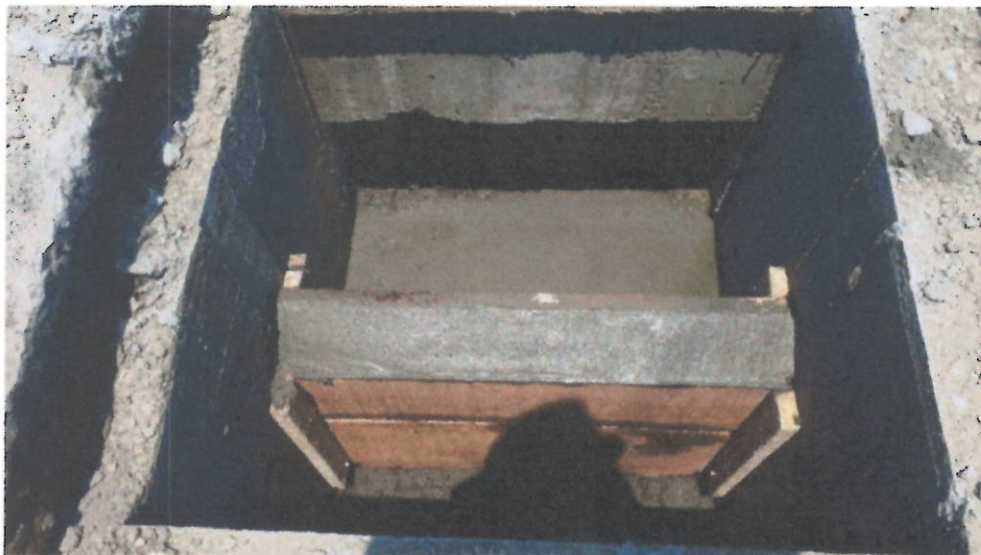
CAJA SIFON PARA SUMIDERO CONSTRUIDO JUNTO A CAMARA DE ALCANTARILLADO N°2
