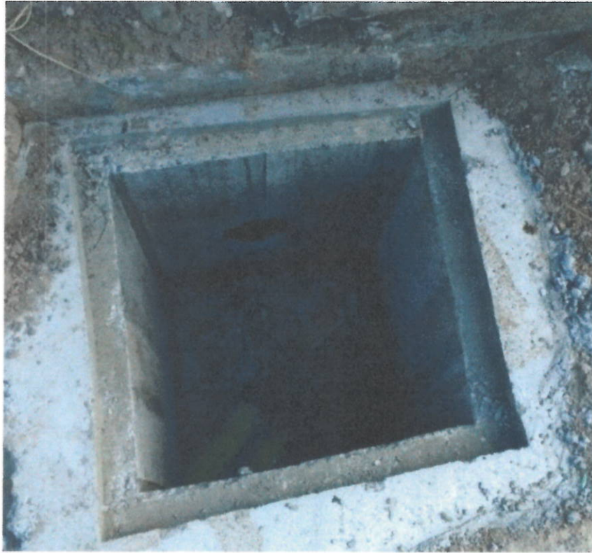
CAJA DE INSPECCION TIPO 1 PARA DOMICILIARIA
