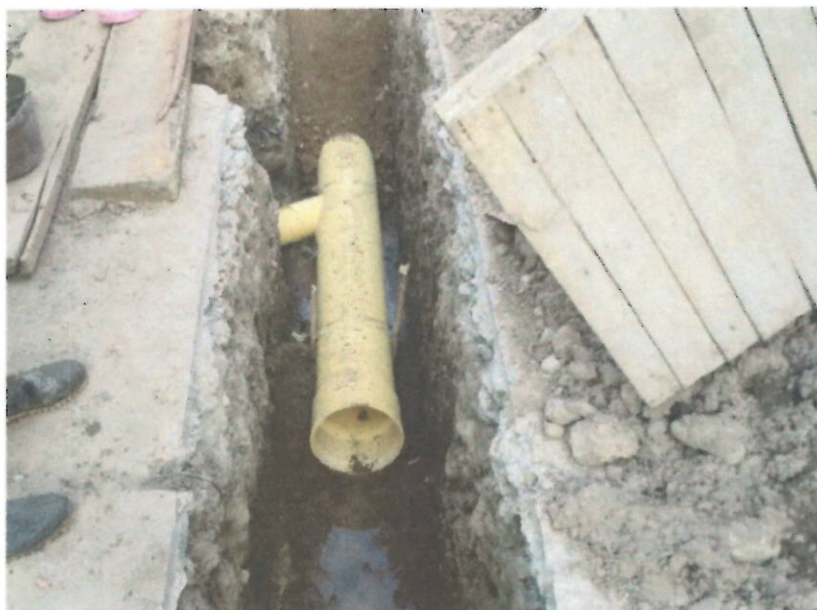
EMPALME DOMICILIARIA DE ALCANTARILLADO A RED PRINCIPAL
