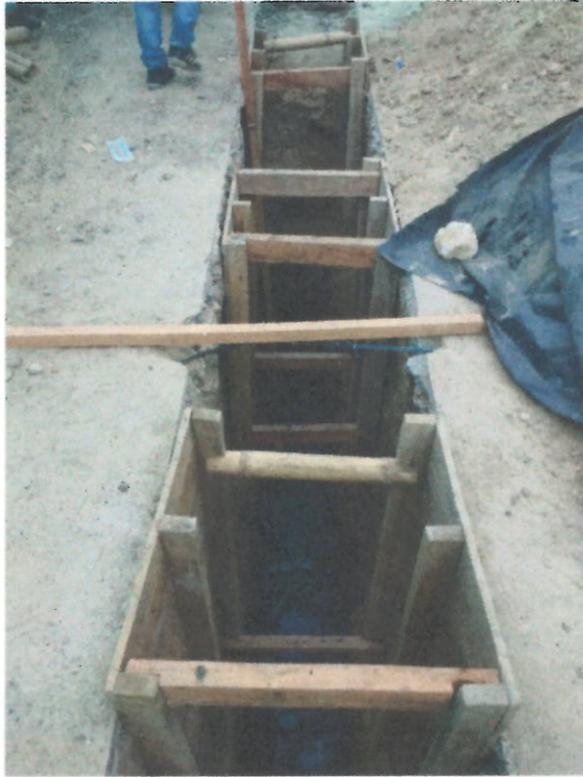
ENTIBADO PARA SOPORTE DE PAREDES DE FRANJA EXCAVADA SUPERIOR A 1,5 M
