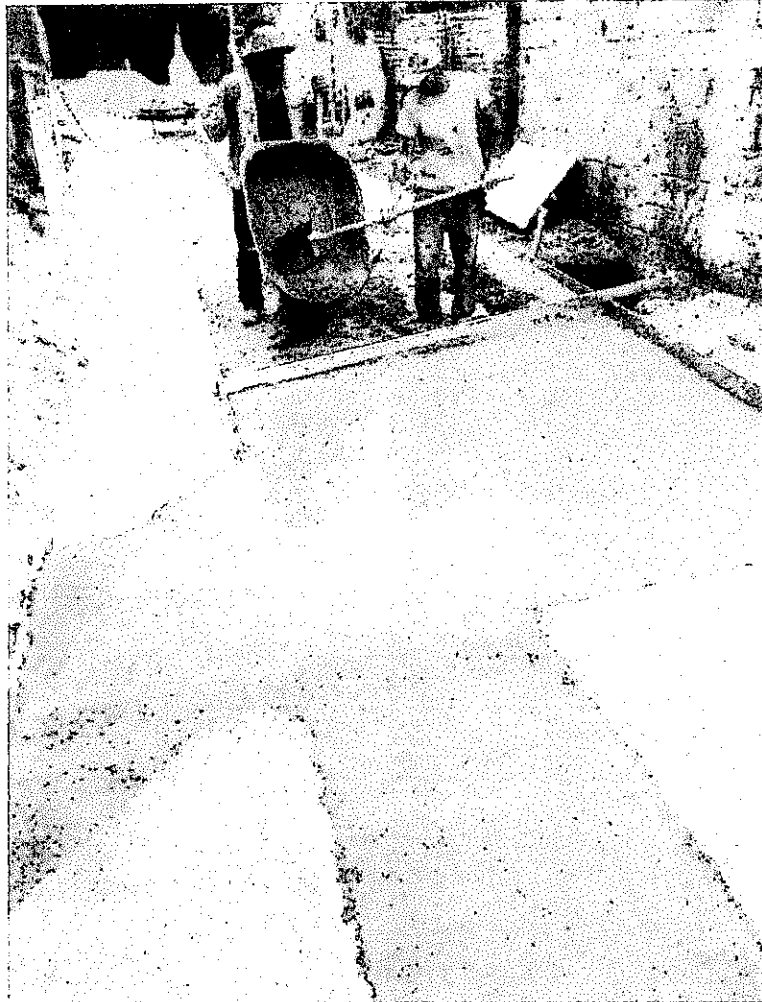
PAVIMENTO 3000 PSI VACIADO EN FRANJA RED PRINCIPAL Y PASES DE DOMICILIARIAS
