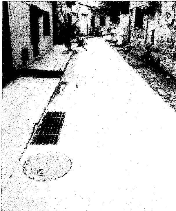
PAVIMENTO COMPLETO, ACABADO FINAL, SUMIDERO TIPO SIFON A CAMARA 2
