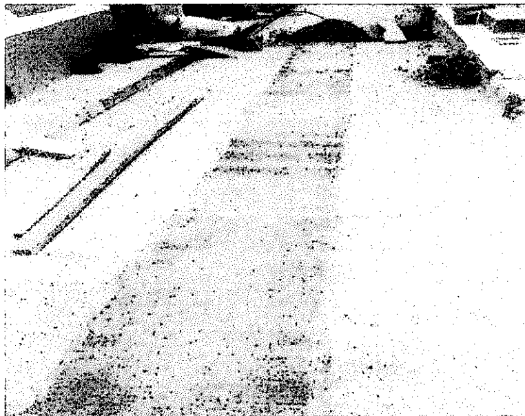
PAVIMENTO 3000 PSI VACIADO EN FRANJA RED PRINCIPAL Y PASES DE DOMICILIARIAS
