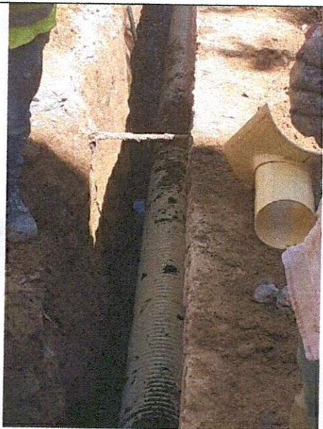
FOTO 5. Instalación de tubería.
