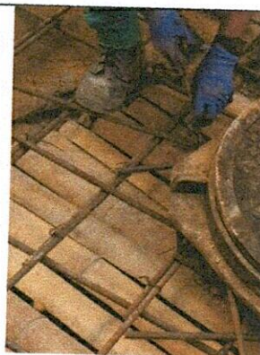
10. Instalación de tapa HF
