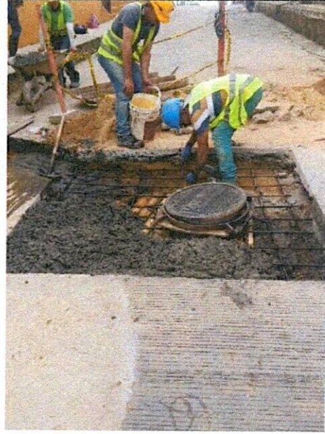
FOTO 10. Instalación de acero
