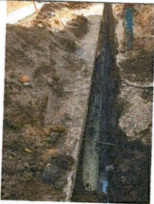
3. Excavaciones para tubería principal.
