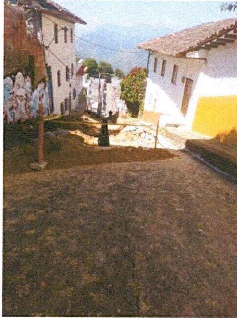
FOTO 1. Demolición de pavimento
