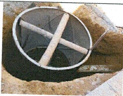
7. Instalación de formaleta para camara.
