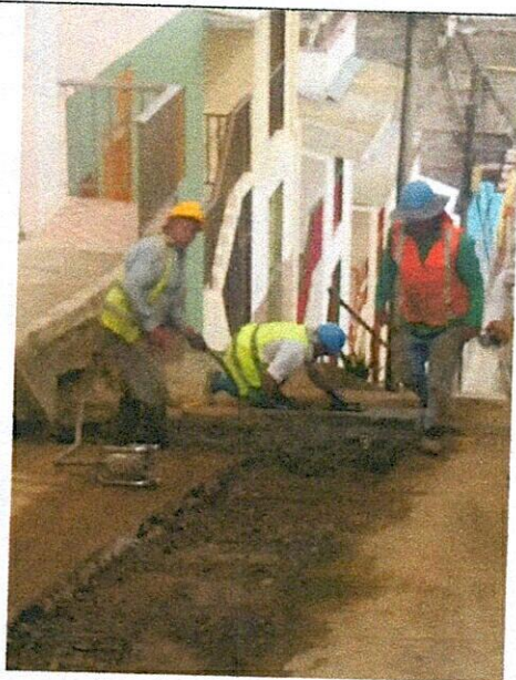
11. Vaciado de pavimento.
