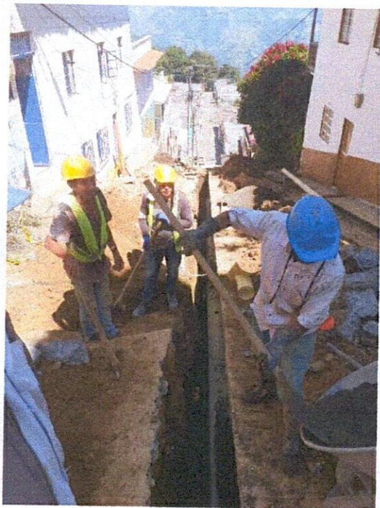
FOTO 7. Instalación de cama de arena.
