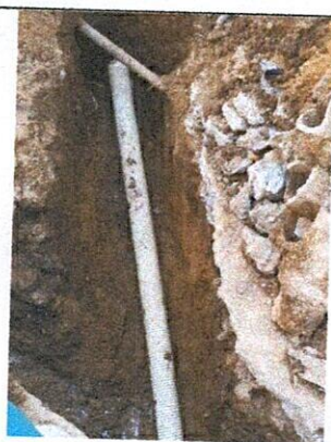
9. Instalación de tubería 6".
