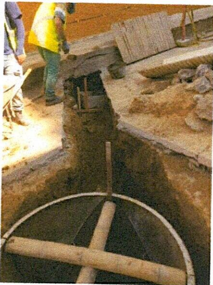
FOTO 11. Instalación de formaleta para caja domiciliaria.
