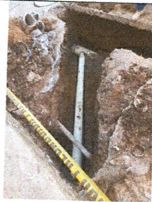
4. Excavación para domiciliaria.
