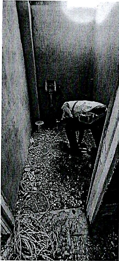
Demolición de pisos, pañete de muros
