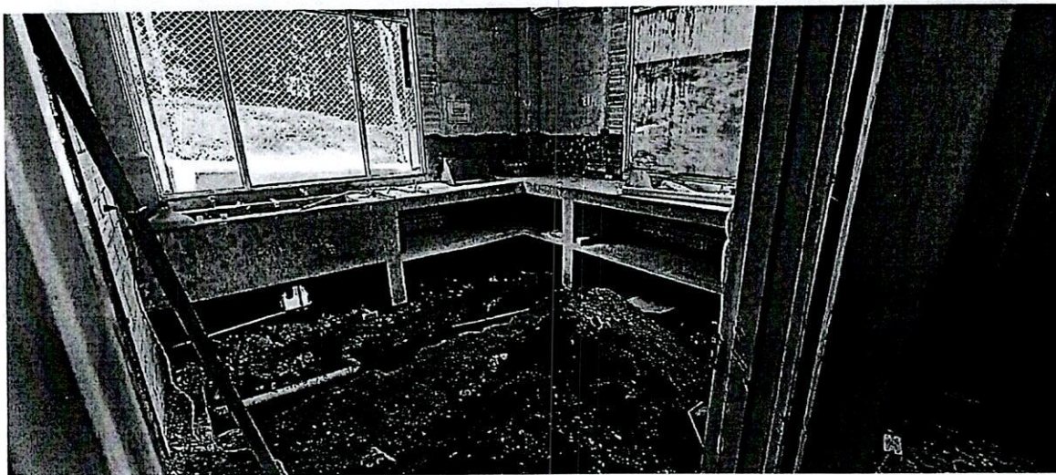
Retiro de pisos, cambio de tuberías y demolición de mesones.
