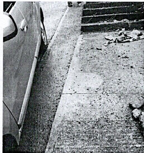
FOTO 8. Tramo con reposición en concreto
