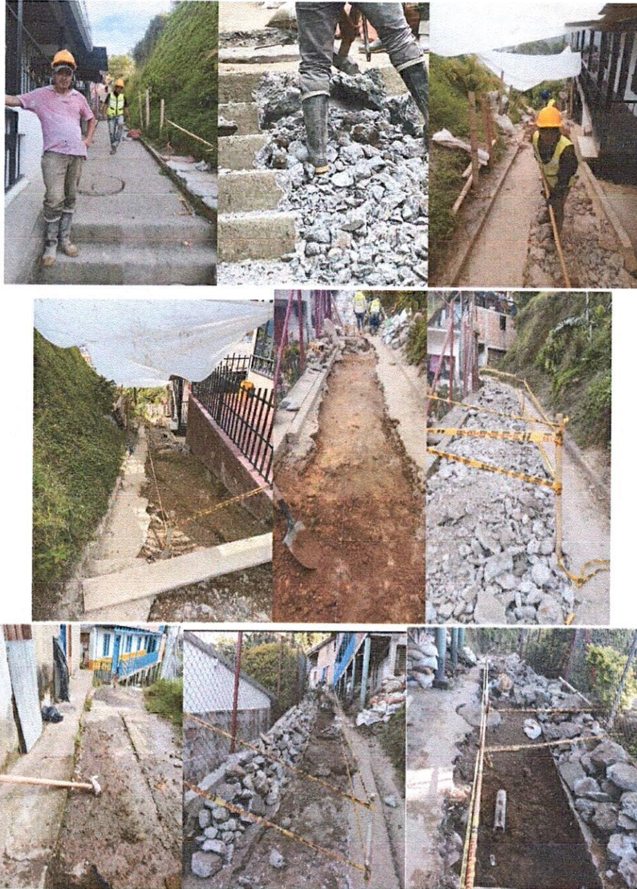
Demoliciones desde cámara 18 a 15
