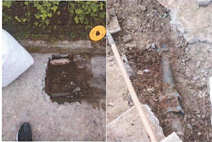
Apiques búsqueda tubería a presión de 3 y 4"
