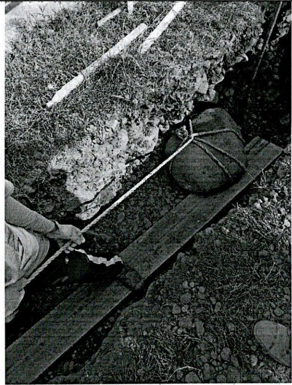
Retiro de Roca de Forma Manual
