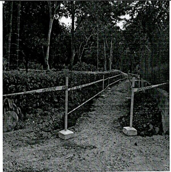
CERRAMIENTO CON BOMBONES Y CINTA DE SEÑALIZACIÓN
