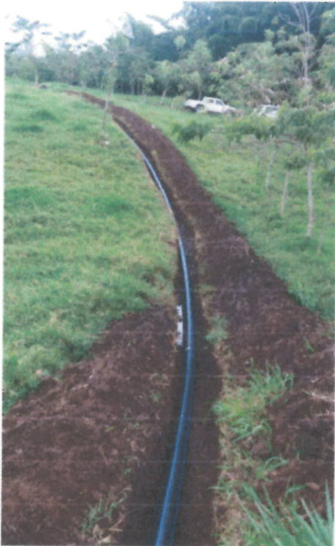
Foto 5 y 6. Instalación en sitio de tubería PF de 6"
