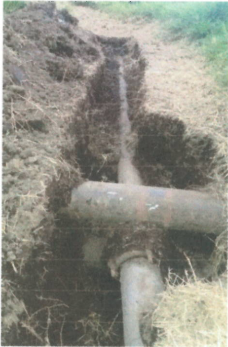
Foto 3 y 4. Excavación brecha para instalación tubería PF 6".
