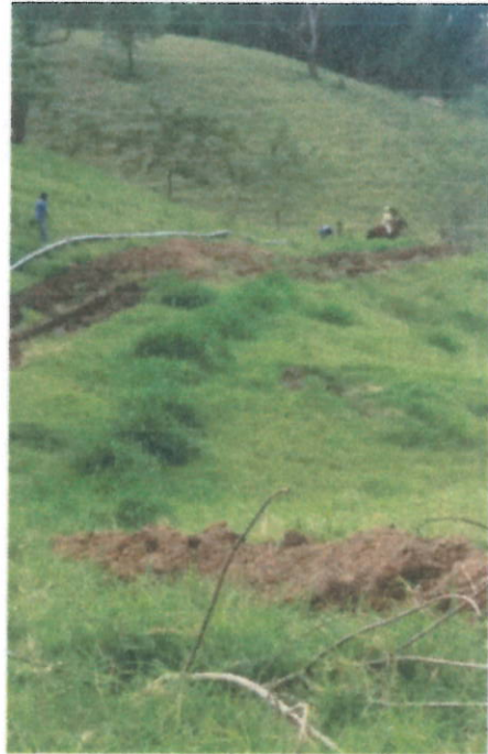
Foto 3 y 4. Excavación brecha para instalación tubería PF 6".
