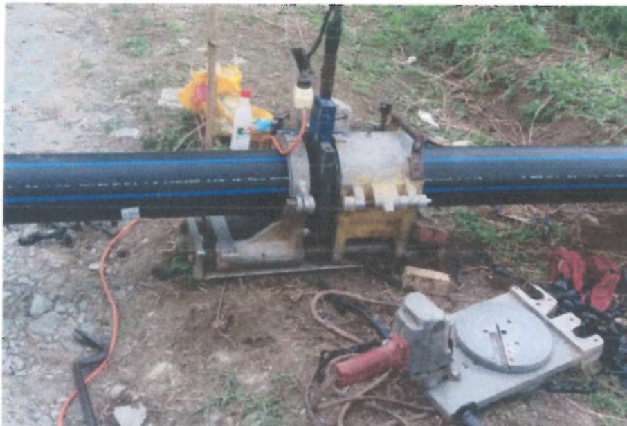
Foto 2. Termo fusión de tubería PF de 6"
