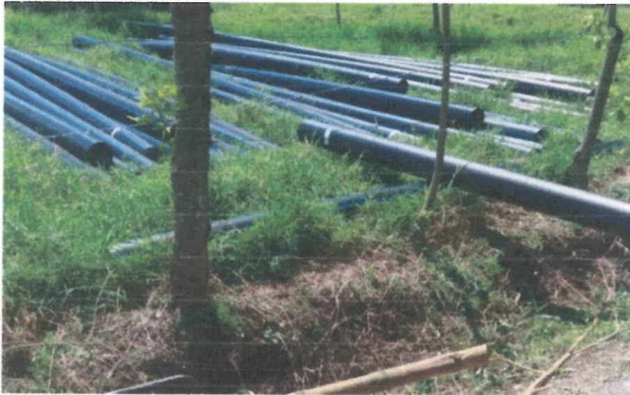
Foto1. Comienzo armado de tubería PF 6" de acueducto para instalación en brecha.
