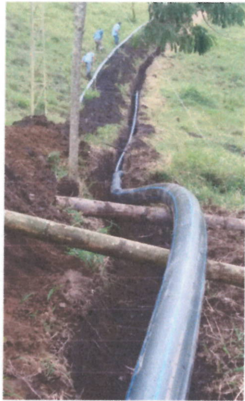
Foto 5 y 6. Instalación en sitio de tubería PF de 6"
