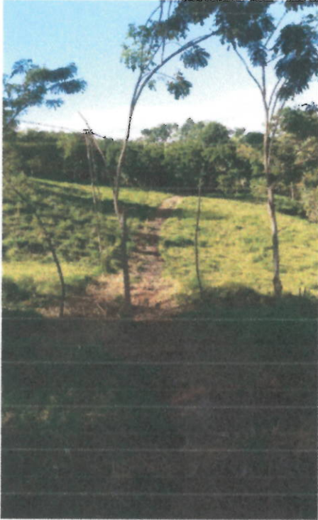
Foto 7 y 8. Llenos con material proveniente de la excavación apisonado y terminado
