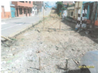
Vista de la zona a intervenir antes de iniciar los trabajos carrera 11
