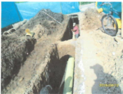
Vista instalación tubería PVC de 12" red madre
