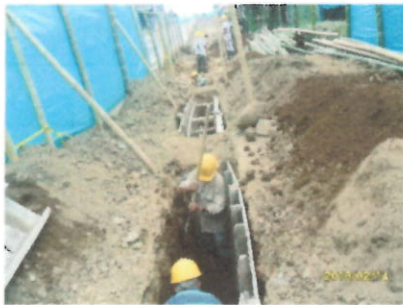
Entibados: como la zanja es alta se ejecutó un entibado para proteger el talud
