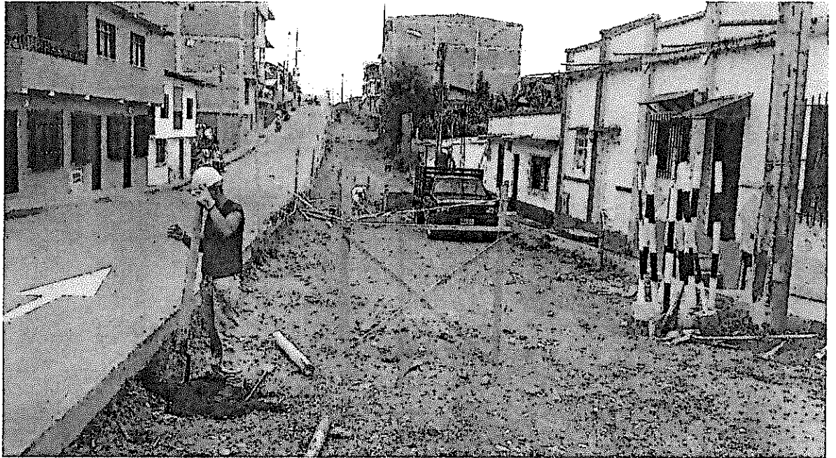
INICIO DE ACTIVIDADES OBRA 2
