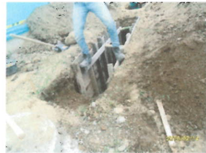
Entibados: como la zanja es alta se ejecutó un entibado para proteger el talud
