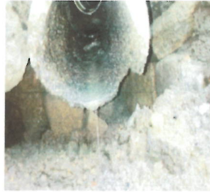
Vista instalación tubería PVC de 6" domiciliarias
