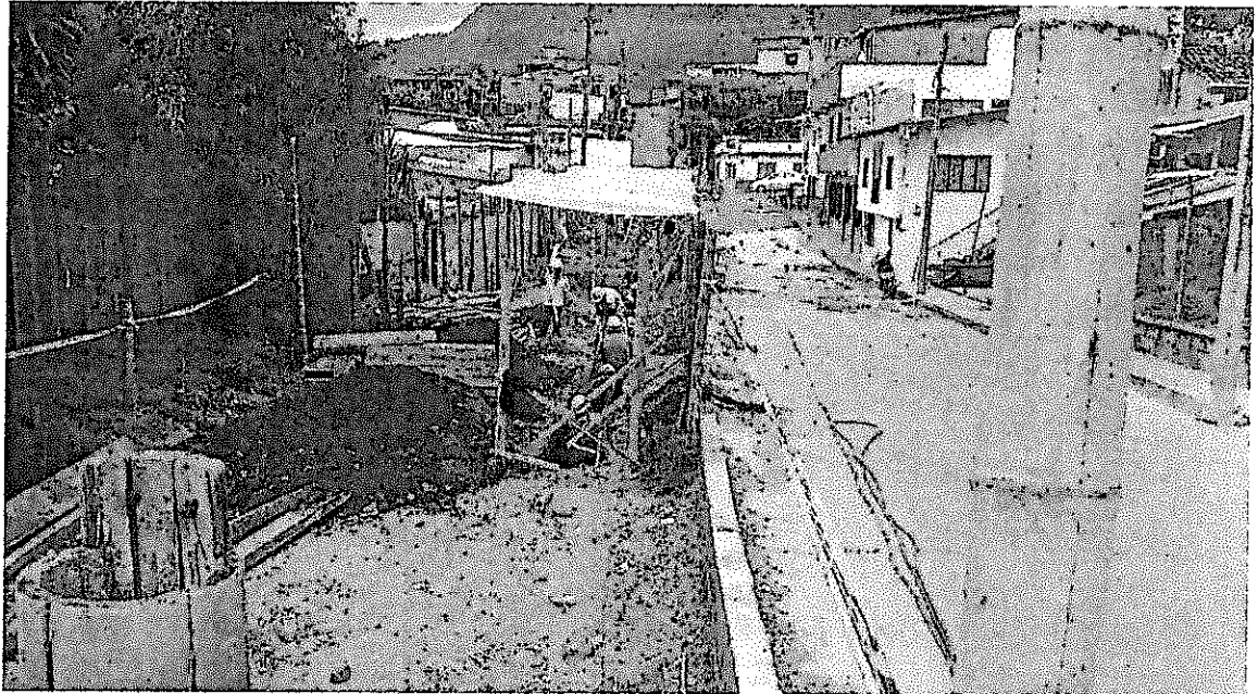
PROCESO DE EXCAVACION PARA INSTALACIÓN DE TUBERIA OBRA 2
