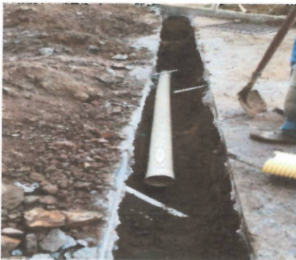
Vista instalación tubería PVC de la red madre sobre un colchón de arena
