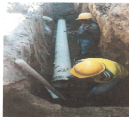
Vista instalación tubería PVC de la red madre sobre un colchón de arena
