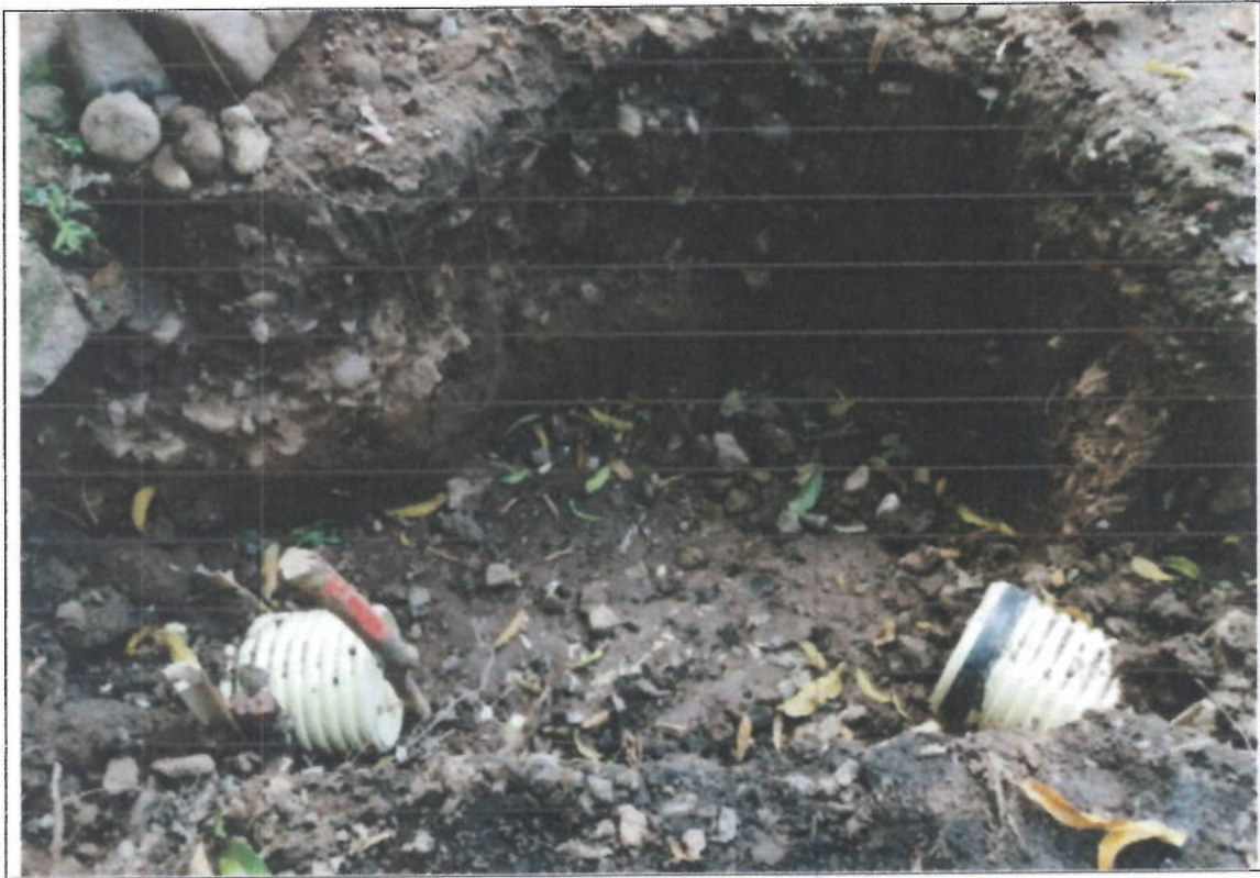
Construcción de aliviadero lateral
