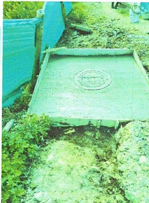
LOSA DE PARA TAPA DE CAMARA DE INSPECCIÓN
