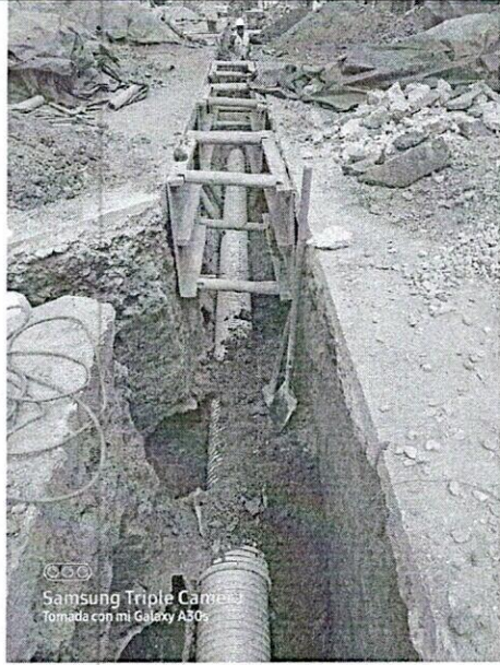
Instalación de Tubería y vaciado de Camara
