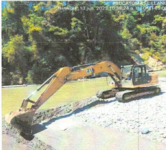
Ilustración 1: Movimiento de material para elaboración de Jarillón
