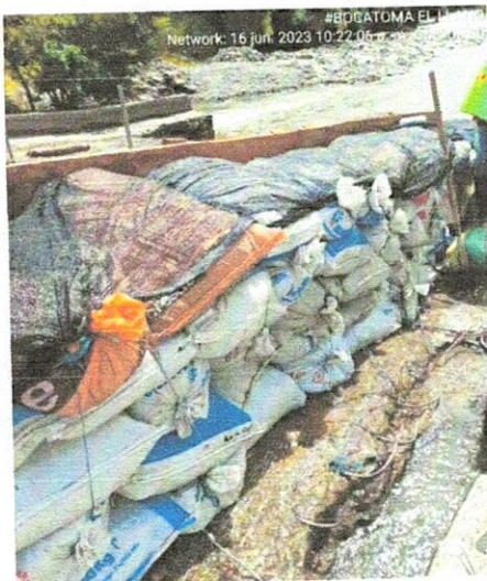
Ilustración 8: Elaboración de dique
