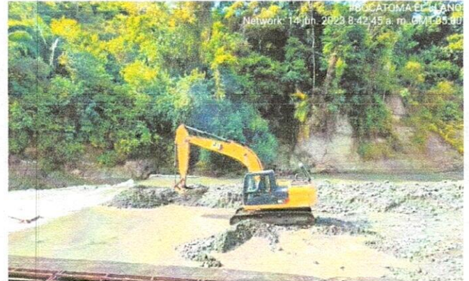
Ilustración 2: Movimiento de material para elaboración de Jarillón
