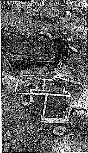
Proceso de reparación de tubería mediante termo fusión
