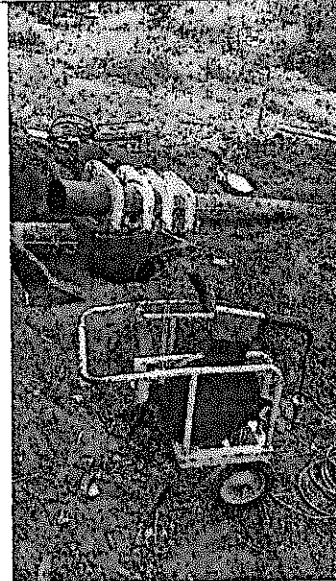
Proceso de reparación de tubería mediante termo fusión
