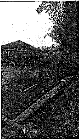
Proceso de reparación de tubería mediante termo fusión
