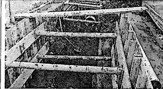
Entibados y demoliciones en el sitio de desviación de box
