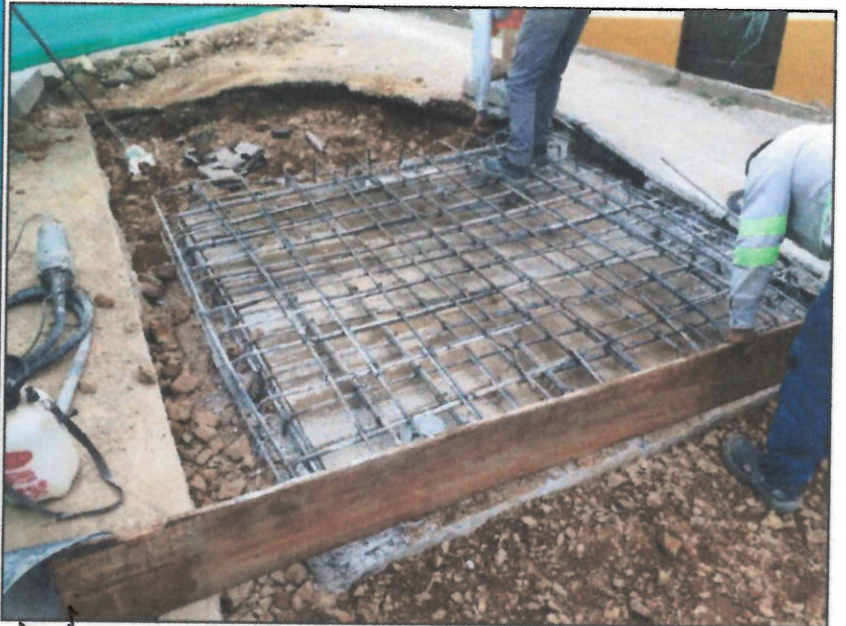
REPARACIONES EN LA CARRERA 4 DIAGONAL 9
