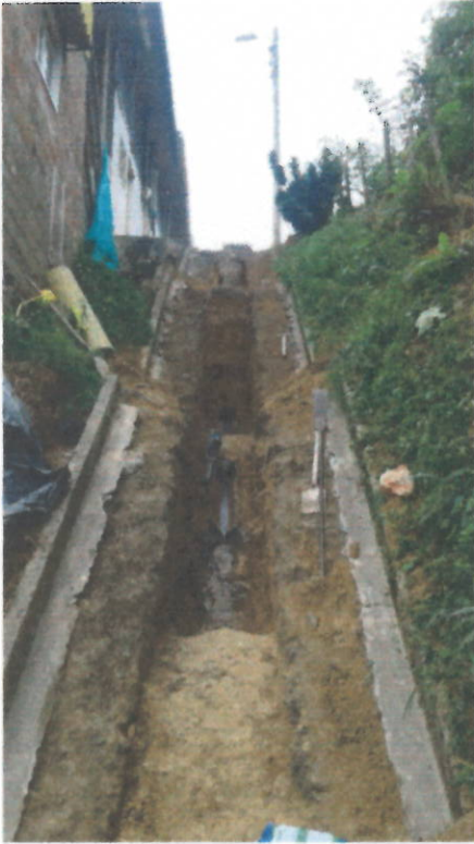
Demolición escaleras-pisos-sardinel.
