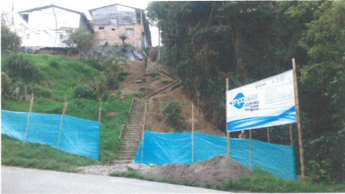
Instalación de valla en la obra
