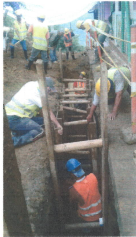
Excavaciones material común.
