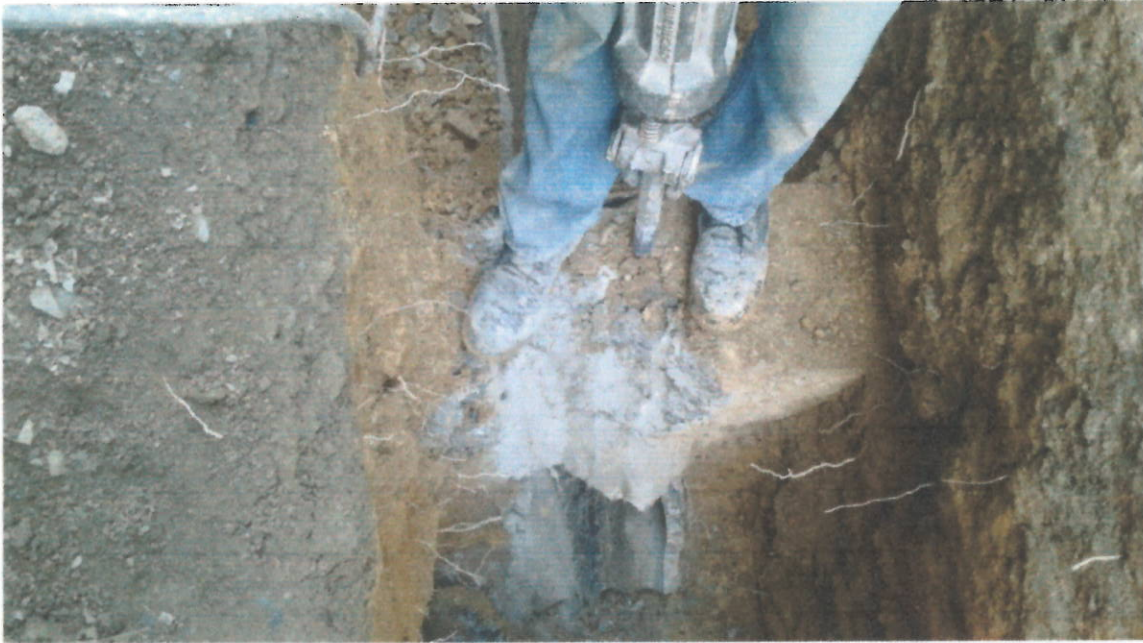
Demolición de atraques tubería.
