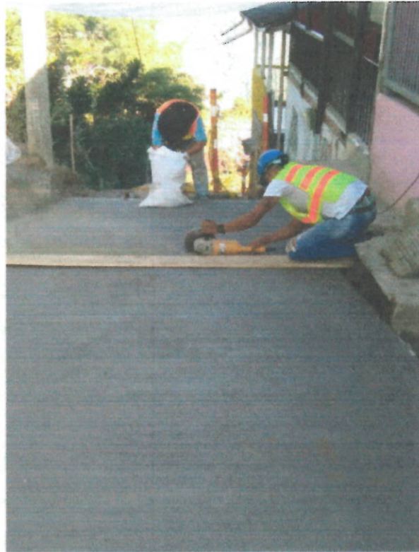
Corte mecanizado de pavimento.
