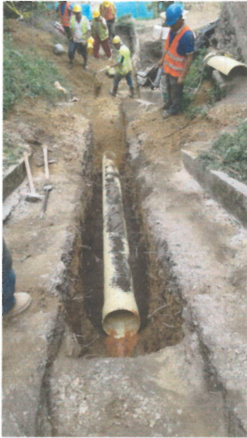
Sustitución arena limpia-Instalación tubería de 14".
