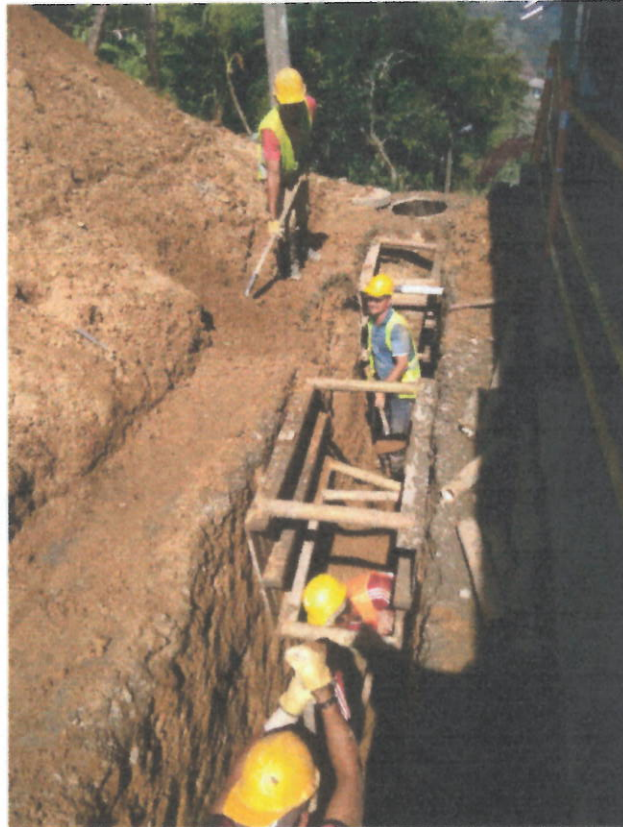
Excavación en zanja-material común.
