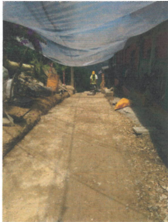
Instalación y compactación del material granular.
