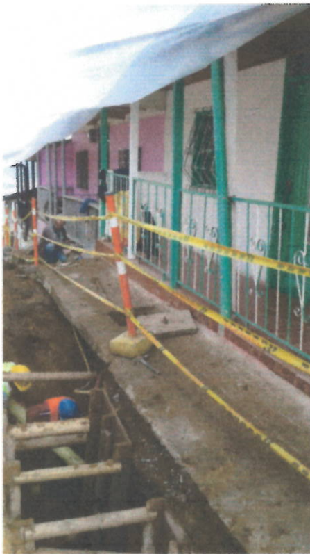
Señalización con cintas y bombones
