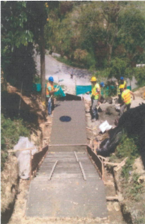
Fundición concreto escaleras.
