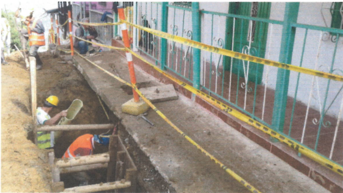
Instalación cañuelas domiciliarias tubería 6".
