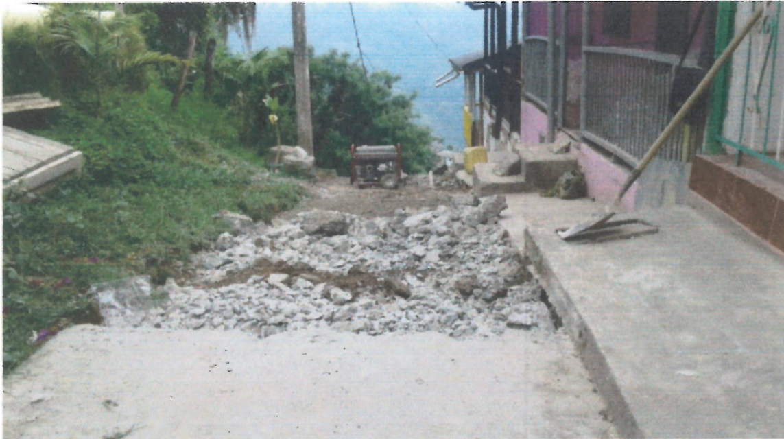
Demolición de pavimentos rígidos.
