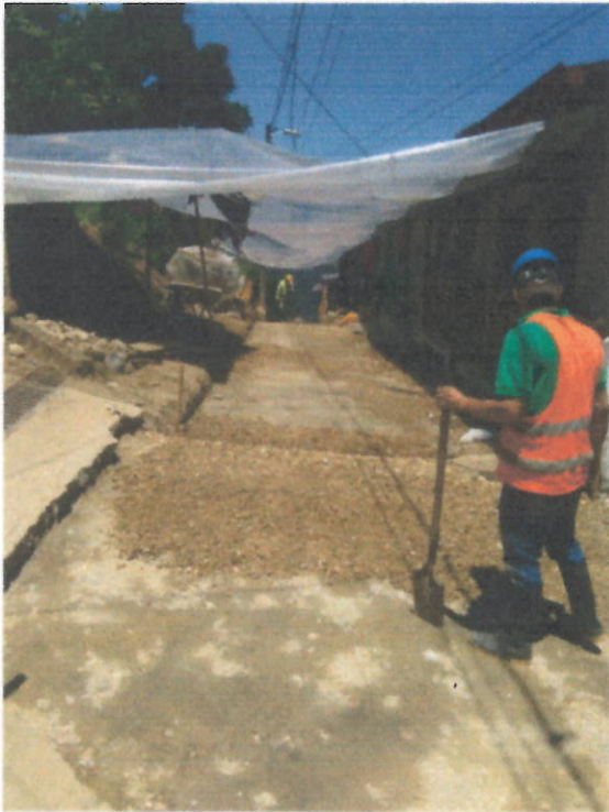
Instalación y compactación del material granular.
