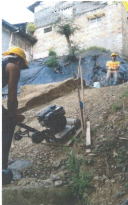
Compactación mecánica del material.
