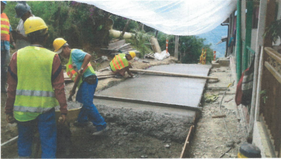
Fundición concreto pavimento.
