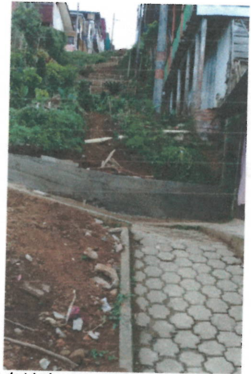
Foto 7 y 8. Llenos en excavación y construcción de trinchos para estabilización y finalización de la obra.
