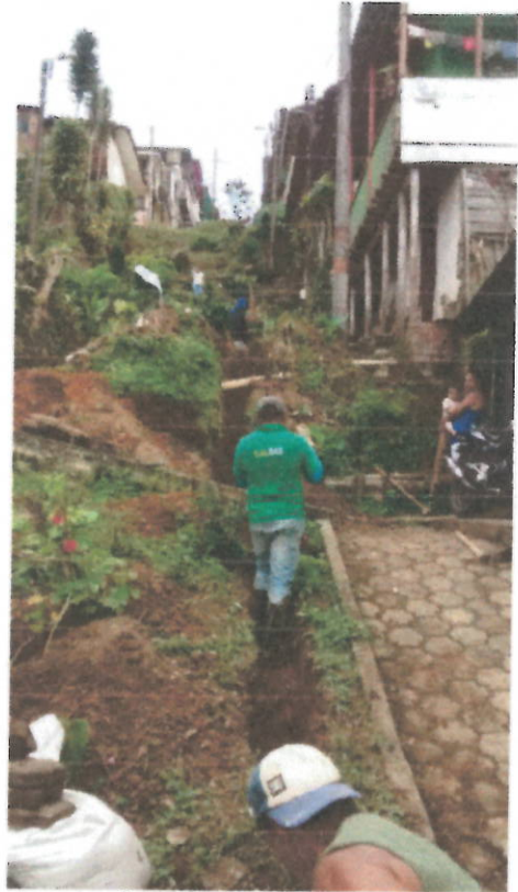
Foto 3 y 4. Excavación para instalación de tubería RD 21 de 2".
