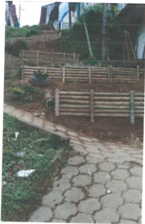
Foto 7 y 8. Llenos en excavación y construcción de trinchos para estabilización y finalización de la obra.
