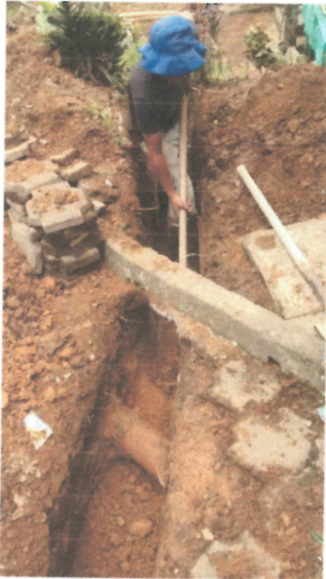
Foto 3 y 4. Excavación para instalación de tubería RD 21 de 2".
