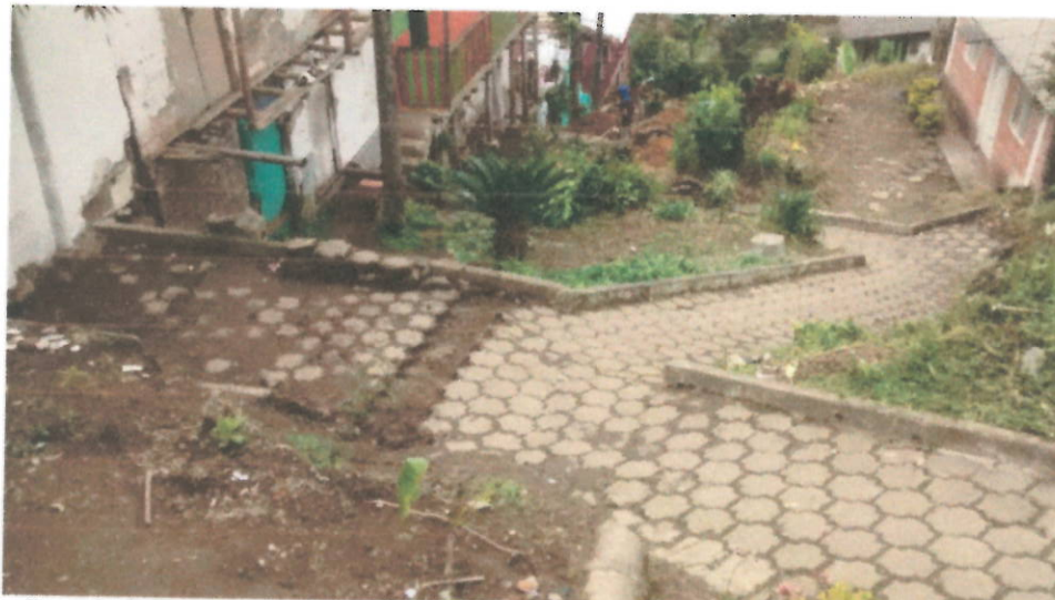
Foto 2. Comienzo de localización, replanteo y excavación de brecha para tubería.
