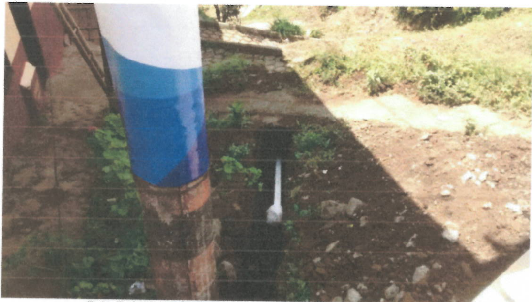
Foto 5. Instalación de tubería RD 21 de 2" de unión mecánica.
