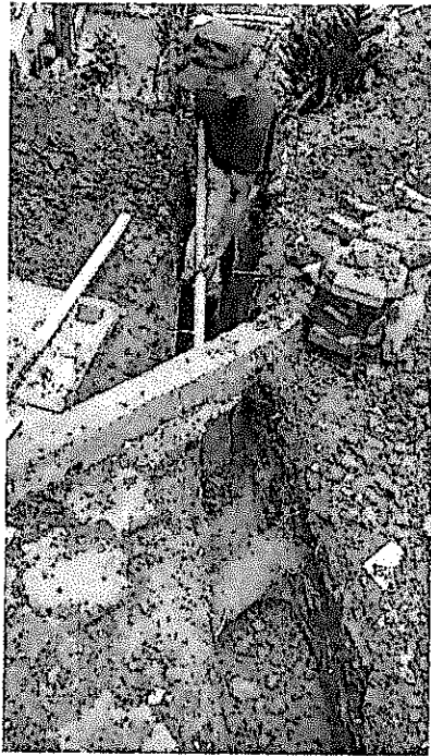
Actividades de excavación y retiro de adoquines sobre peatonal
