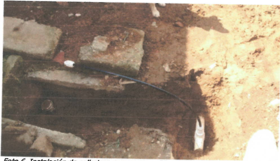
Foto 6. Instalación de collarines y mangueras PF para domiciliarias de acueducto.
