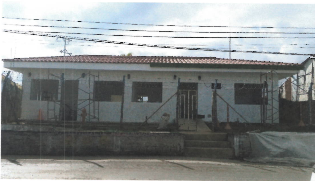
Estado en el que se encuentra la planta después de las intervenciones de las obras hasta el mes de mayo.
