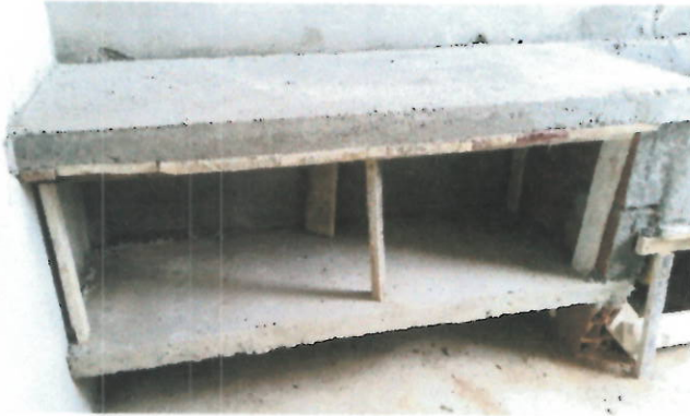
Detalle de mesón vaciado.
