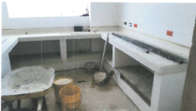
Instalación y pulido de la mezcla.
