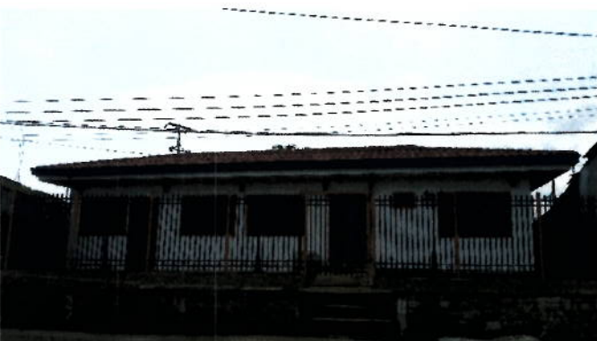
Vista general del cerramiento completo.
