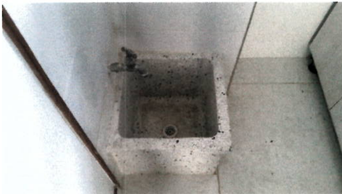
Instalación de poceta junto a la cocineta para el lavado de traperos.
