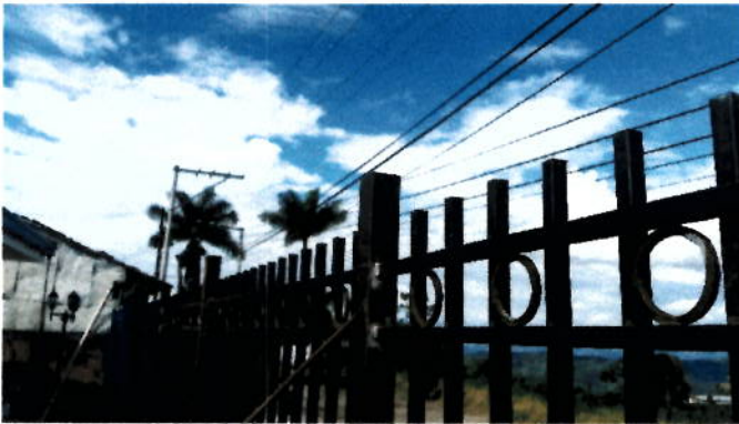
Instalación del cerramiento.
