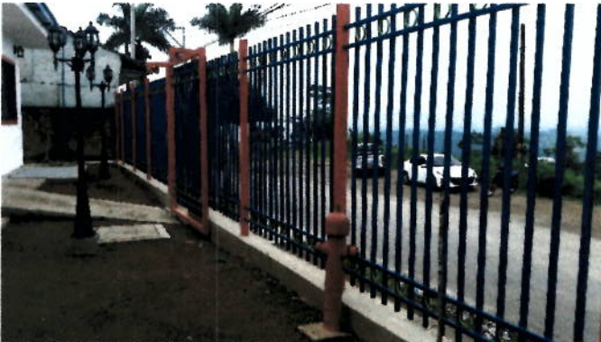
Pintura y detallado del cerramiento.
