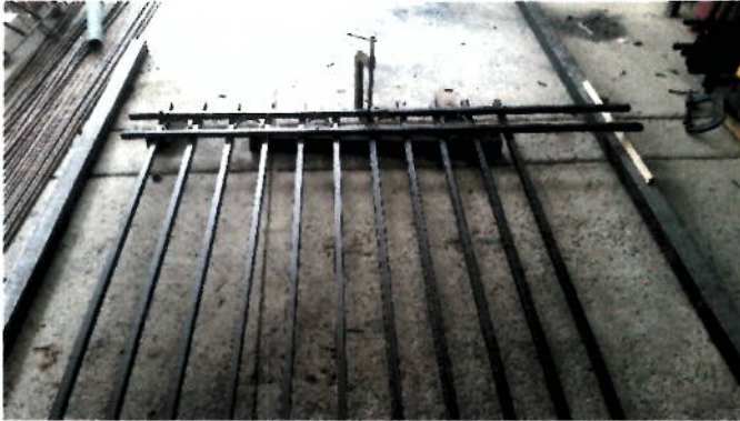
Fabricación del cerramiento.
