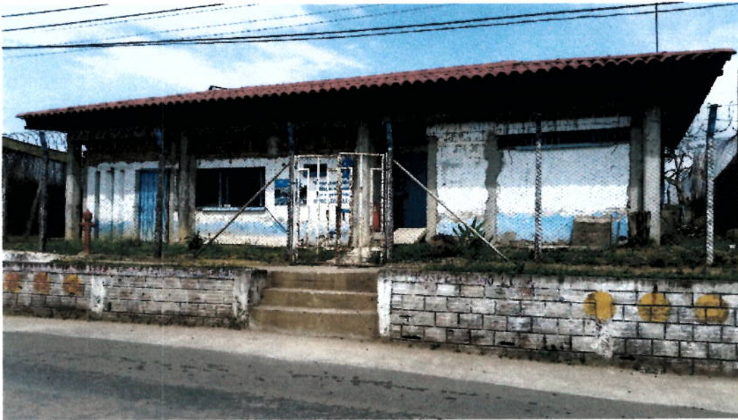
Estado en el que se encontraba la planta.
