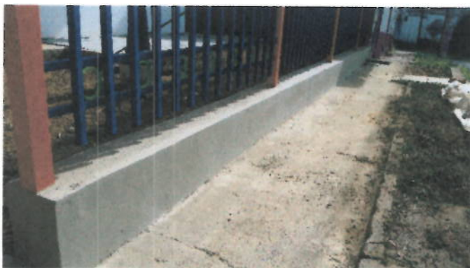
Construcción de muro sardinel, sección mas grande.
