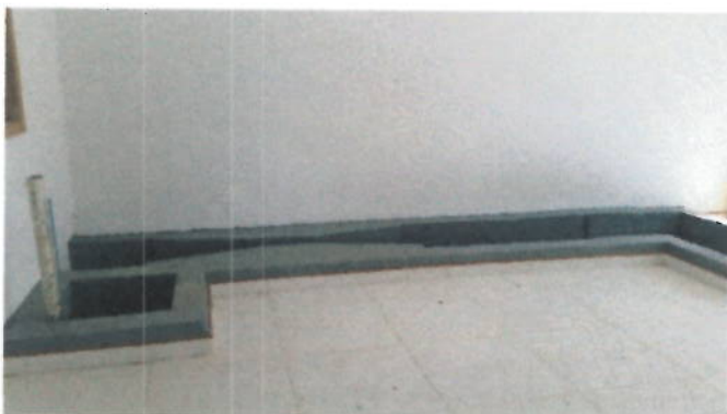
Vista general de la canaleta después de los trabajos realizados.
