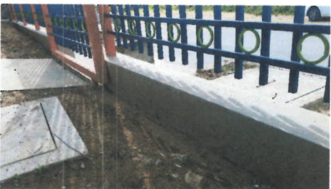
Vista general del acabado interno del muro sardinel.
