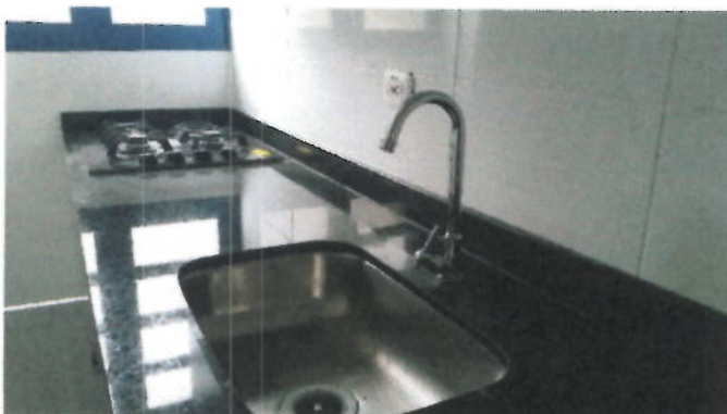
Instalación de estufa y grifería.
