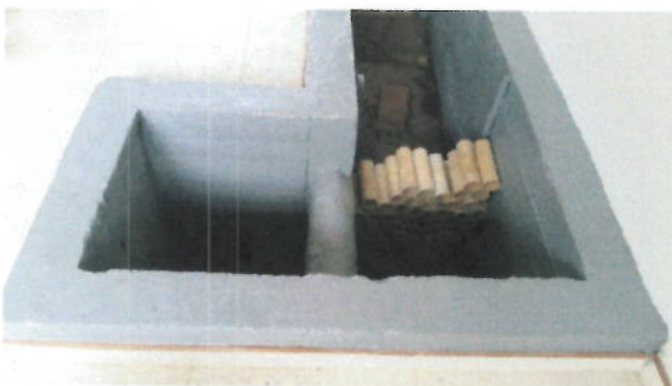
Limpieza, adecuación y aplicación exterior de pintura epóxica, pintucoat.
