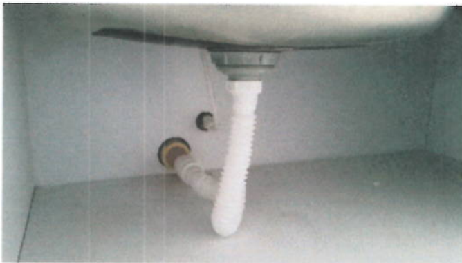
Instalación de lavaplatos en acero inoxidable y el sistemas hidráulico y sanitario.
