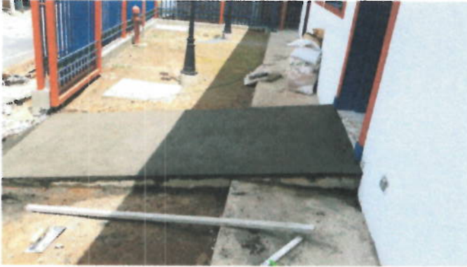
Instalación de mortero.
