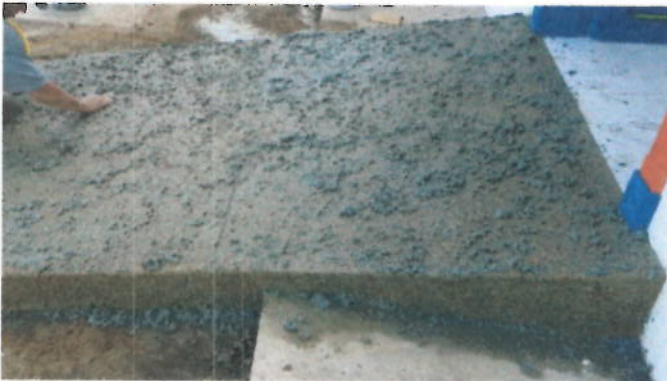
Limpieza de granito con carnaza.
