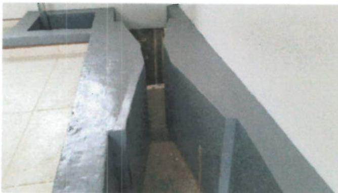
Limpieza, adecuación y aplicación interior de pintura epóxica, pintucoat.
