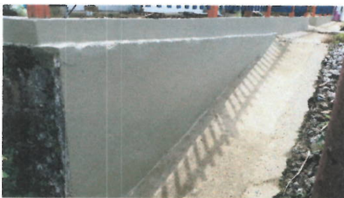
Construcción de muro sardinel, sección mas pequeña.
