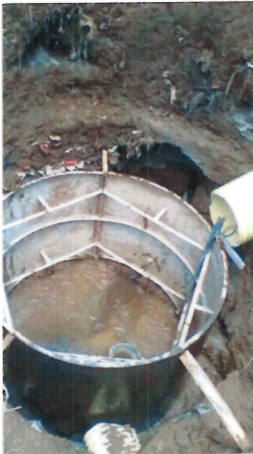
Suministro, Transporte e instalación de Cámara Circular de Inspección
