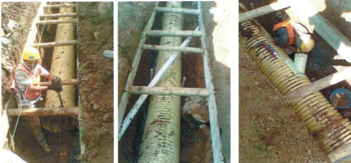
Suministro e instalación de Tubería PVC Corrugada para alcantarillado
