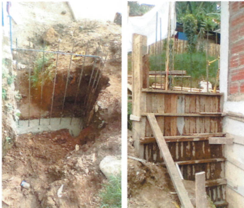
Construcción de muro
