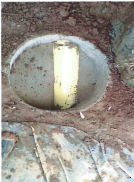
Suministro e Instalación Caja de Inspección
