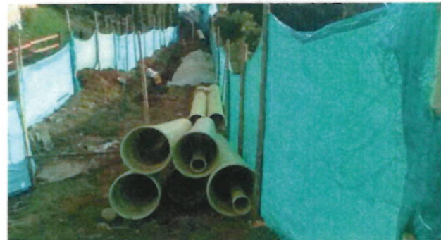
Suministro e instalación de Tubería PVC Corrugada para alcantarillado
