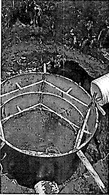
Suministró, Transporte e instalación de Cámara Circular de Inspección
