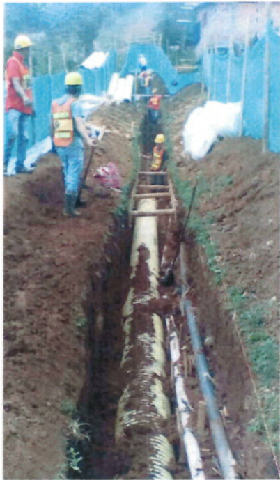
Suministro e instalación de Tubería PVC Corrugada para alcantarillado
