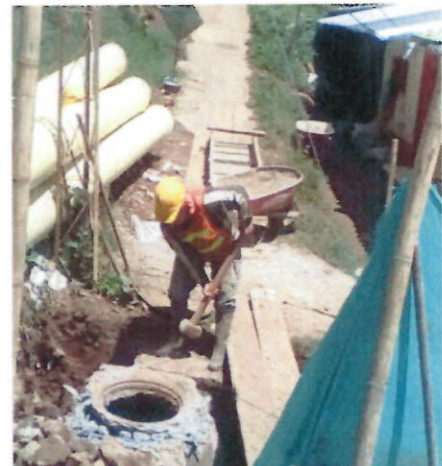
Demolición de pavimentos Asfálticos e Hidráulicos, andenes y cámaras
