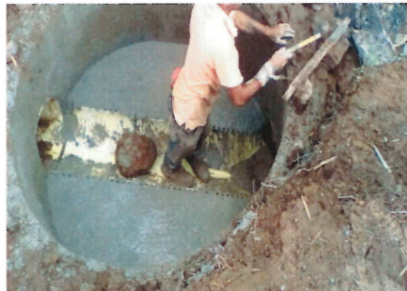
Suministro, Transporte e instalación de Cámara Circular de Inspección
