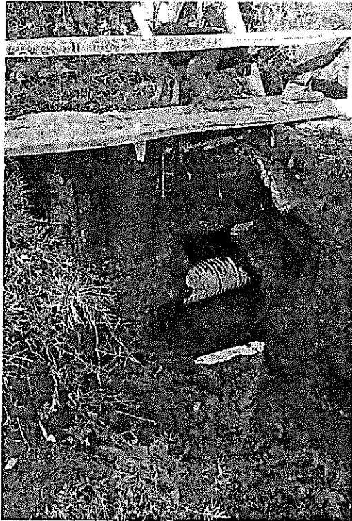
Colapso en la red de alcantarillado
