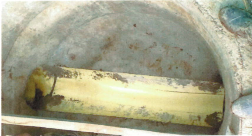
Suministro e Instalación Caja de Inspección
