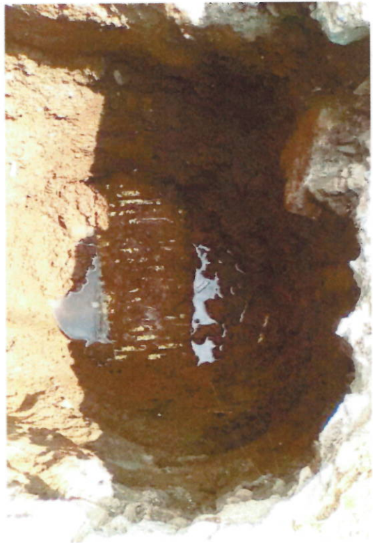
Colapso en la red de alcantarillado
