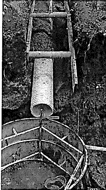
Suministró, Transporte e instalación de Cámara Circular de Inspección
