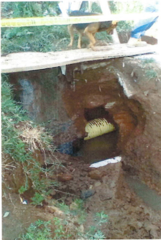
Colapso en la red de alcantarillado
