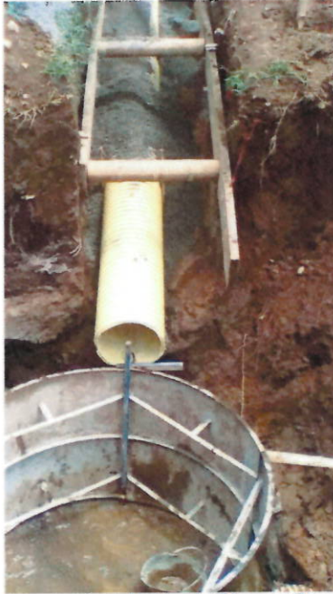
Suministro, Transporte e instalación de Cámara Circular de Inspección
