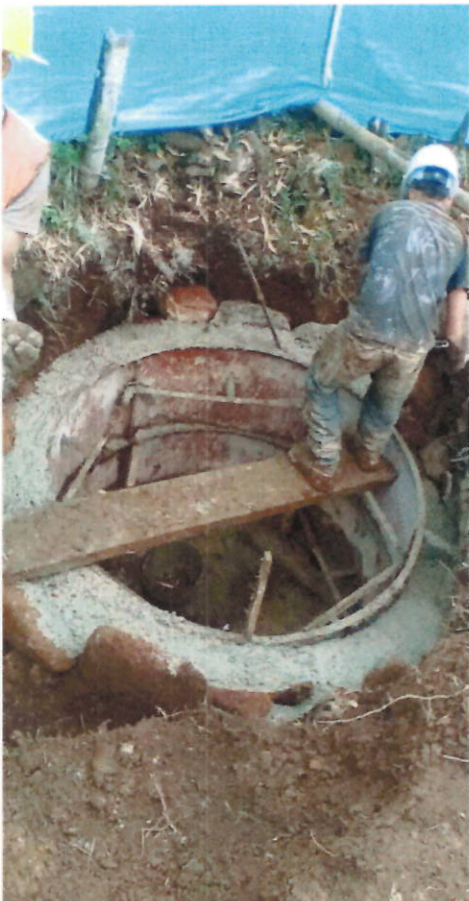
Suministro, Transporte e instalación de Cámara Circular de Inspección
