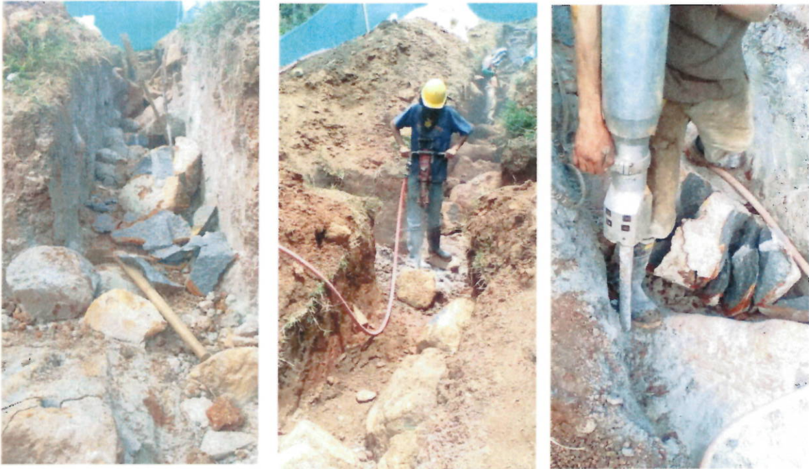
Demolición de rocas de gran tamaño (incluye compresor, martillo y darda hidráulica)
