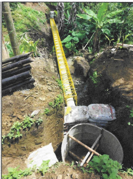
Fotografía 6. Estructura metálica para viaducto
