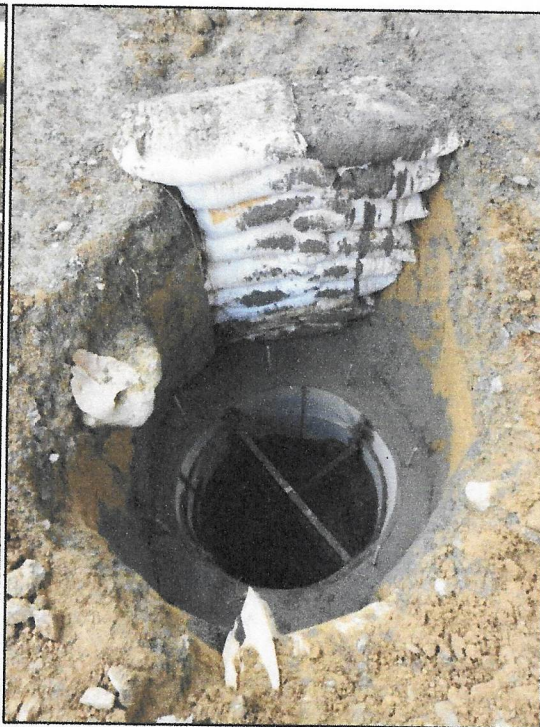
Fotografía 10. Instalación de refuerzo cámaras de inspección. C22
