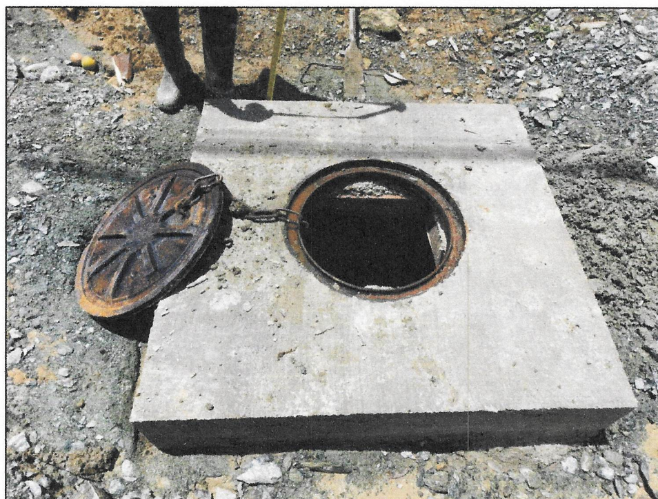
Fotografía 7. Losa en concreto reforzado para instalación de tapa HF sobre vía. 1,20 x 1,20m. Cámara 20
