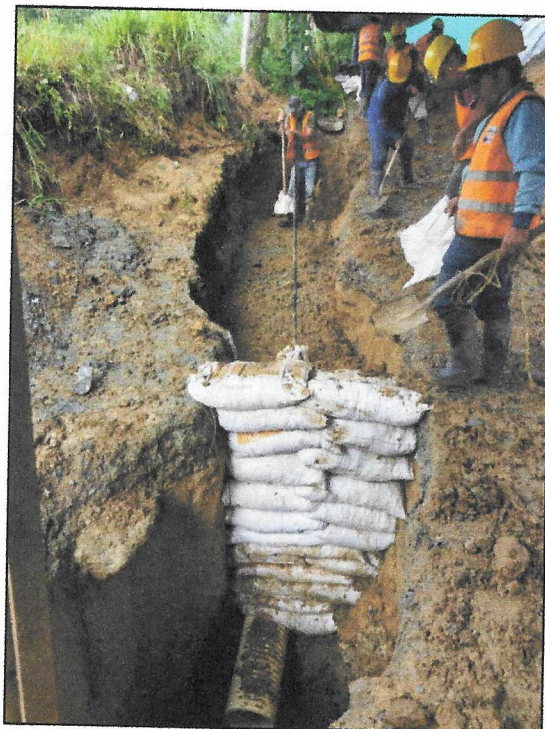
Fotografía 12. Instalacion de tuberia tramo camara 19 – aliviadero. Sobreexcavacion por derrumbe.
