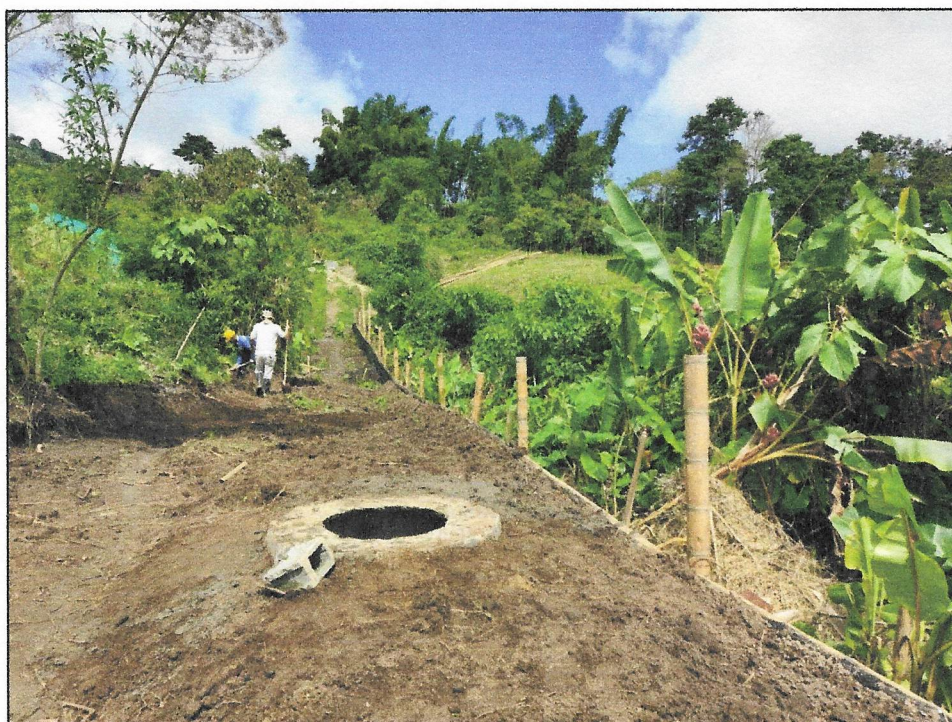
Fotografía 4. Instalación de trinchos en guadua. Vista desde cámara 25.
