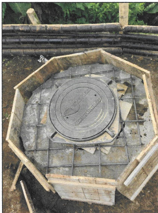
Fotografía 3. Losa en concreto reforzado para instalación de tapa HF. D=1,2m. Cámara 25
