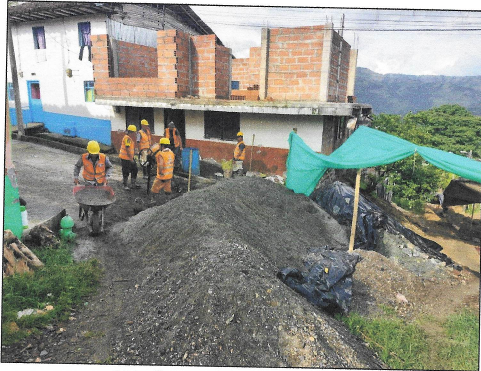
Fotografía 11. Disposición de Material para obra.
