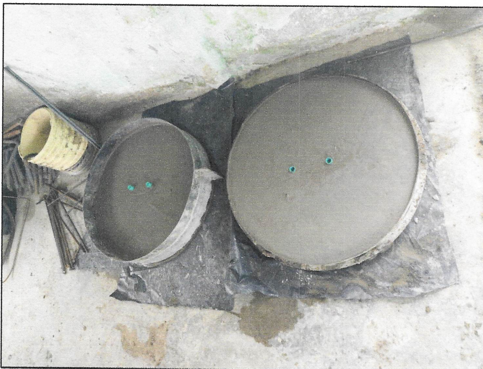
Fotografía 2. Tapas en concreto D=0,7m
