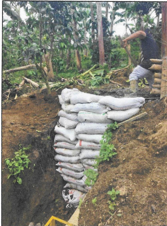
Fotografía 1. Instalación de costales de tierra para contención de zanja. Cámara 27
