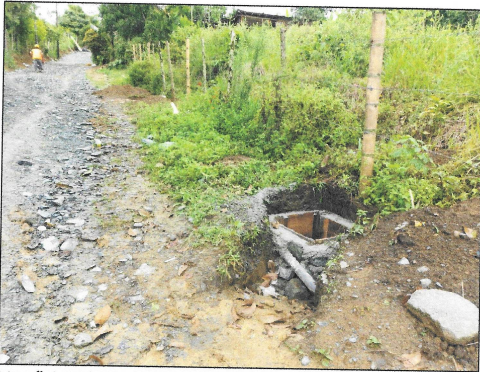
Fotografía 8. Instalación de acometidas domiciliarias sobre carrera 3. Vista cajas de inspección.
