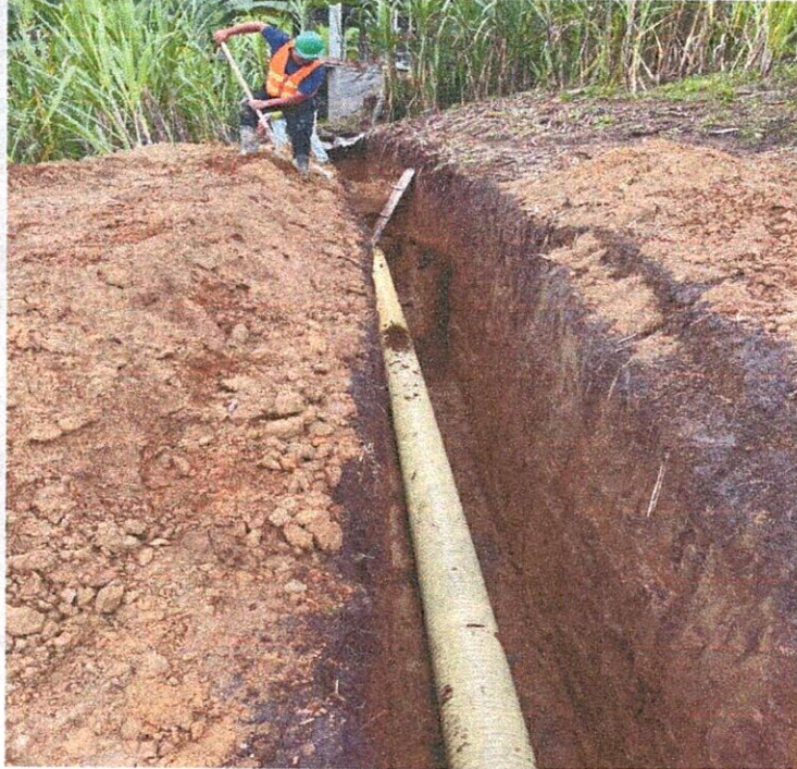
Descapote, excavación e instalación de tubería 12" corrugada
