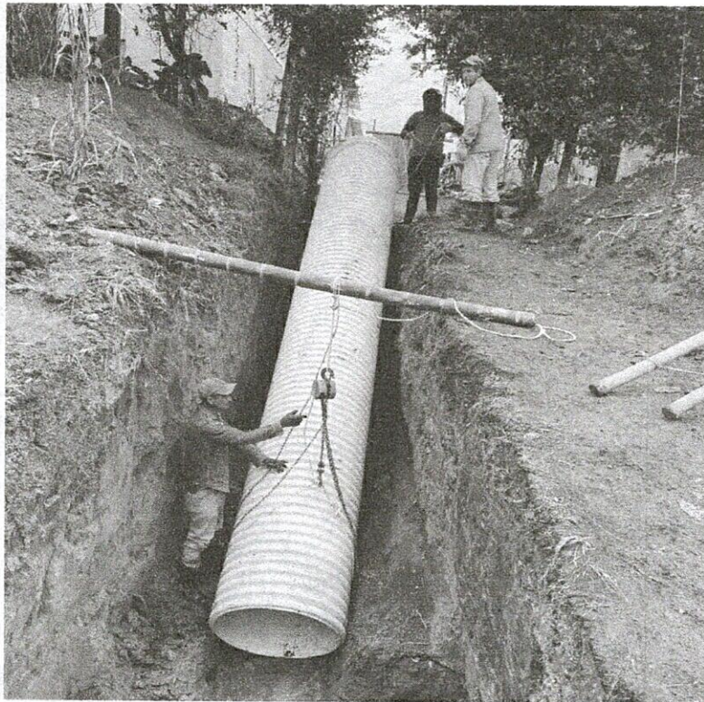
Instalación de tubería de 33"
