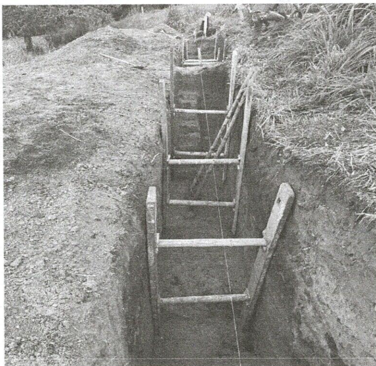
Excavación y entibado para instalación de tubería de 12" corrugada
