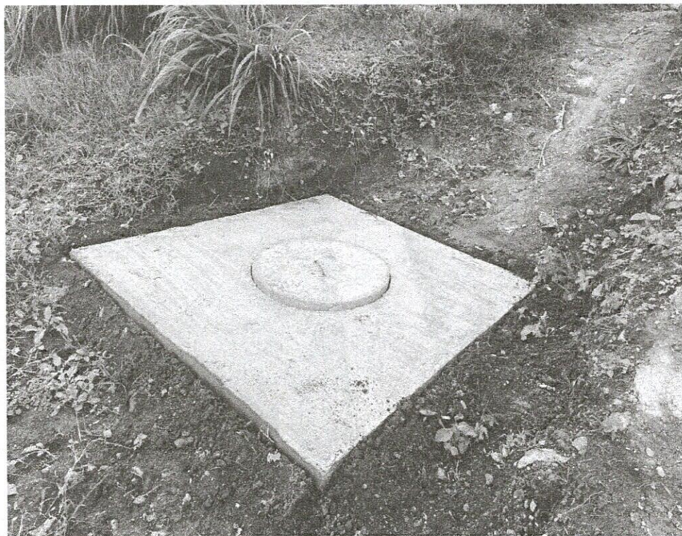
Terminado final cámara de transición de 1,5 m de diámetro
