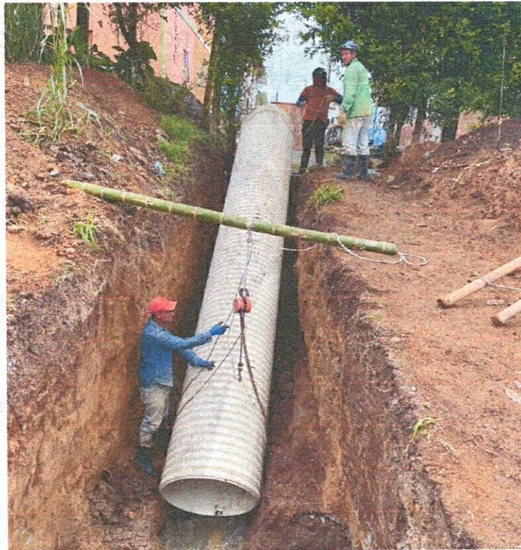
Instalación de tubería de 33"
