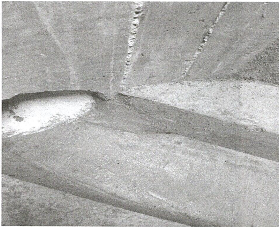
Emboquillado de tubería de 12" corrugada
