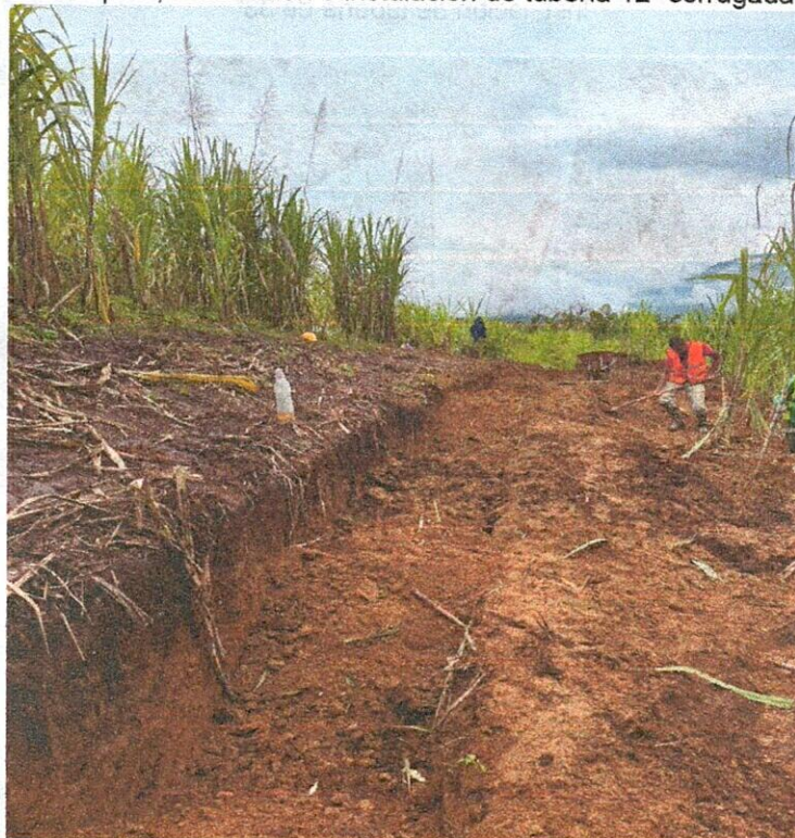
Lleno con material de excavación
