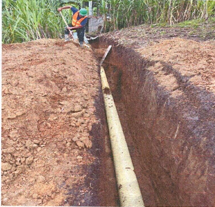
Descapote, excavación e instalación de tubería 12" corrugada
