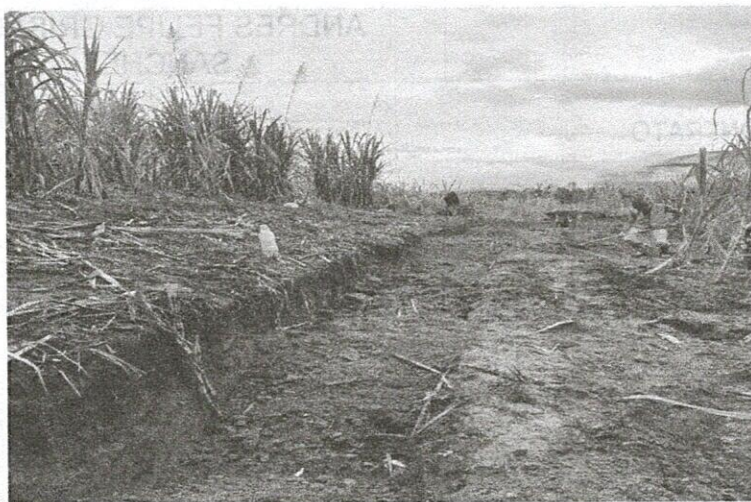
Lleno con material de excavación
