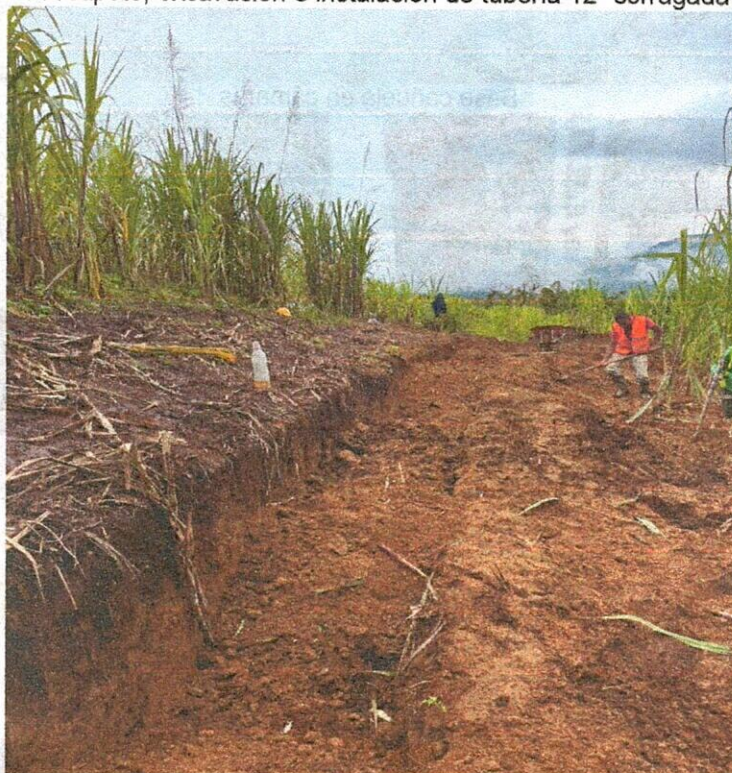
Lleno con material de excavación
