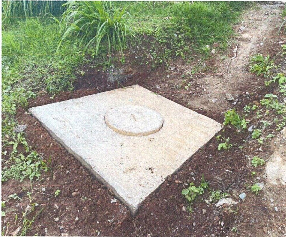
Terminado final cámara de transición de 1,5 m de diámetro
