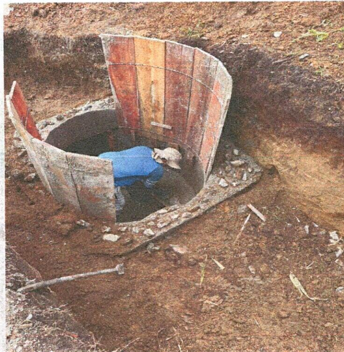
Construcción de cámara de transición de tubería a box
