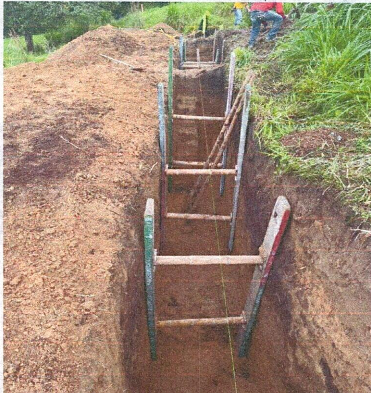
Excavación y entibado para instalación de tubería de 12" corrugada
