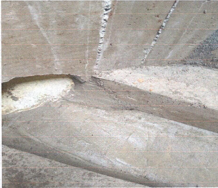
Emboquillado de tubería de 12" corrugada
