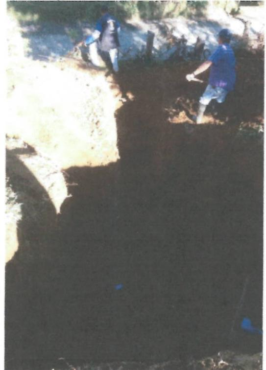
Foto 1 y 2. Excavación para tubería de 18" en borde de vía
