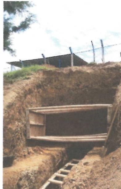
*Foto 7 y 8. Instalación tubería de 18" con arena limpia y entibados en excavación.*
