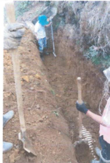
Foto 3 y 4. Excavación, intalacion de tubería de 18" y llenos en borde de vía.
