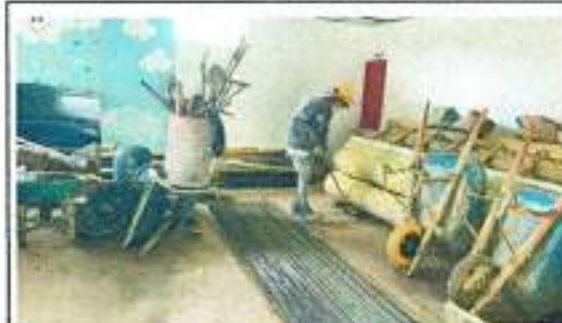
Limpieza y adecuación de bodega
