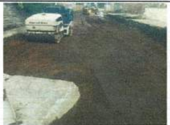
Avances de obra
