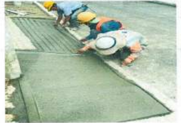
Arreglo de andenes dañados
