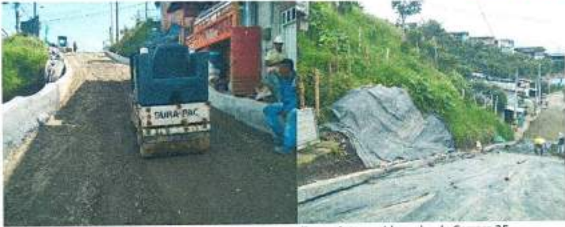
Protección de talud con plástico negro en predios no intervenidos sobre la Carrera 2E.
