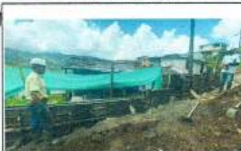
Fundida del 2 muro de contención
