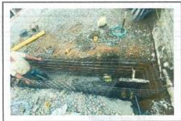
Avances de obra
