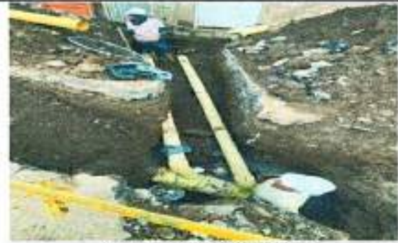
Avance de obra (Domiciliarias)
