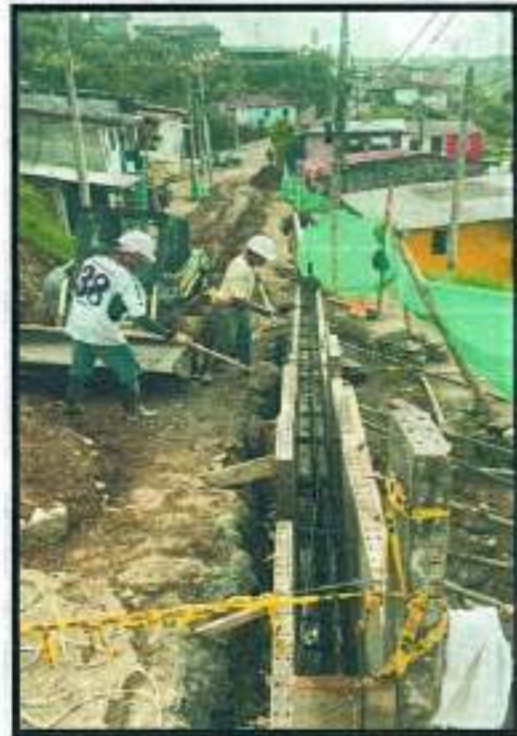
Fotografía Nro. 8. - Baseo de muro #2
