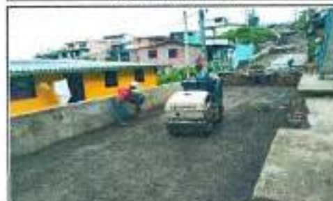
Compactación de la base de reposición
