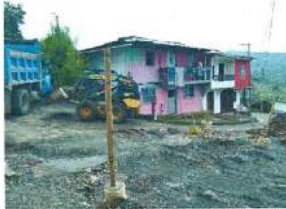
Retiro de material en vehículo automotor, el cual gran cantidad significativa era de tipo subbase y base granular que se sustituyo por incremento de humedad natural.
