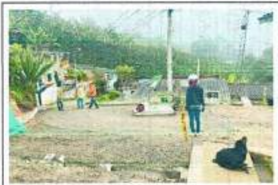
Aseo y adecuación de la obra
