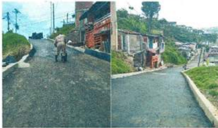
Ilustración 2. Aplicación de emulsión asfáltica, 18-07-22.
