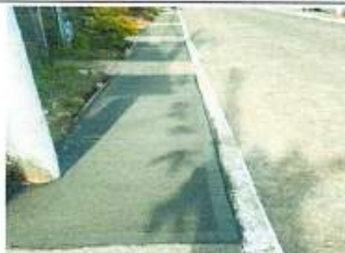
Realización de andenes
