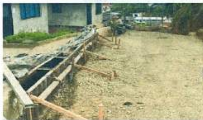
Avance de obra (Formaleta para bordillos)
