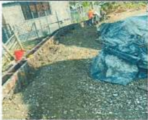
Avances de obra
