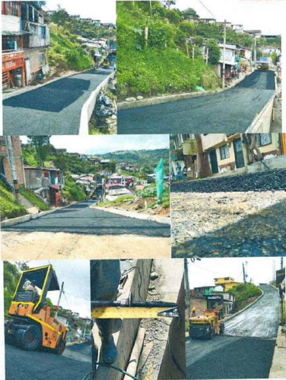
Pavimentación del tramo 3, con mezcla densa en caliente – 19 y espesor de 7 cm de acuerdo con el diseño del pavimento flexible aprobado por la supervisión técnica.
