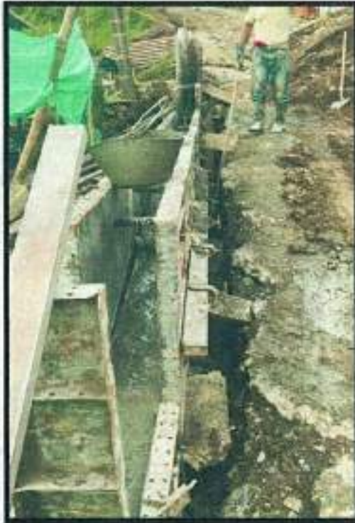
Fotografía Nro. 7. - Baseo de muro #1
