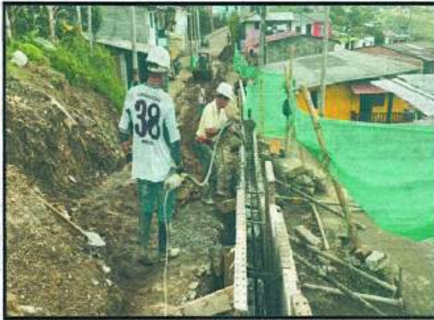
Fotografía Nro. 10. -Baseo de muro #2
