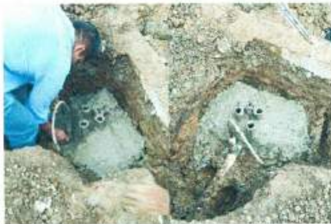
Finalmente en el daño de la tubería municipal se realiza un atraque en concreto y acero.
