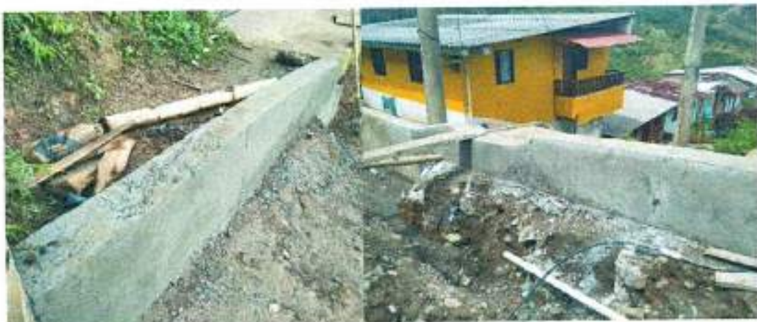
Deterioro de tapa en concreto de pozo séptico ubicado en la Calle 25A, Barrio: San Isidro.
