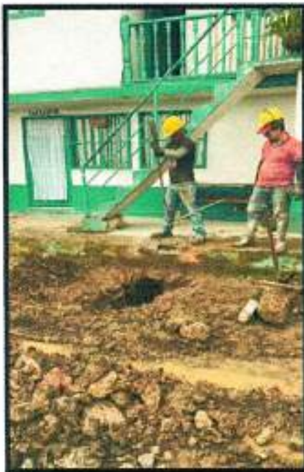
Fotografía Nro. 1 - excavación domiciliaria
