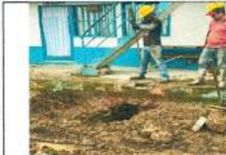
Excavación para caja de inspección
