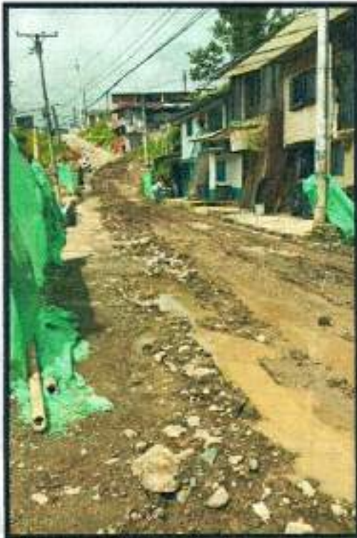
Fotografía Nro. 3. - deterioro del cerramiento
