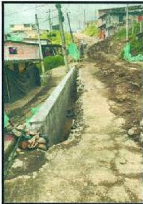
Fotografía Nro. 14. - Finalización muro
