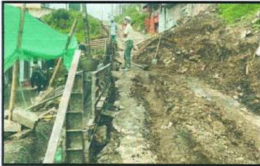
Fotografía No. 16. - Baseo de muro
