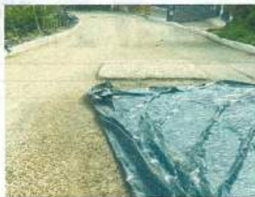
Limpieza y avance de obra
