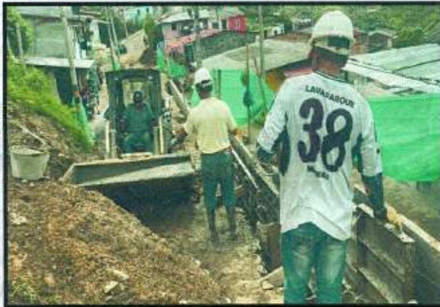
Fotografía Nro. 11. - Baseo de muro #2
