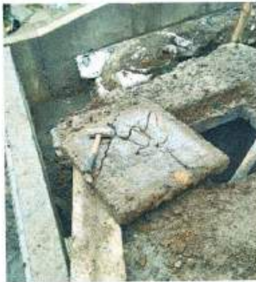
Deterioro de tapa en concreto de pozo séptico ubicado en la Calle 25A, Barrio: San Isidro.
