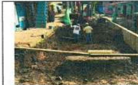
Excavación para reposición de tierra
