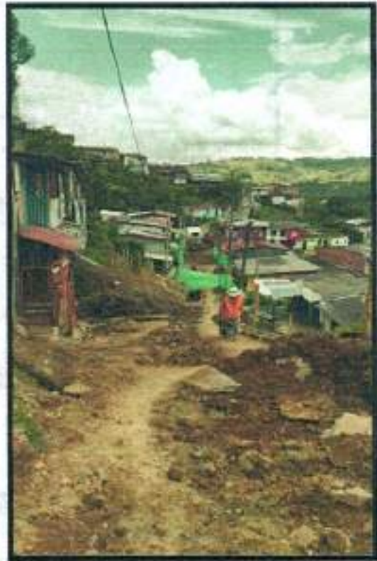
Fotografía Nro. 19. - Estado de obra
