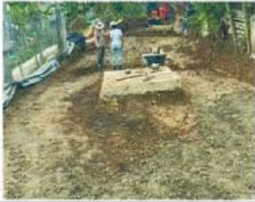
Recorridos de obra
