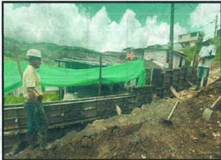
Fotografía Nro. 9. -Baseo de muro #2
