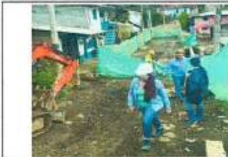
Cerramiento de obra
