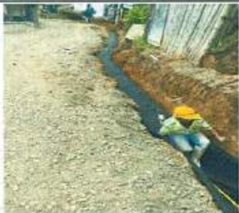
Avance de obra (filtro franses)
