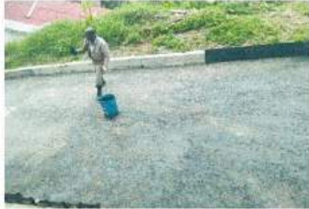
Ilustración 1. Aplicación de emulsión asfáltica, 18-07-22.
