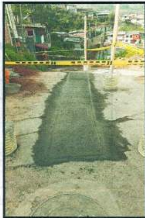
Fotografía Nro. 13. - Concreto reparación pavimento
