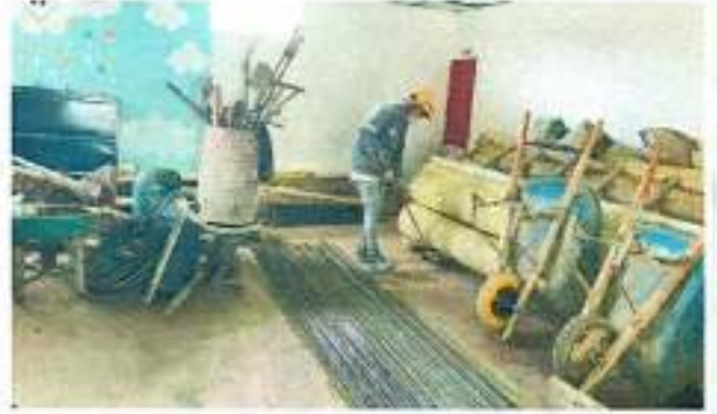
Aseo de la bodega
