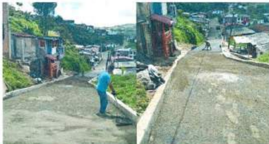
Ilustración 4. Aplicación de arena, 18-07-22.
