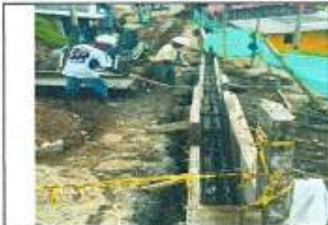
Fundida del 2 muro de contención
