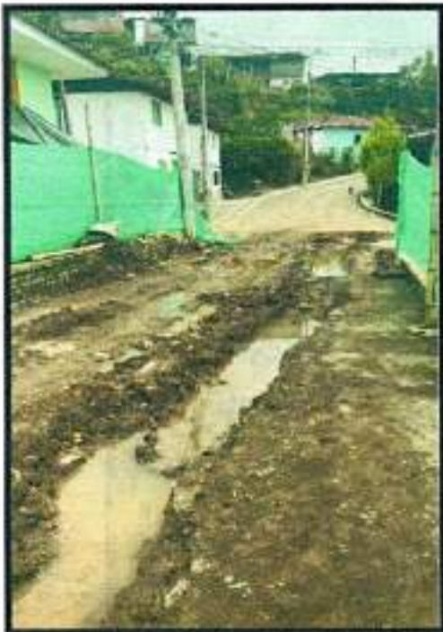
Fotografía Nro. 5. - Cerramiento de obra
