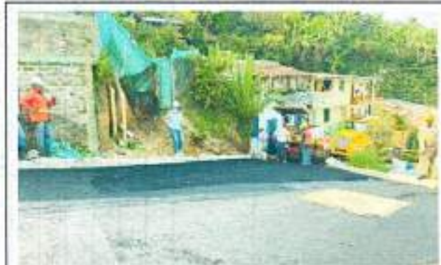
Uso adecuado de los epp durante la pavimentación
