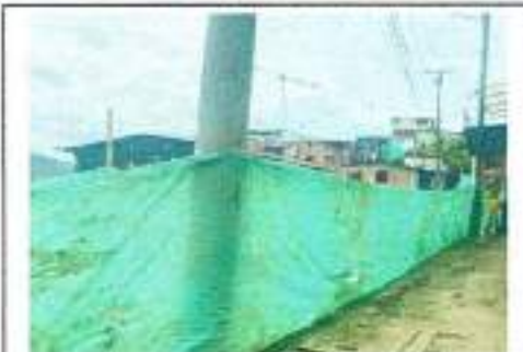
Cerramiento de obra
