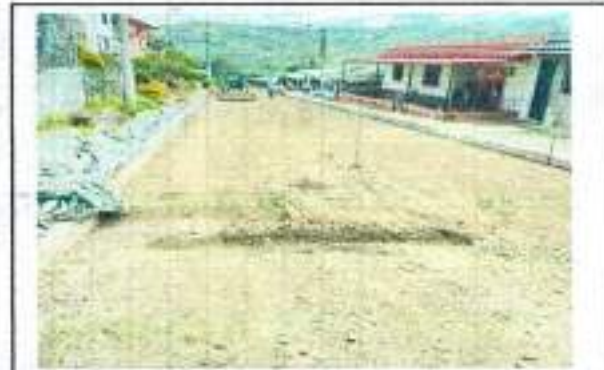
Limpieza de la obra
