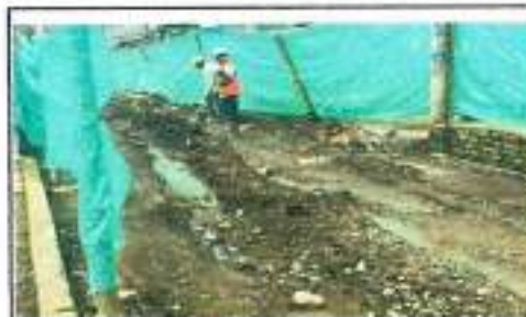
Cerramiento de obra
