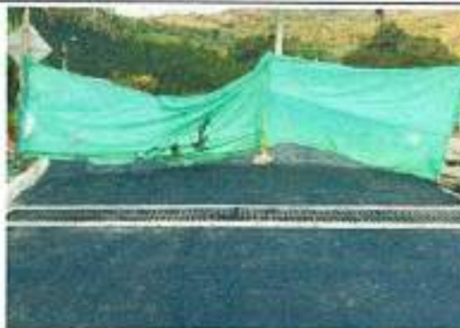
Cierre de vía
