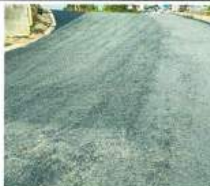
Pavimentación de la vía
