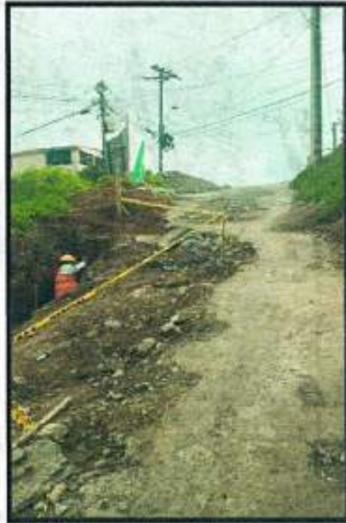
Fotografía Nro. 4. - excavación para muro
