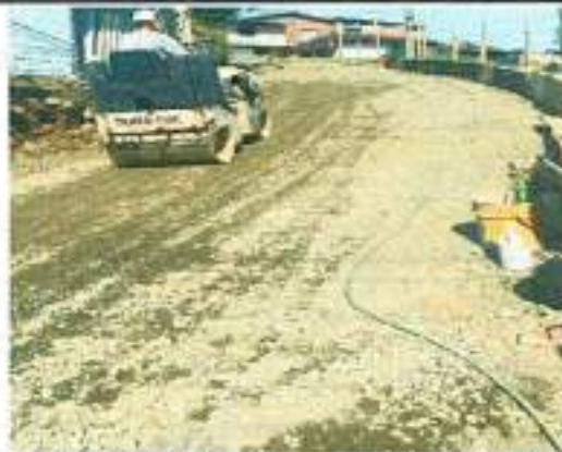
Avance de obra (compactación subbase)
