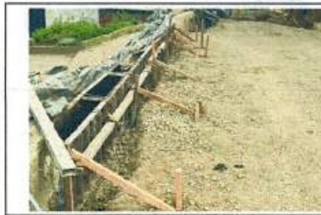
Limpieza de la obra
