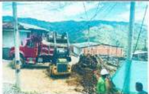
Actividades de obra
