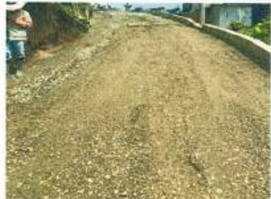
Limpieza de obra
