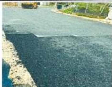
Pavimentación de la vía
