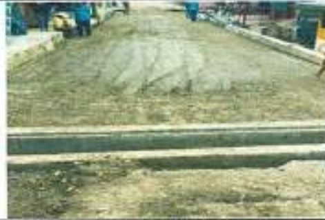
Compactación de base
