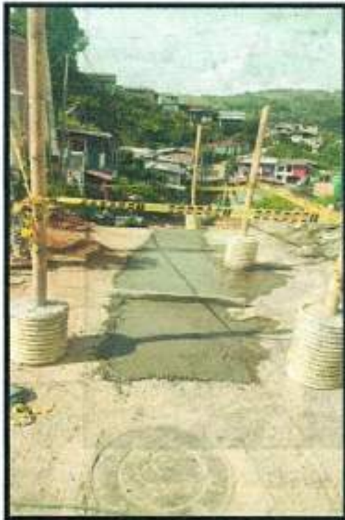
Fotografía Nro. 12. - instalación último tramo de tubería
