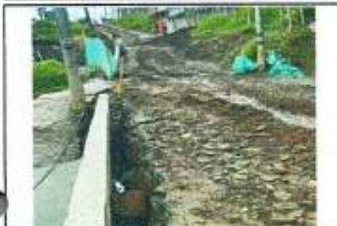
Estado de la obra
