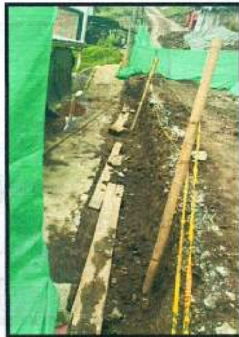
Fotografía Nro. 6. - Cerramiento de obra
