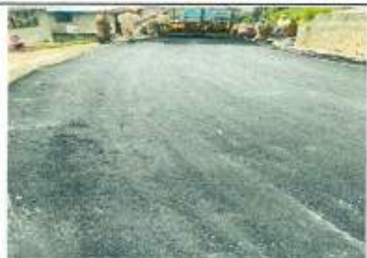
Pavimentación de la vía
