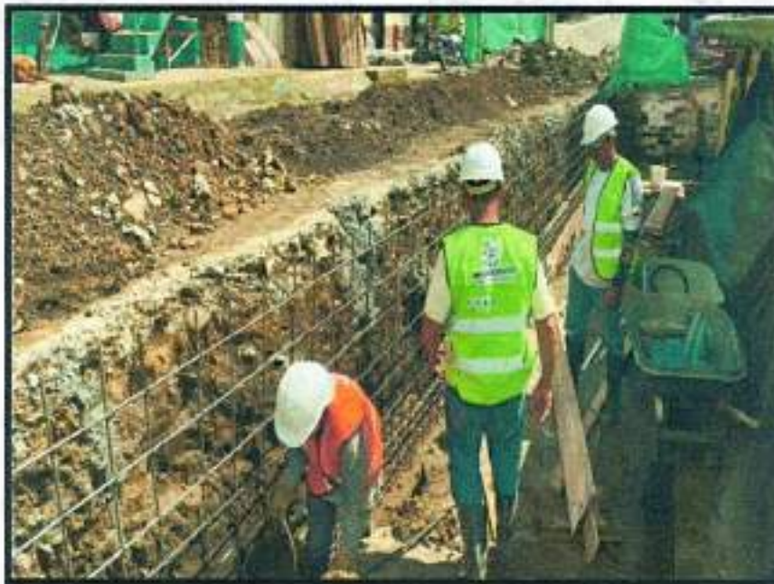
Fotografía Nro. 17. - figurado de acero
