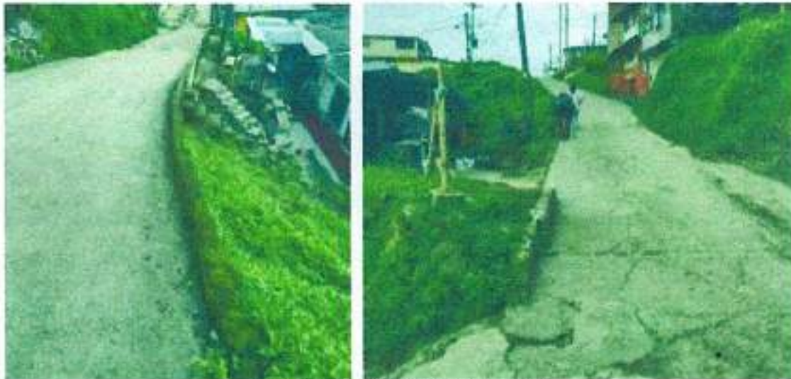
Ilustración 1. Condiciones iniciales del trinchero. Ilustración 2. Condiciones iniciales del trinchero.
