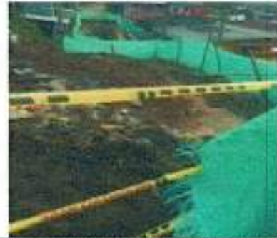
Reposición de cerramiento con Lona verde
