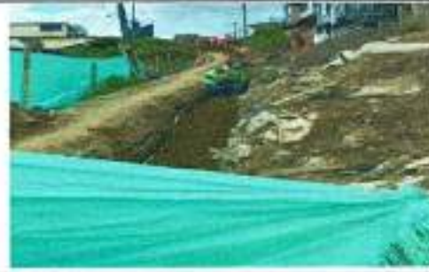
Cerramiento de obra
