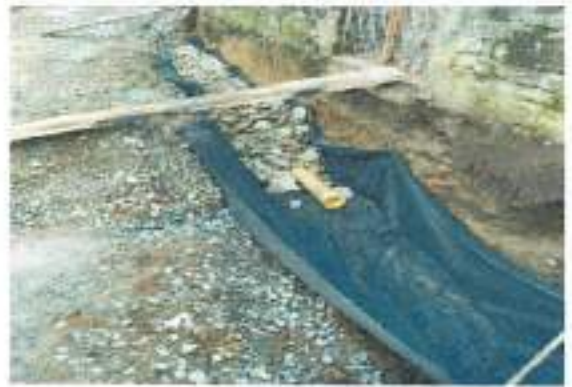
Avances de obra (filtro)
