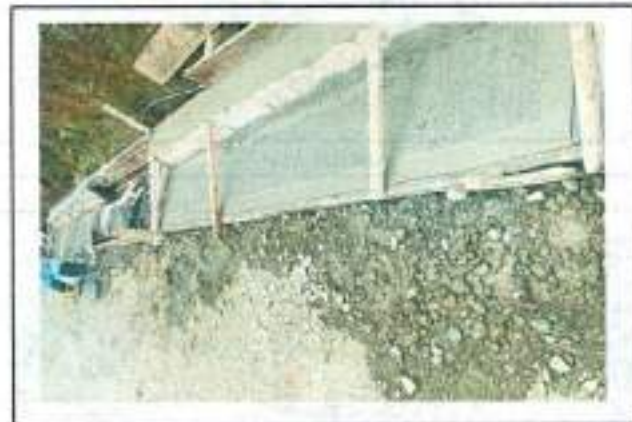
Avances de obra
