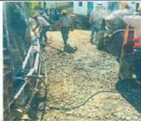
Avance de obra (baseo bordillos)
