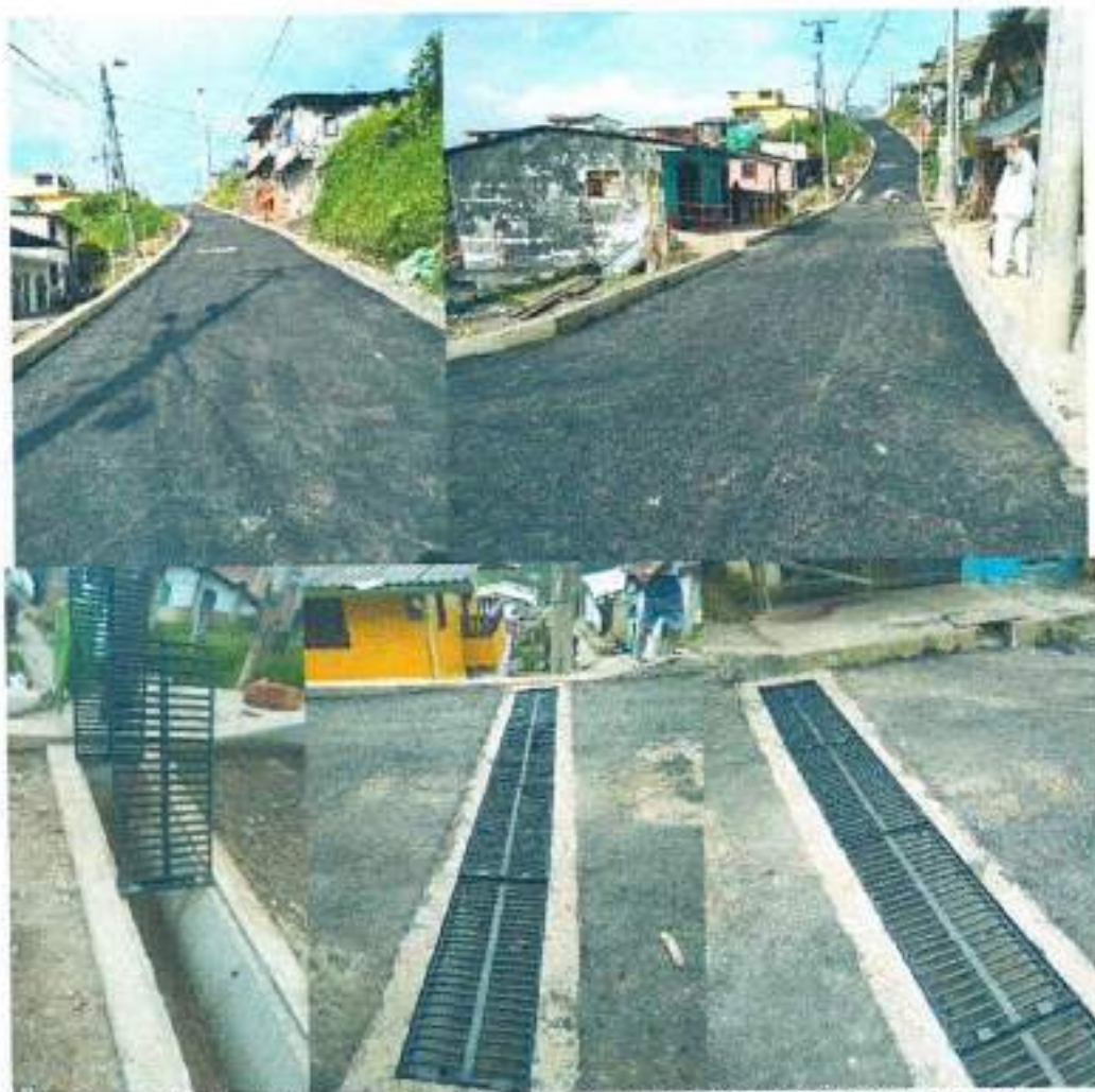
Instalación de rejilla en sumidero lineal, con calibre de 7/8" y espaciamiento de 3 cm.
