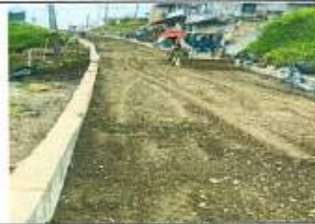
Instalación de base
