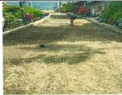
Compactación de base
