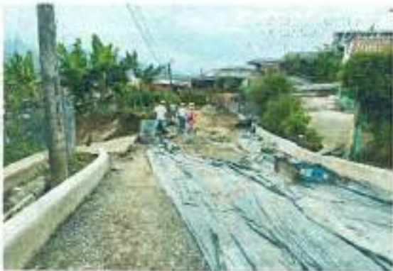
Avances de obra
