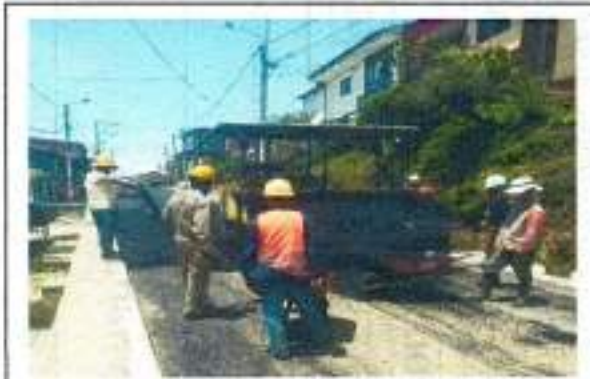
Uso adecuado de los epp durante la pavimentación
