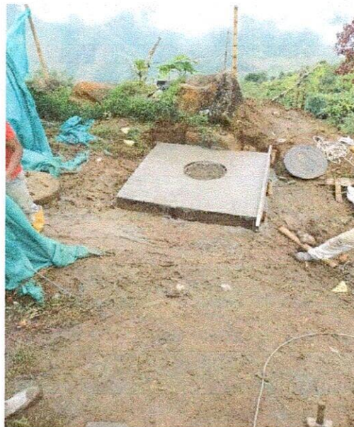
SUMINISTRO E INSTALACIÓN ARO DE TAPA
