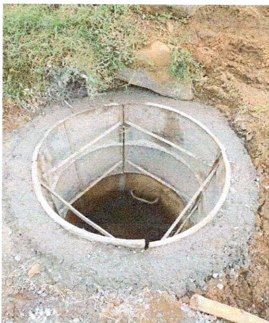
CAMARA DE CAIDA D=1.2m CON ESPESOR DE 0.2m
