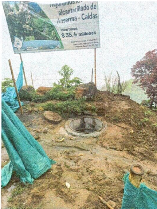
CAMARA DE CAIDA D=1.6m CON ESPESOR DE 0.2m
