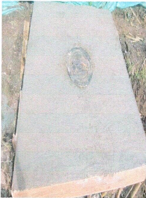
LOSA EN CONCRETO REFORZADA DE 2.0m X 2.0m X 0.2 m
