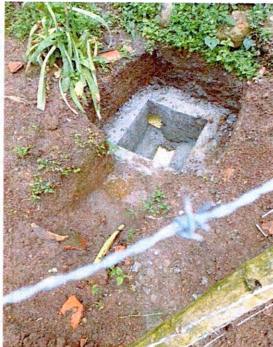
CAJA DE INSPECCIÓN 0.5m X 0.5m
