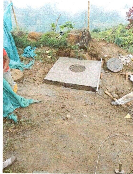
LOSA EN CONCRETO REFORZADA DE 1.6m X 1.6m X 0.2 m
