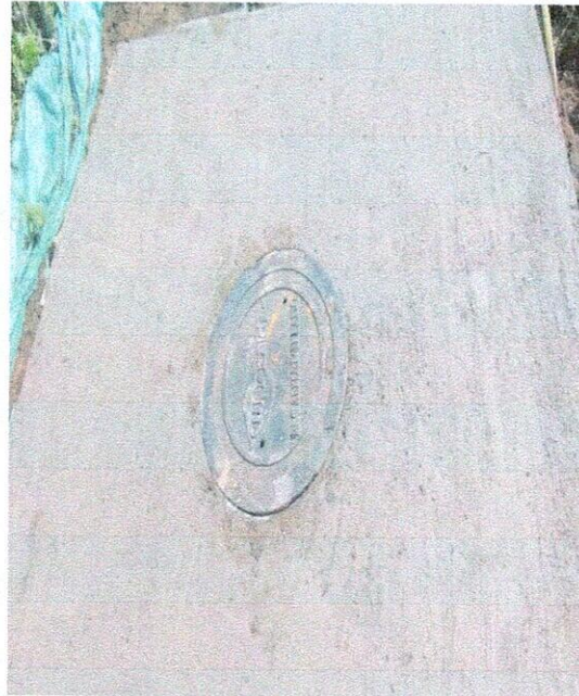
LOSA EN CONCRETO REFORZADA DE 2.0m X 2.0m X 0.2 m
