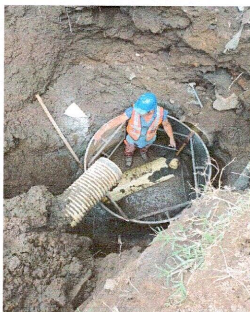
CAMARA DE CAIDA D=1.2m CON ESPESOR DE 0.2m
