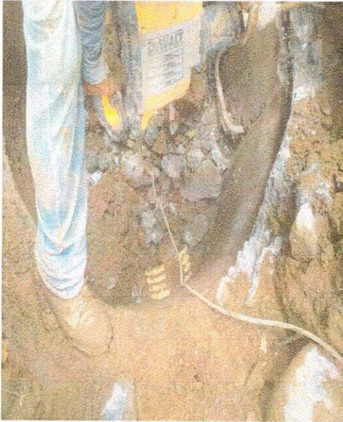
DEMOLICIÓN ESTRUCTURAS EN CONCRETO HIDRAULICO
