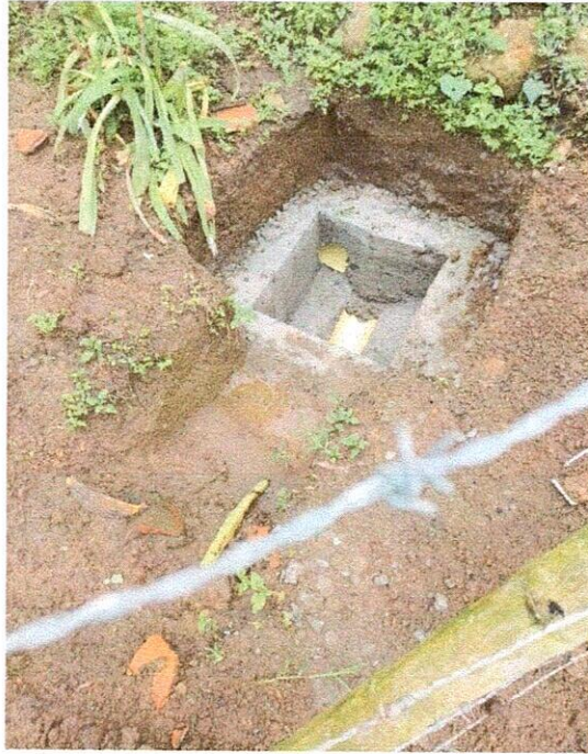
CAJA DE INSPECCIÓN 0.5m X 0.5m
