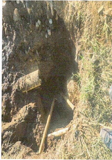
EXCAVACIÓN MANUAL DE MATERIAL COMUN Y CONGLOMERADO
