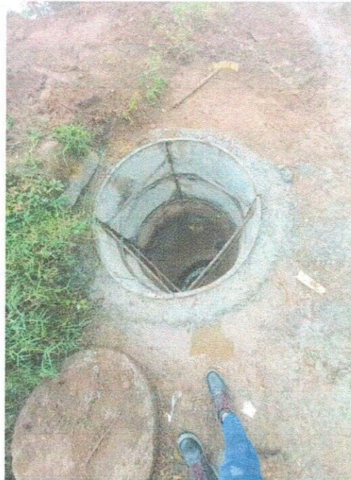
CAMARA DE CAIDA D=1.6m CON ESPESOR DE 0.2m
