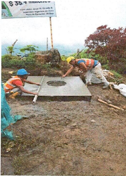
LOSA EN CONCRETO REFORZADA DE 1.6m X 1.6m X 0.2 m
