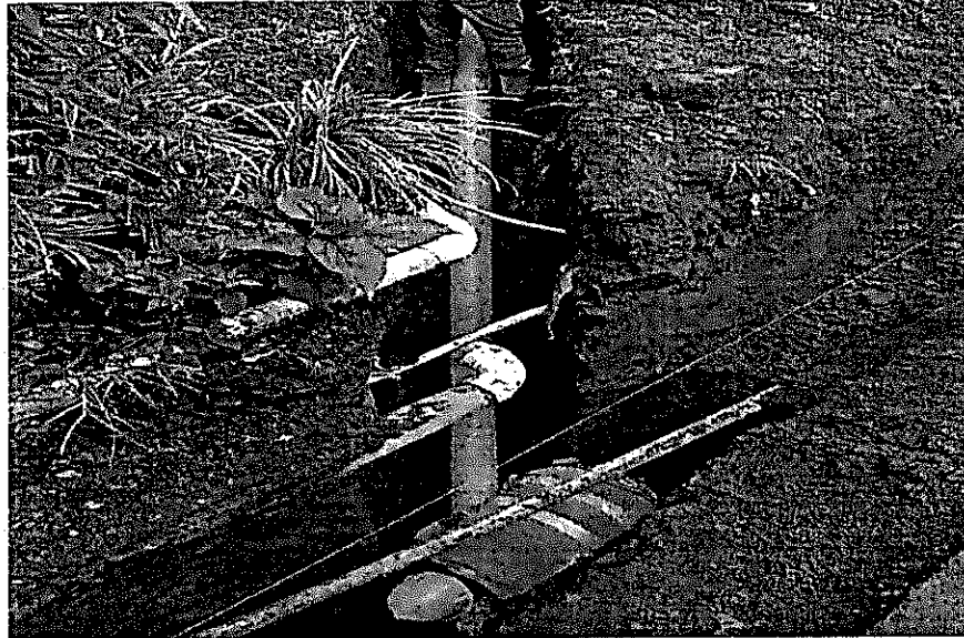
Instalación de Domiciliarias en tubería Novafort de 6"
