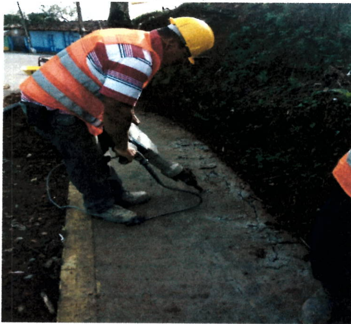
Demolicion de anden en Concreto y Pavimento en asfalto
