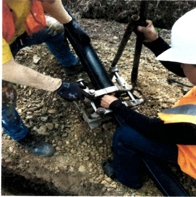
Instalacion de tuberia de polietileno de 4".
