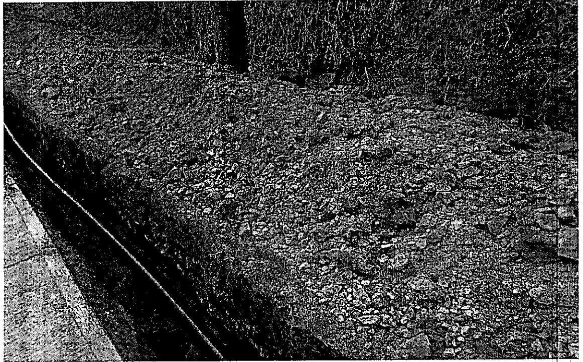
Instalación de Tubería de polietileno de 4" incluye sustitución en Arena
