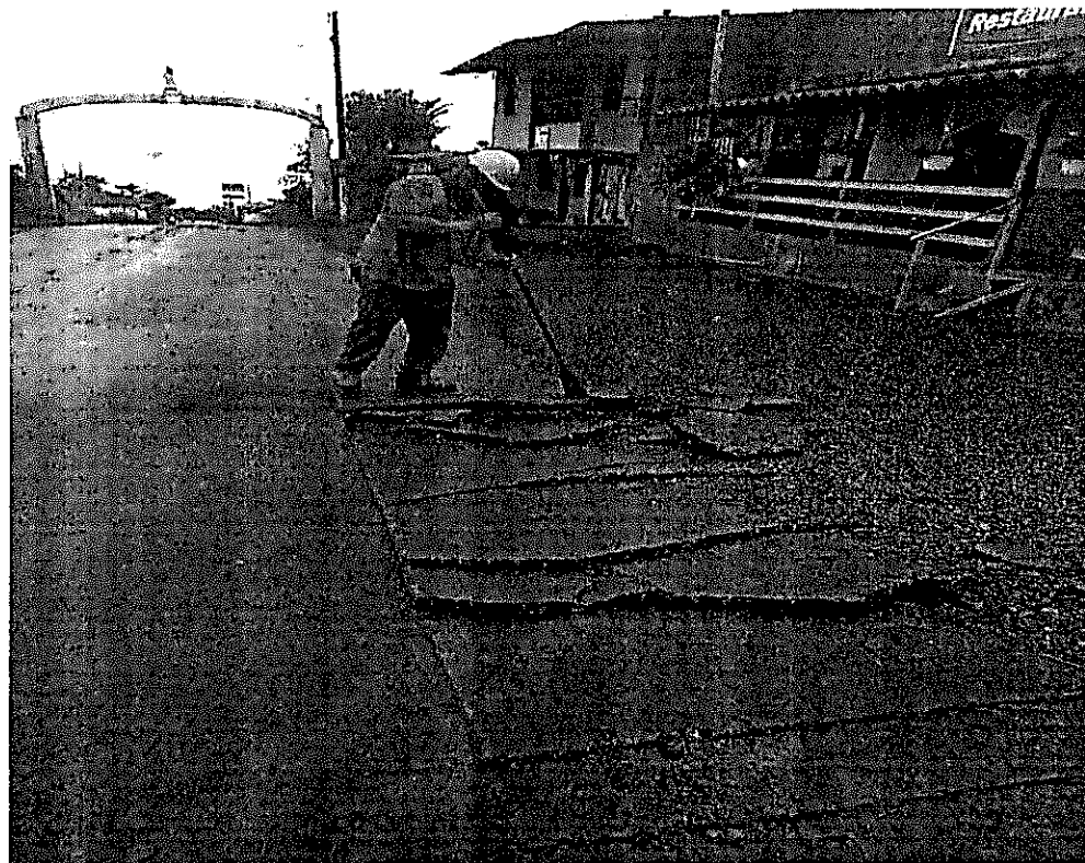
Demolición de Pavimento Asfáltico
