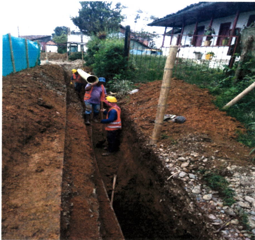
Instalación de tubería 10" red principal con base en arena.
