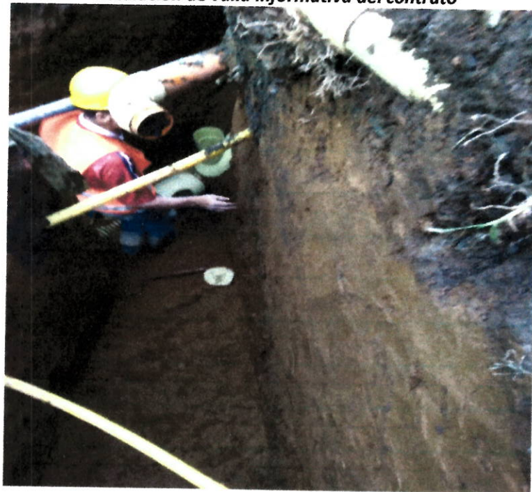
Instalación de silla yee domiciliarias.
