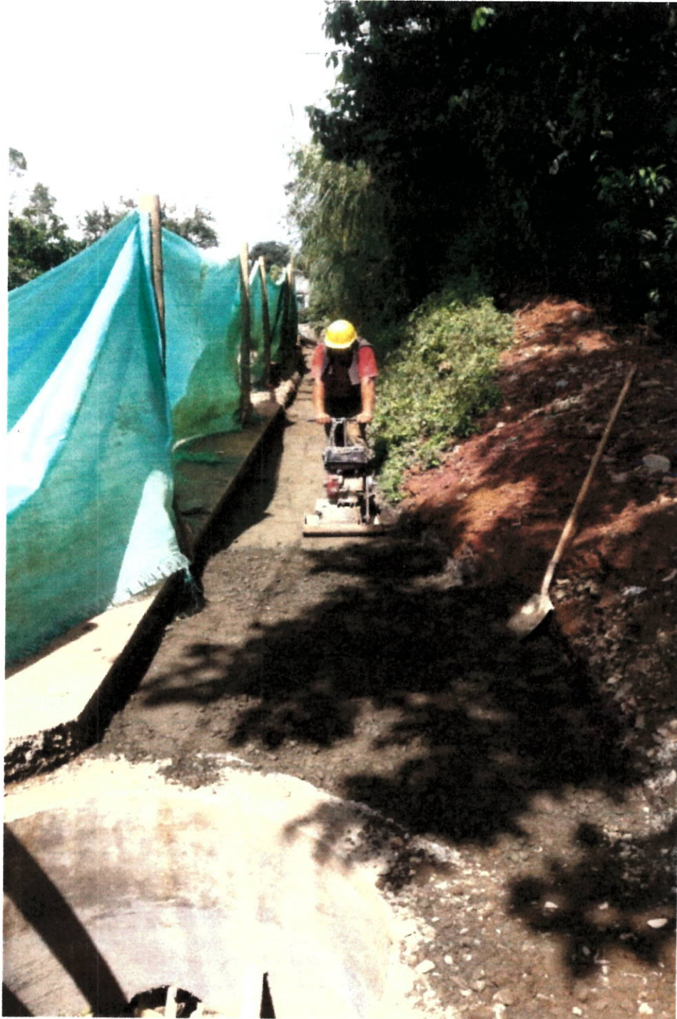
Instalación de Sub-Base y Compactación
