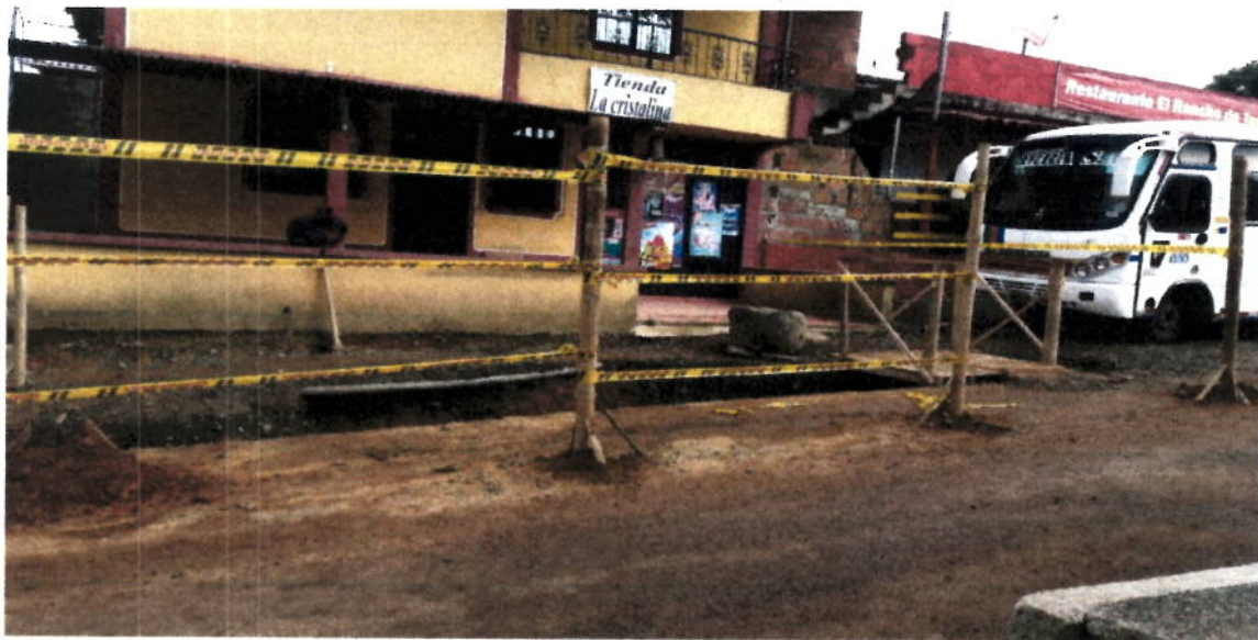
Señalización con cinta de Precaución
