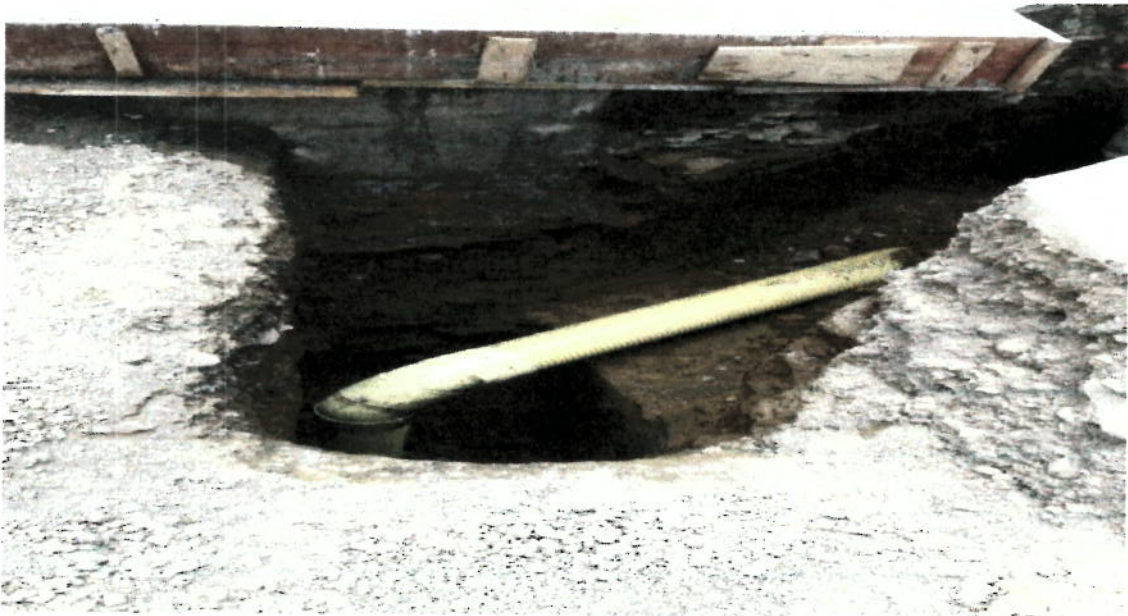
Instalacion de Silla Ye y codo de 90° para domiciliarias.
