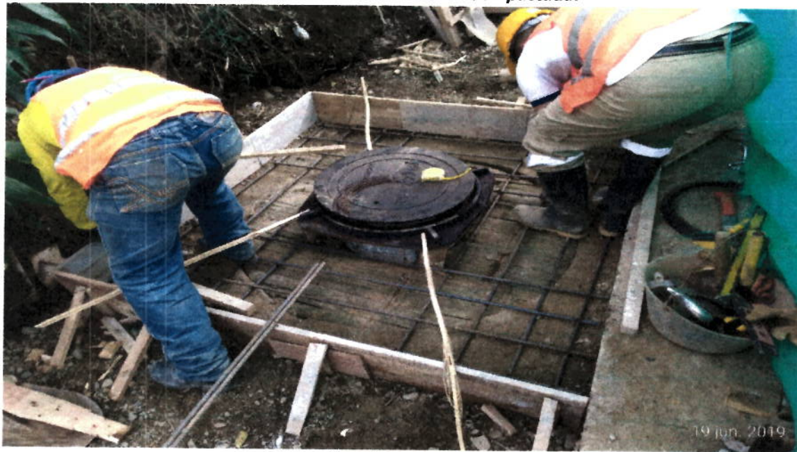
Acero de Refuerzo para Tapas.
