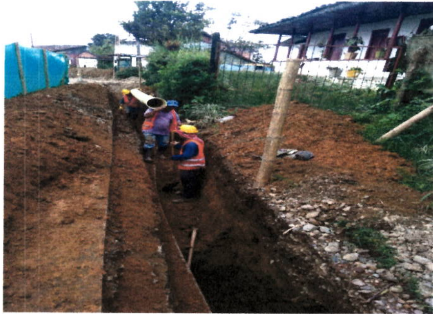
Instalación de tubería 10" red principal con base en arena.
