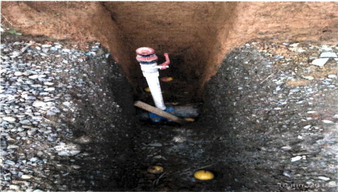
Instalacion de Ventosa.
