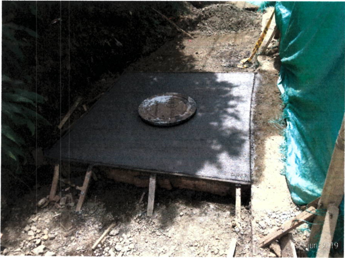
Instalacion de Concreto MR42 para Tapas.
