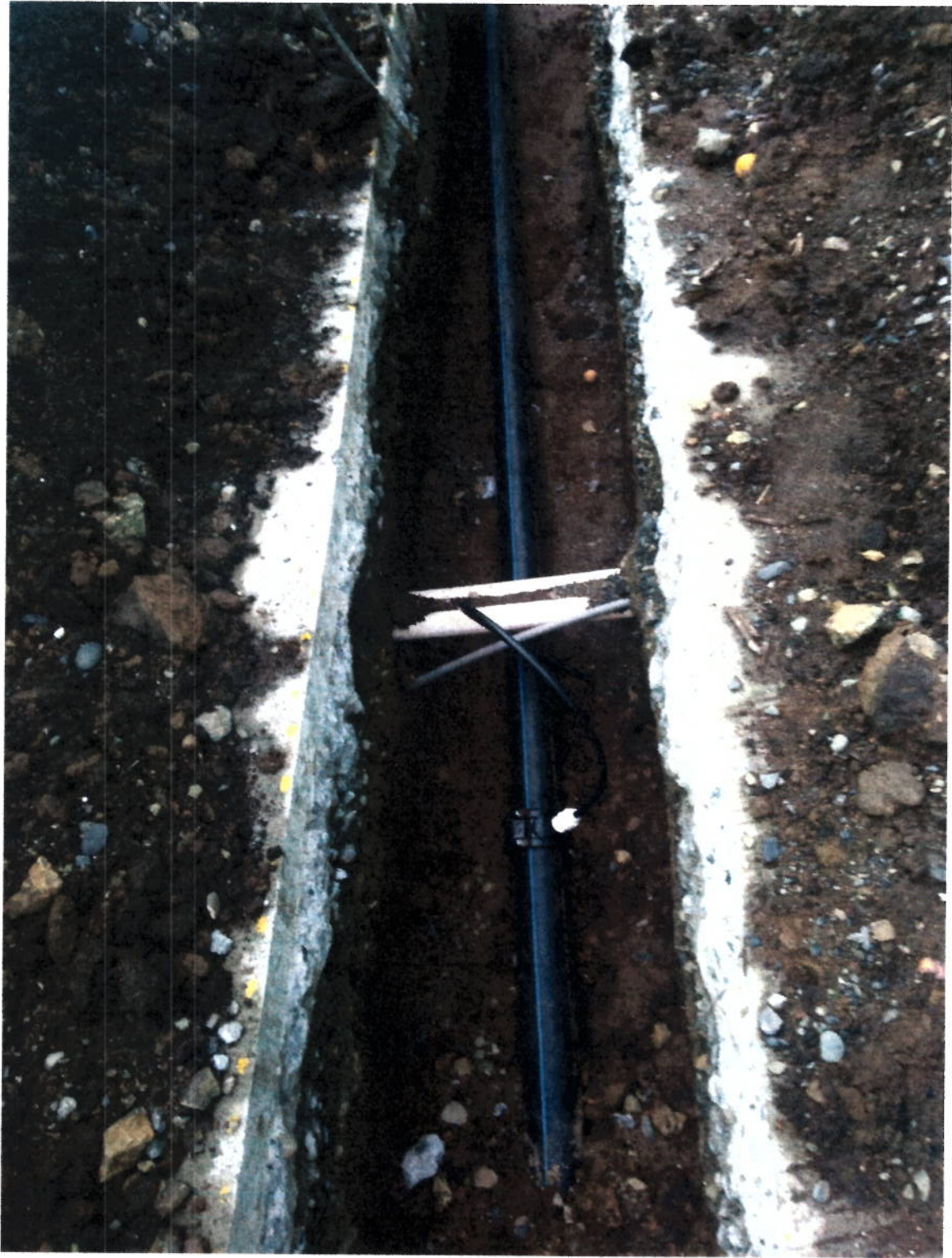
Instalacion de tuberia de polietileno de 4".
