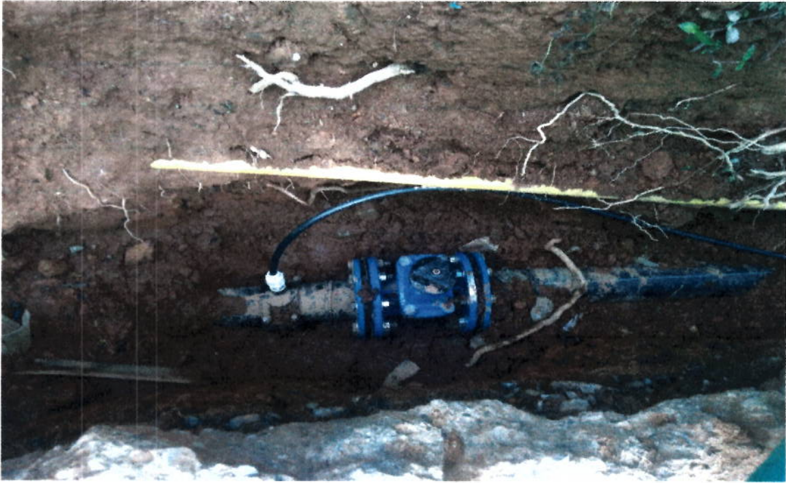
Instalacion de te, valvula y Empalme provicional.
