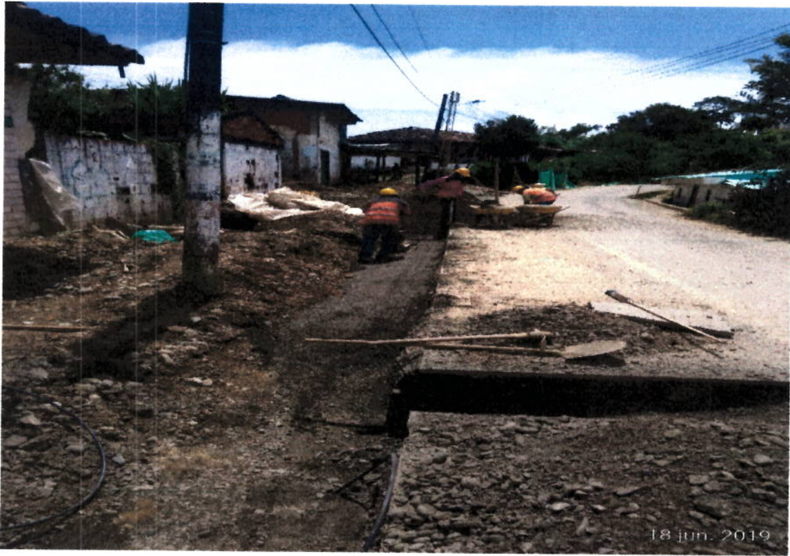
Instalacion de Base Granular Compactada.
