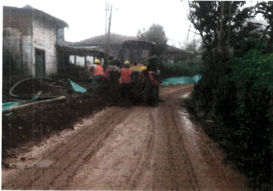
Retiro de Material Sobrante y Aseo de la Via
