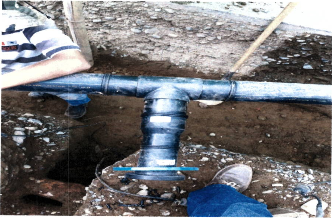
Instalacion de Tee de Polipropileno.
