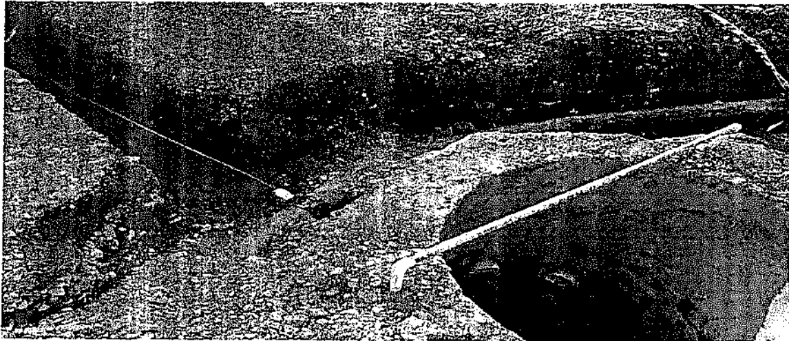
Instalación de Tubería PF 1/2"
