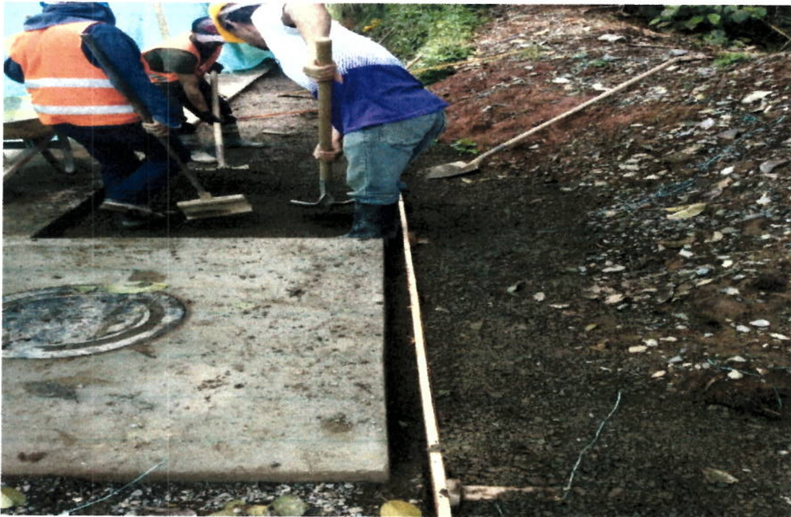
Instalacion de Base Granular Compactada y formaleta para Instalacion de asfalto
