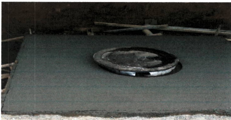
Instalación de Tapas HF para Pozos de Inspeccion.
