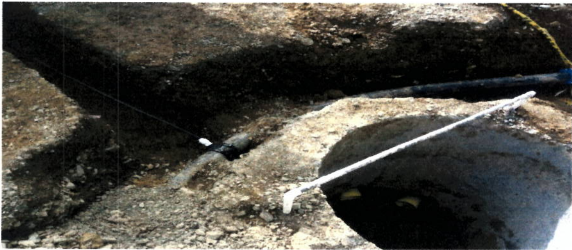
Instalación de Tubería PF ½"
