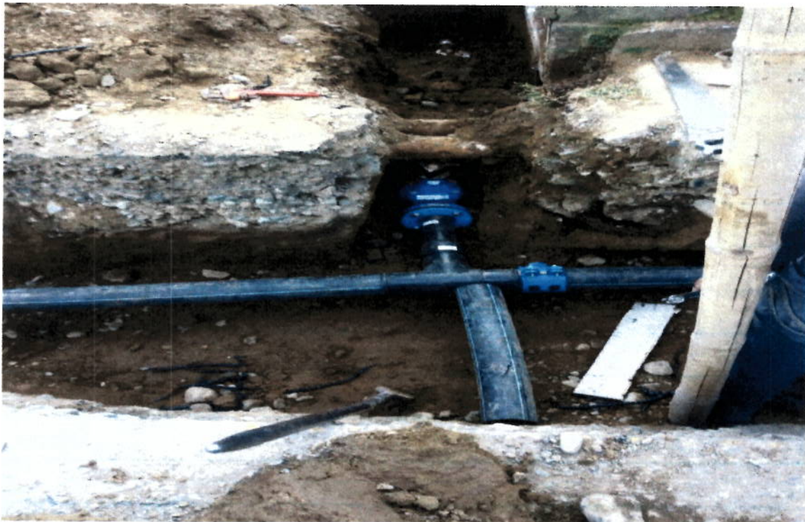
Instalacion de Valvula Cristo Rey
