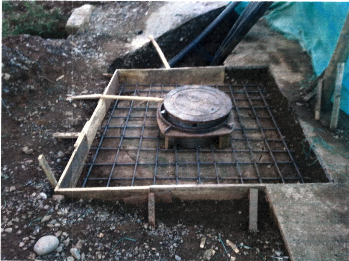
Acero de Refuerzo para Tapas.
