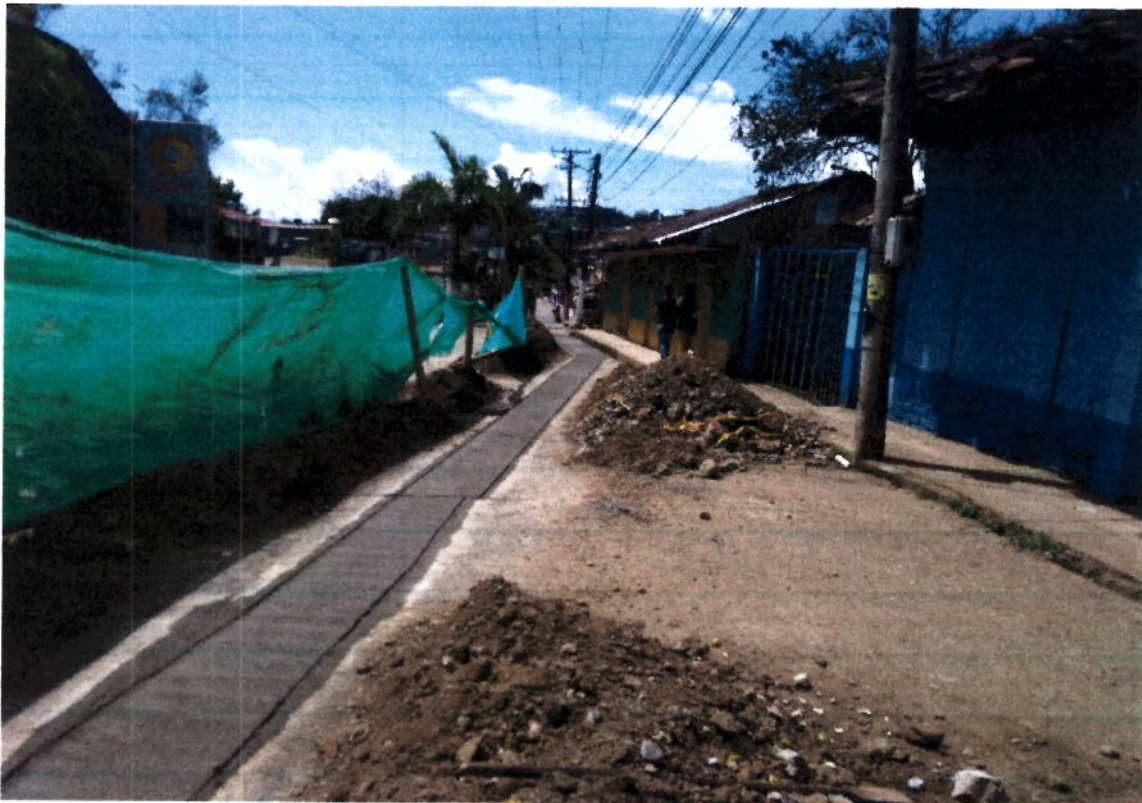
Instalación de pavimento MR42. Entrada a Cristo Rey y barrio Centenario
