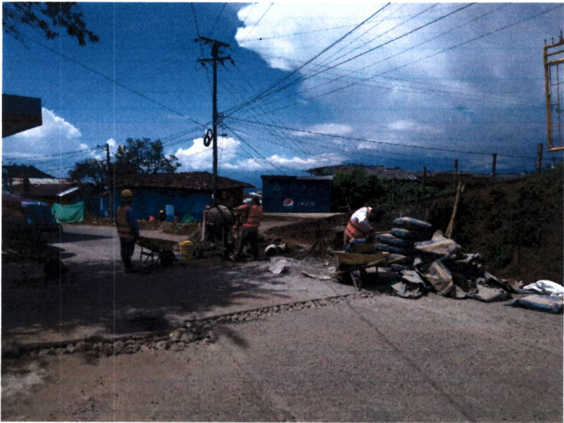
Vaceo de Concretos para vía.
