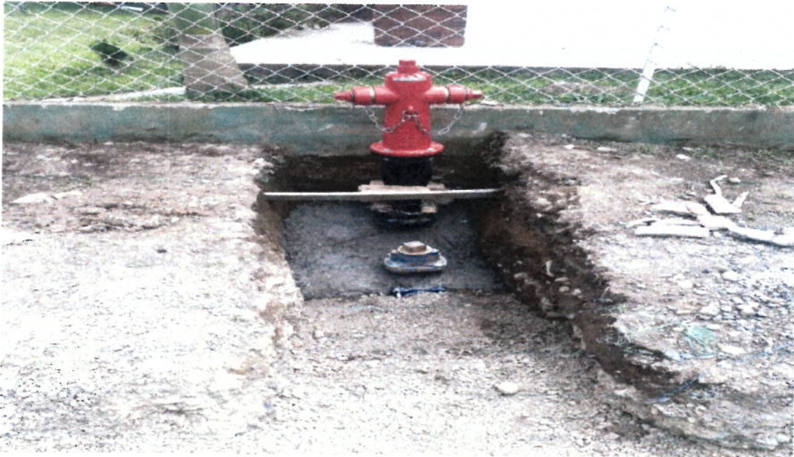
Instalacion de Hidrante.
