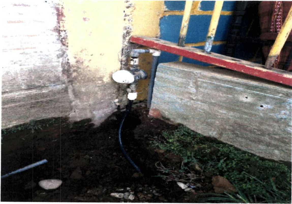
Instalación de Domiciliarias de Acueducto.
