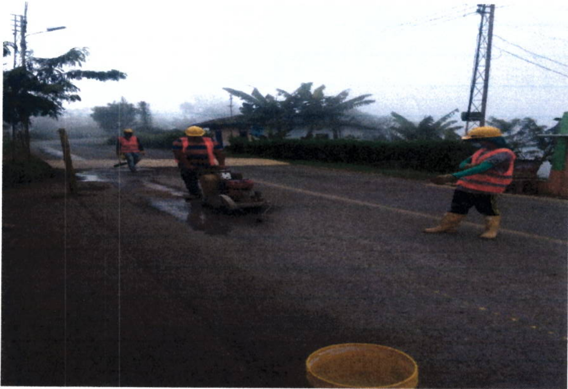
Cortes de Pavimento.
