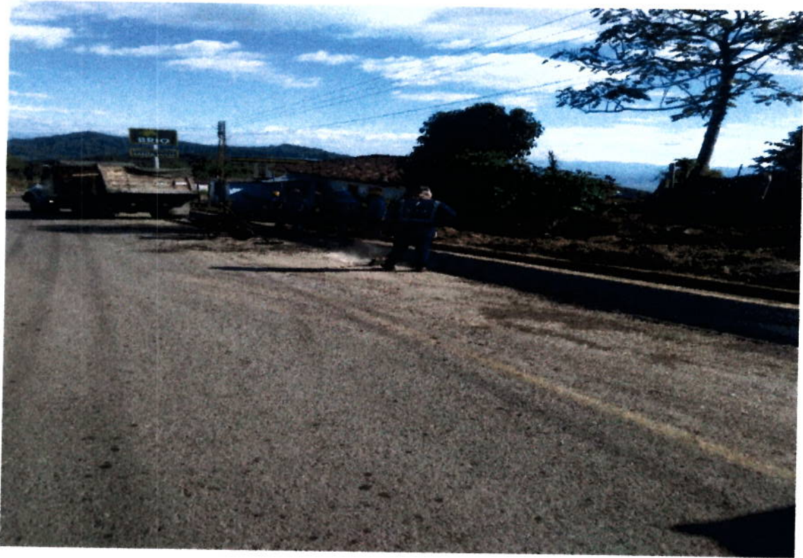
Instalación de Pavimento en Concreto Asfáltico
