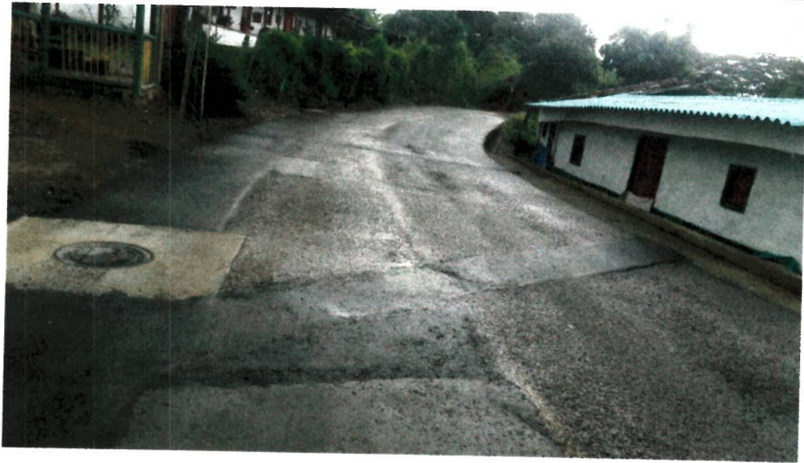
Panorámicas de la obra Finalizada
