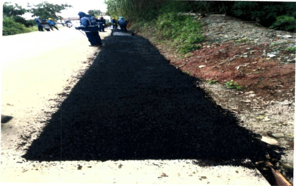
Instalación de pavimento MR42. Entrada a Cristo Rey y barrio Centenario
