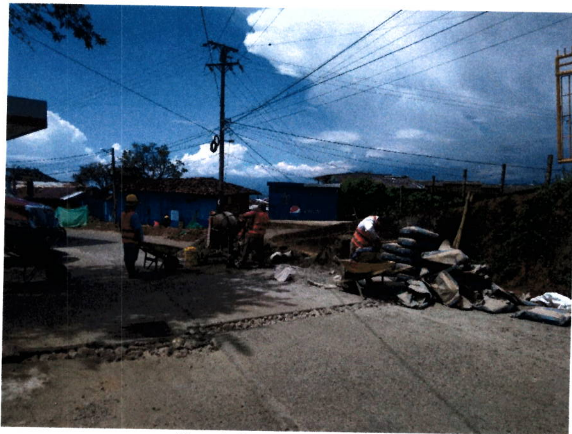
Vaceo de Concretos para vía MR42 .
