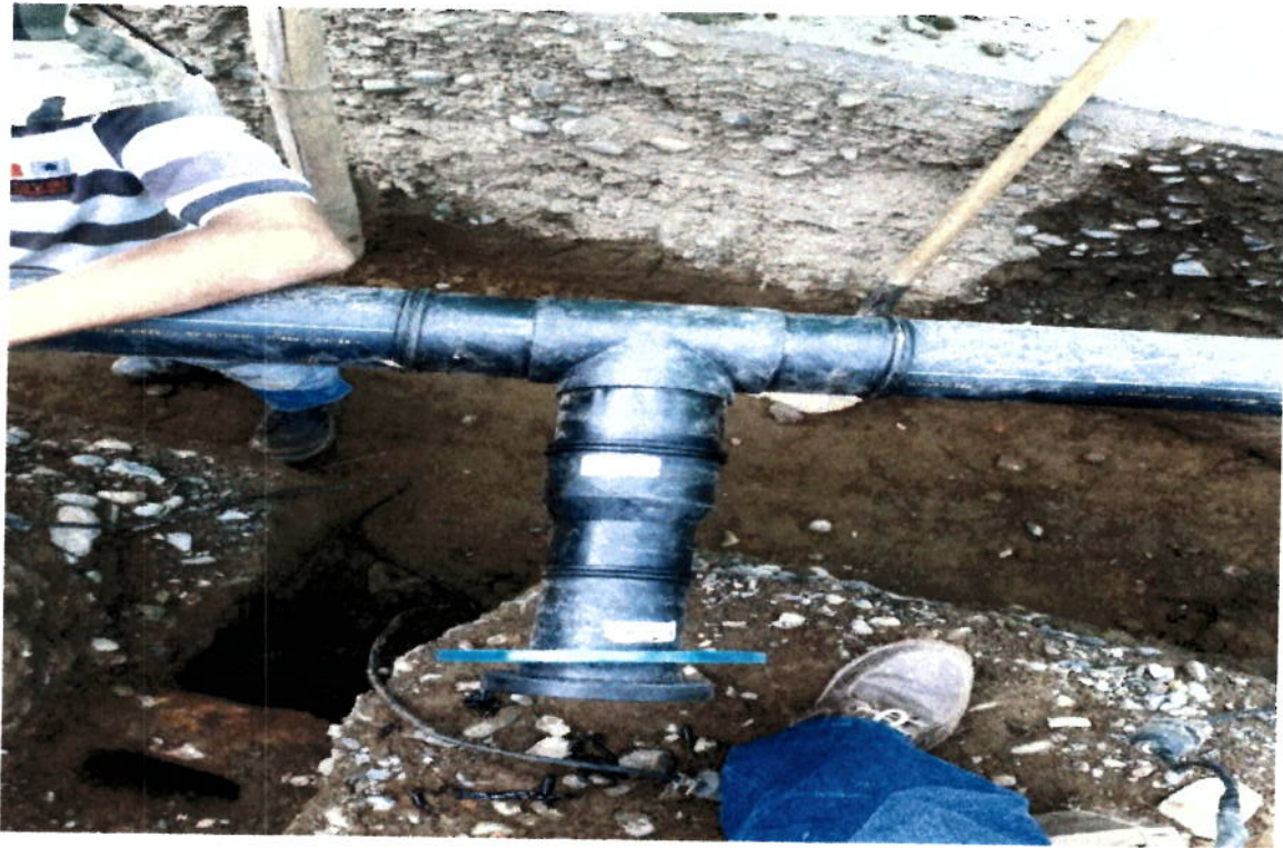
Instalacion de Tee de Polipropileno.
