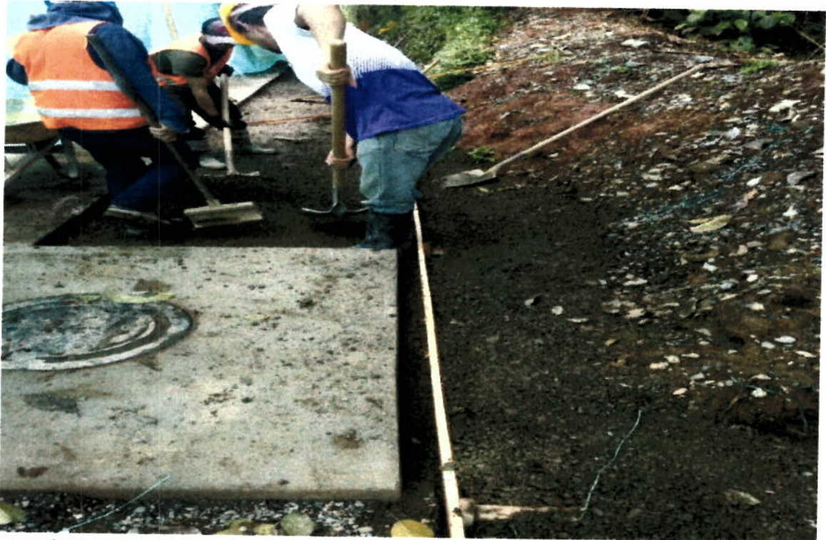
Instalacion de Base Granular Compactada y formaleta para Instalacion de asfalto
